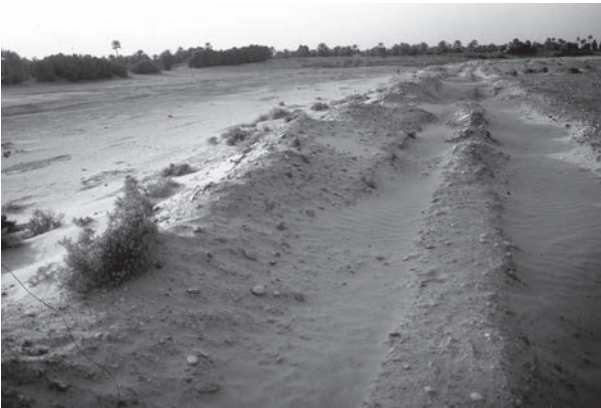
Fig. 12.5: Dégagement superficiel de la ligne de digue d'origine midrāride protégeant la ville de Sijilmāsa de l'oued Ziz (à gauche) réalisé par Lahcen Taouchikht en 1990 (cliché archives du MAPS – 1992)
