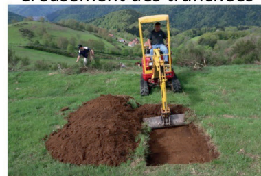
Creusement des tranchées
