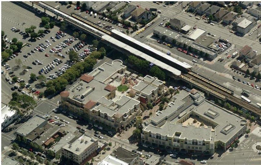
Le TOD de Fruitvale Village, à San Francisco, concilie aménagements denses et vastes emprises dévolues au stationnement à proximité de la station aérienne du BART (source : Bing Map)
