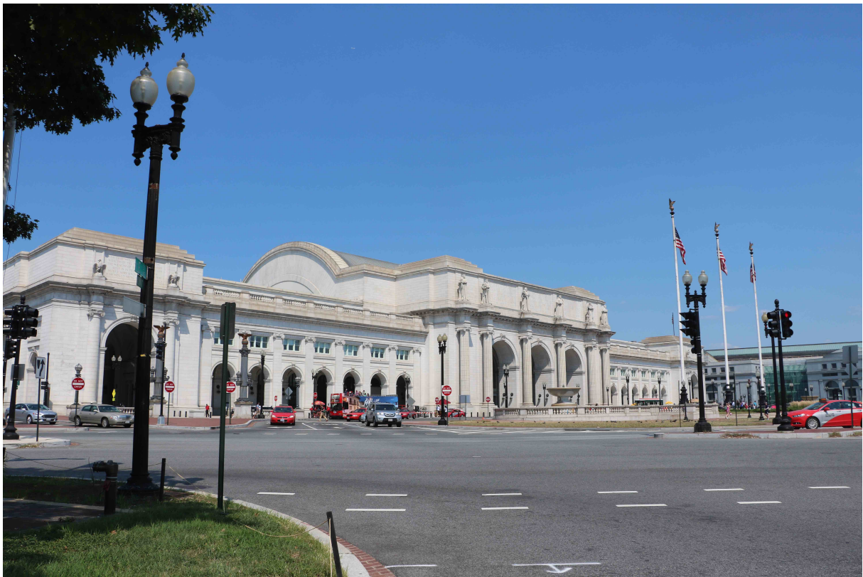
Couverture : L'entrée principale de la gare d'Union Station à Washington D.C. (Ruggeri, 2015)
