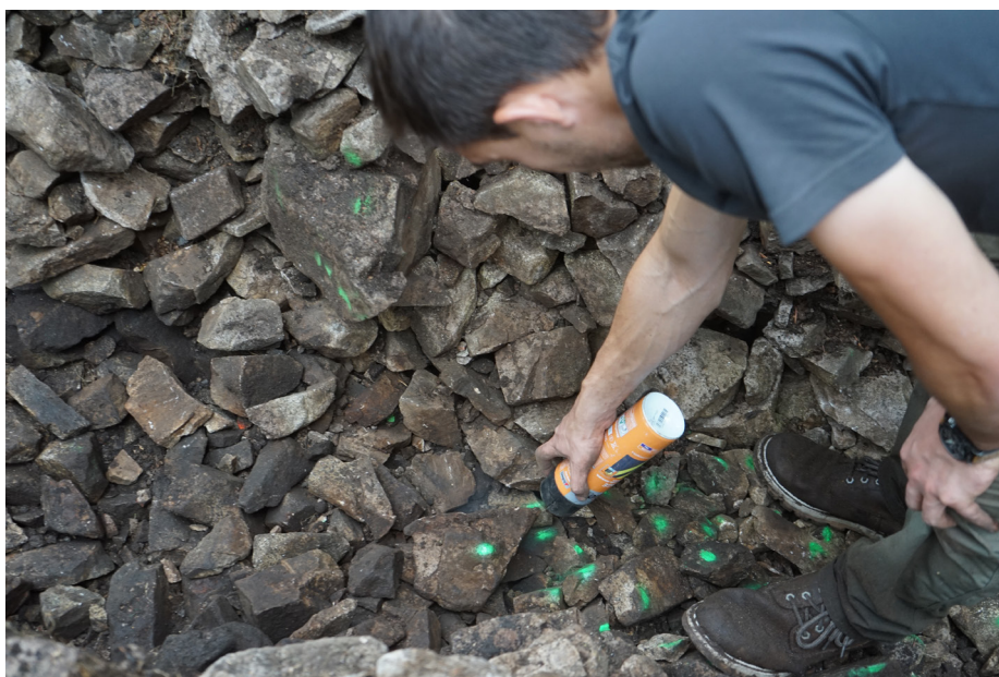
Cliché 1 : Démontage des structures
