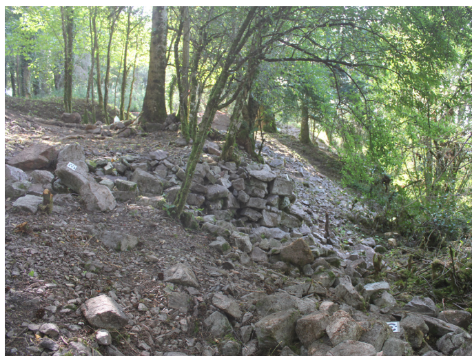
Cliché 11: Structure 4.3, parements est
