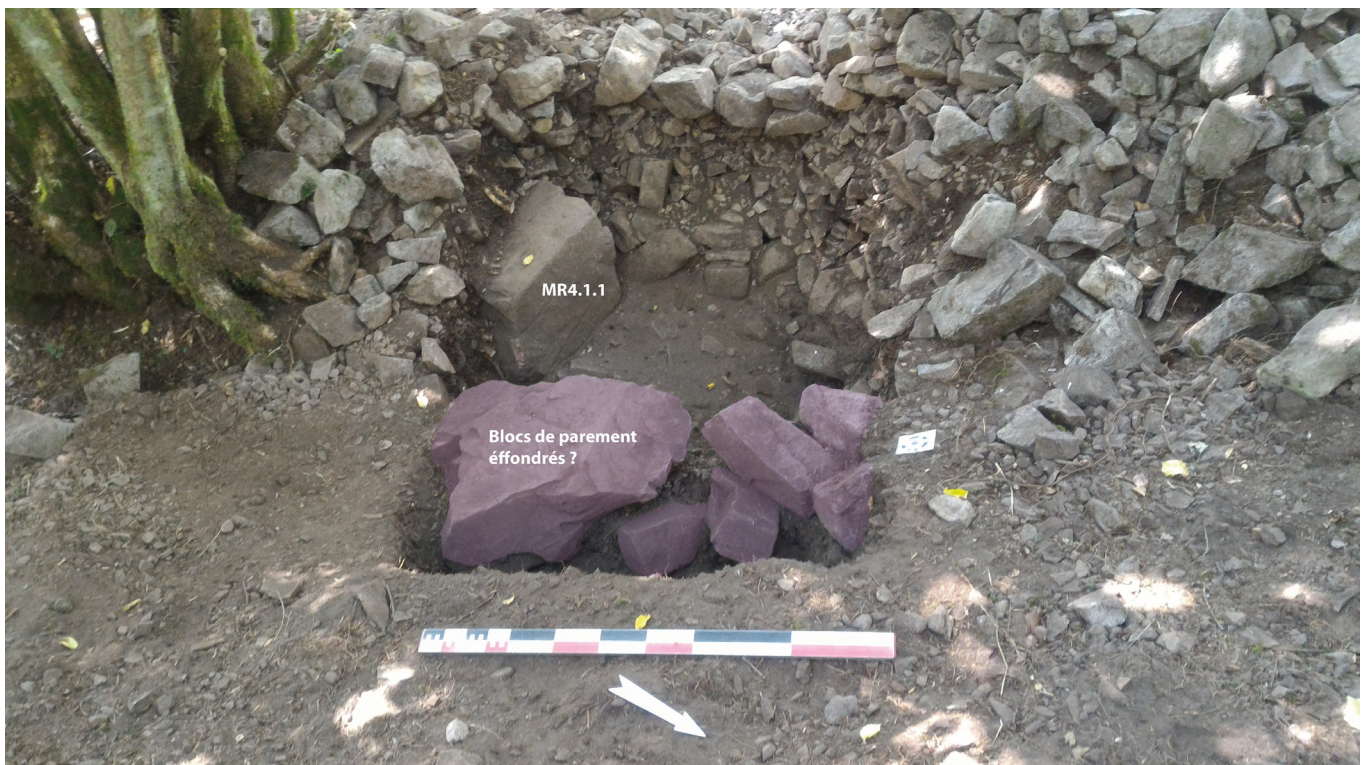
Cliché 18 : Vue du parement 4.1.1 depuis l'est - blocs effondrés
