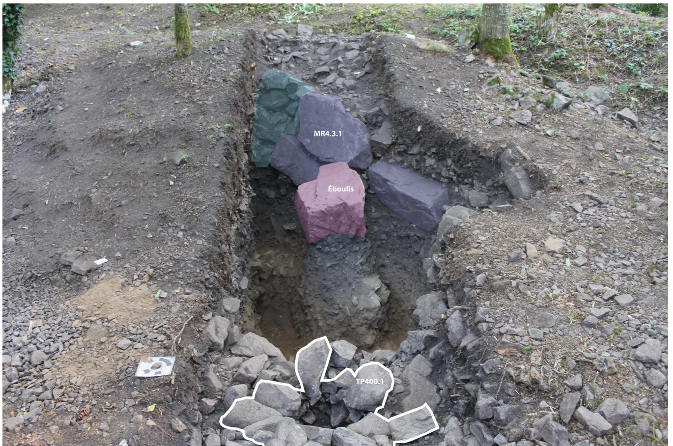
Cliché 26 : Vue des parements occidentaux depuis l'ouest
