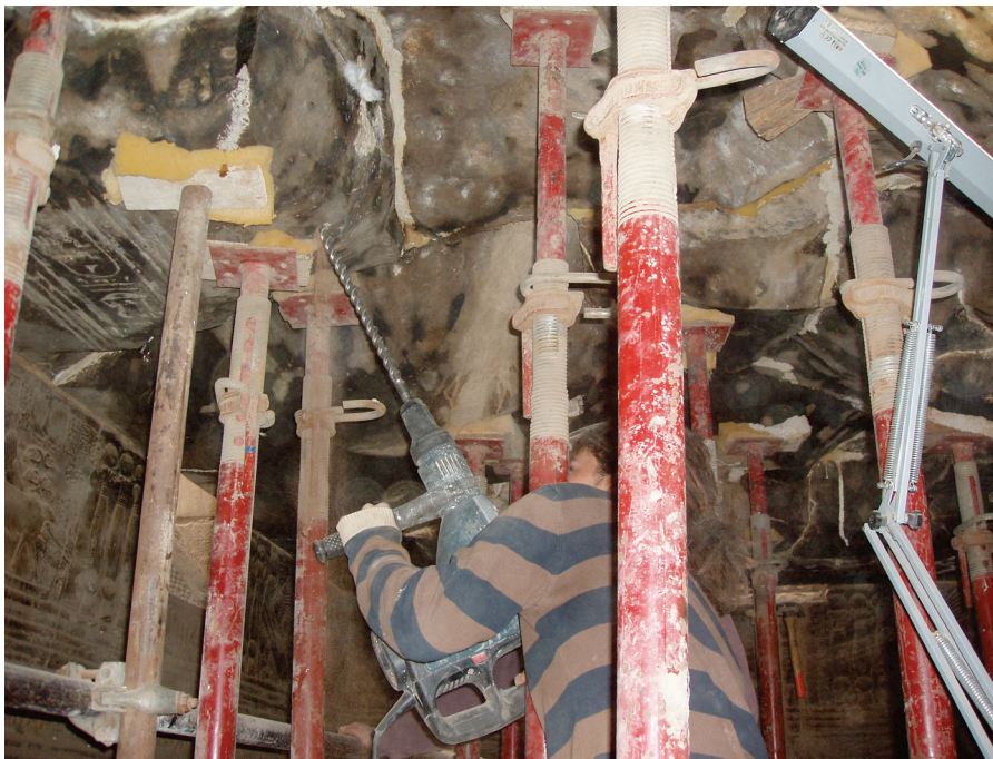
Fig. 13. Pour renforcer le plafond de la salle des offrandes des conduits sont percés afin d'y introduire des tirants métalliques. © Cnrs-Cfeetk/E. Laroze.
