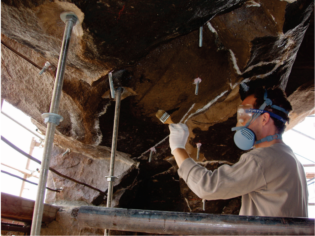
Fig. 10. Le linteau de la porte d'entrée. Une résine acrylique est appliquée sur les parties qui seront en contact avec le ciment afin de réduire les migrations de sel. On aperçoit, régulièrement répartis, les goujons qui permettront de fixer les armatures métalliques du béton. © Cnrs-Cfeetk/E. Laroze.
