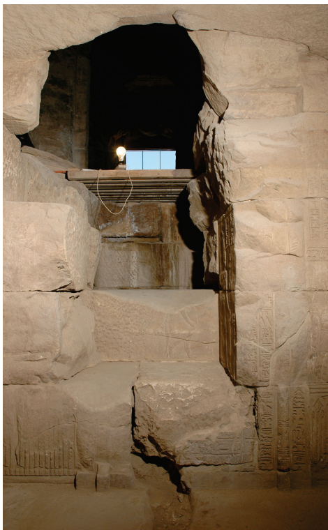
Fig. 4. La niche de soubassement avant sa restauration en 2006. © Cnrs-Cfeetk/Y. Stoeckel.
