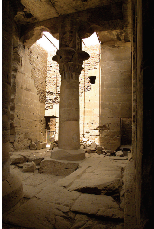
Fig. 7. La salle hypostyle en 2005 ; une partie du dallage a disparu, les architraves sont très détériorées. À l'arrière plan, le mur moderne en brique crue a été démonté au cours de l'été 2006. © Cnrs-Cfeetk/G. Pollin.
