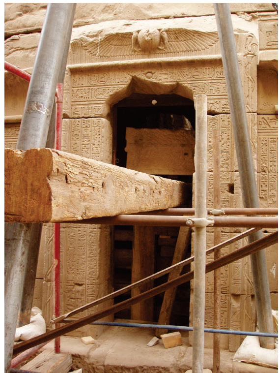
Fig. 5. Mise en place du nouveau linteau dans la niche de soubassement. © Cnrs-Cfeetk/E. Laroze.
