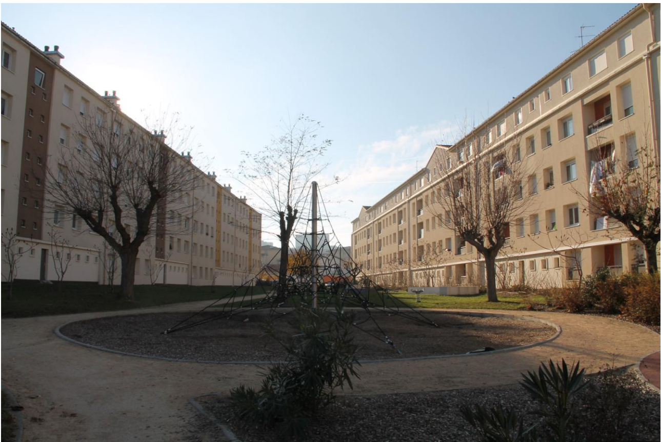
Fig. 6 – Bien que la surélévation change la perception de l'immeuble en installant une symétrie et en divisant l'immeuble en trois parties, l'isolation par l'extérieur des immeubles, le changement des baies et des garde-corps conservent à l'ensemble son unité architecturale. © Audrey Courbebaïsse.
