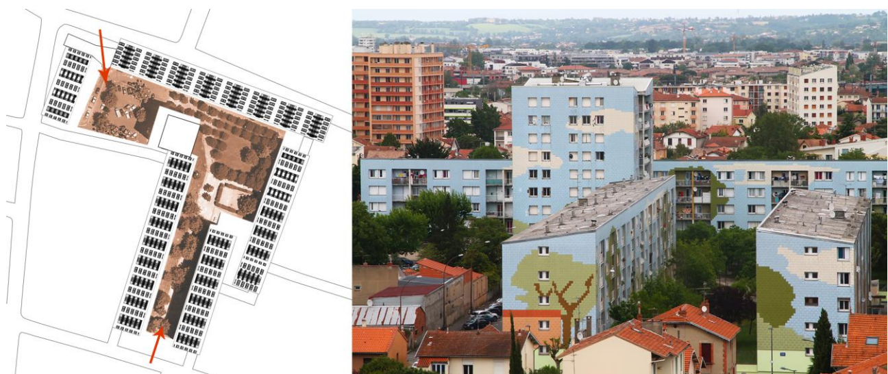
Fig. 4 – Les travées rythmées créent l'ordonnance sur le vide central de l'îlot. Elles sont obtenues grâce à la répétition symétrique des logements qui permet de regrouper par deux les loggias. L'ordonnance et les variations de rythme dans certains vis-à-vis d'immeubles sont aujourd'hui masquées par le revêtement uniforme et généralisé. © Audrey Courbebaisse.
