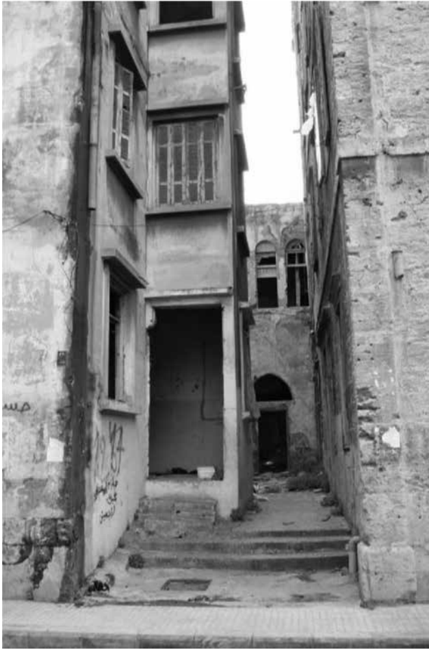
Fig. 5 : Rue du patriarcat syriaque. Bâtiments anciens conservés en cœur d'îlot malgré la densification des parcelles. Source : photographie de l'auteur (2009).
