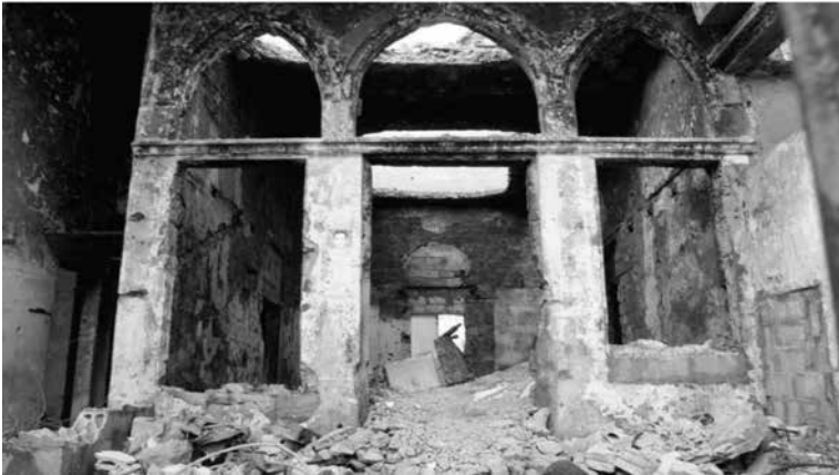
Figs. 7 et 8 : Immeubles en ruines et traces de leurs occupants successifs rue du patriarcat syriaque. Ces immeubles furent totalement démolis par leur nouveau propriétaire en 2011. Source : photographies de l'auteure (2007)
