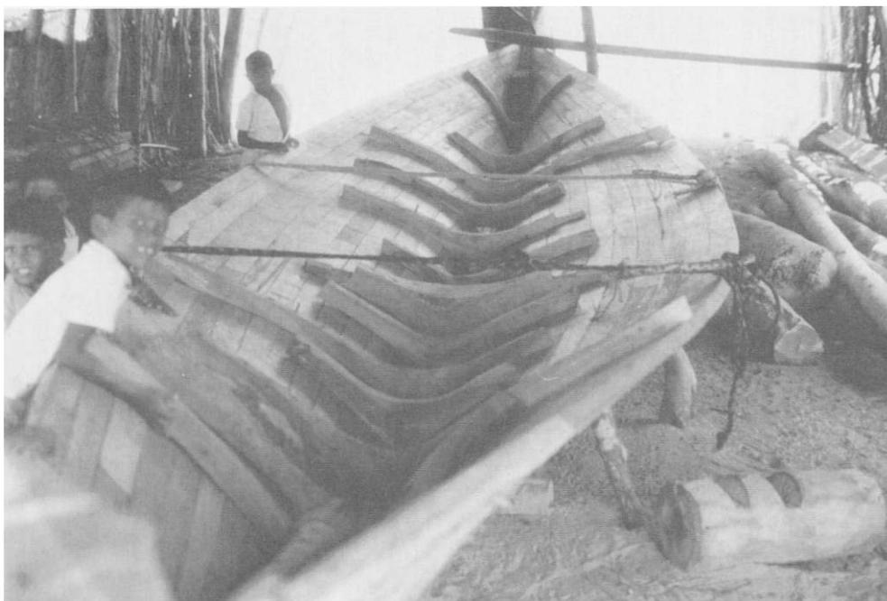
Photo 4. Phase intermédiaire de la construction de la coque : après 1 assemblage des virures du fond, les varangues ont été mises en place on remarque les cordages qui tiennent le tout en compression
