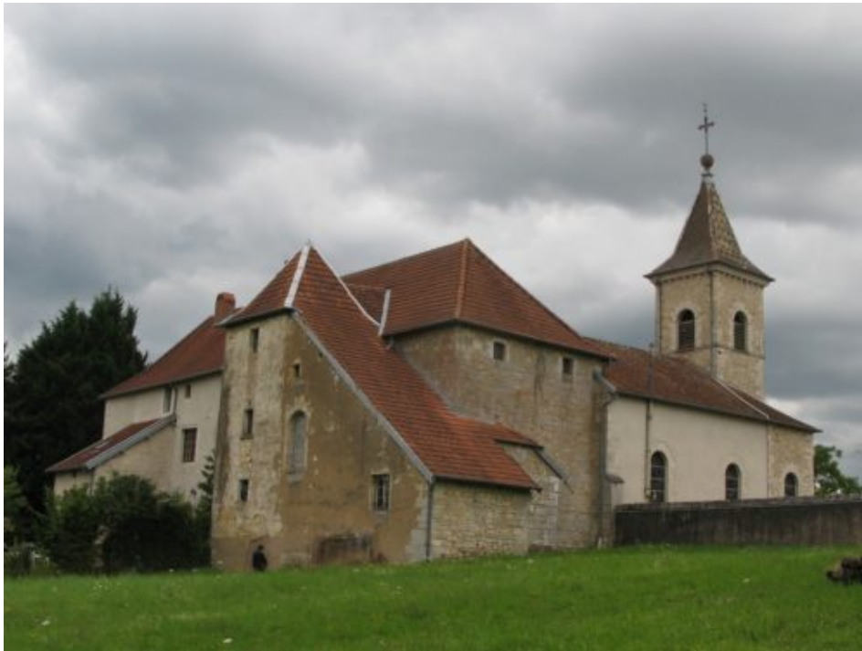
Angle nord-est de la commanderie hospitalière de Montseugny (70).
