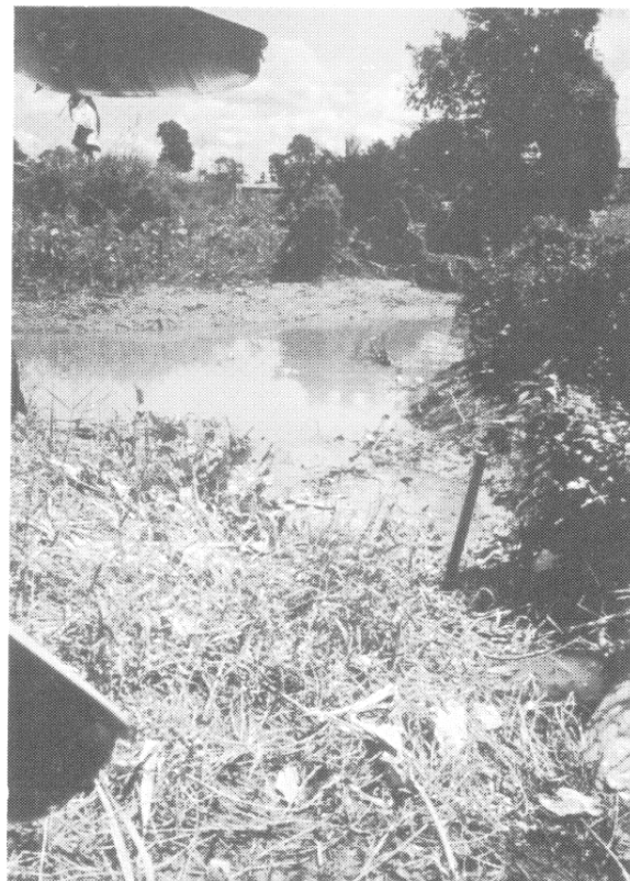
Fig. 10. — Canal de Suak Bujang (confluent avec la Sungai Rambutan).
