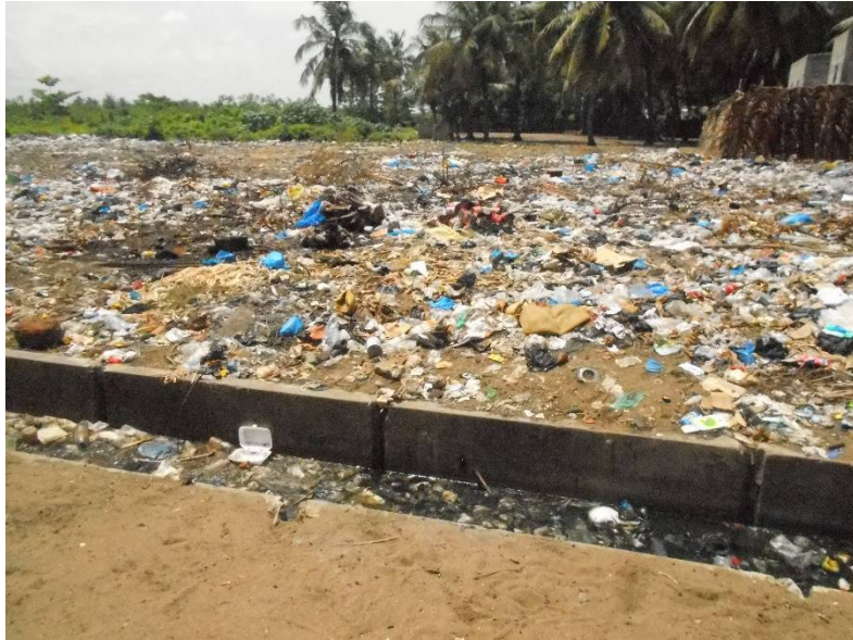
Photo 2 : Ouvrage d'assainissement obstrué par des déchets au petit marché
