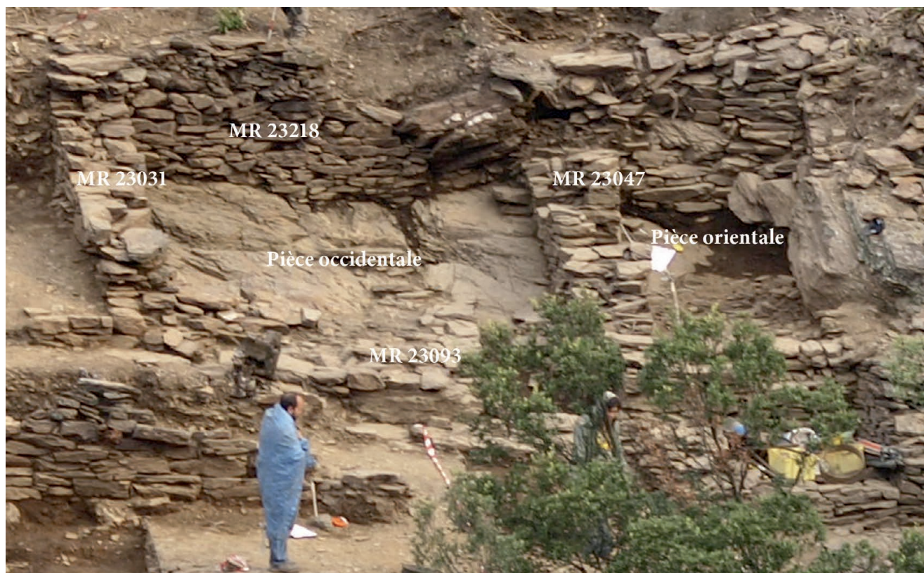
Fig. 48 Vue générale du bâtiment 23070 (cl. N. Minvielle).
