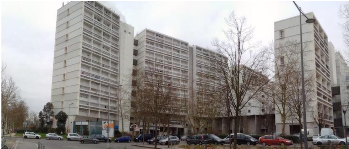
Figure 2. L'ensemble des Aubiers actuellement
