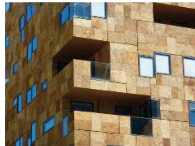
Fig. 2 - Square Pey-Berland (LAHAT architectes), détail (© Ch. Callais)
