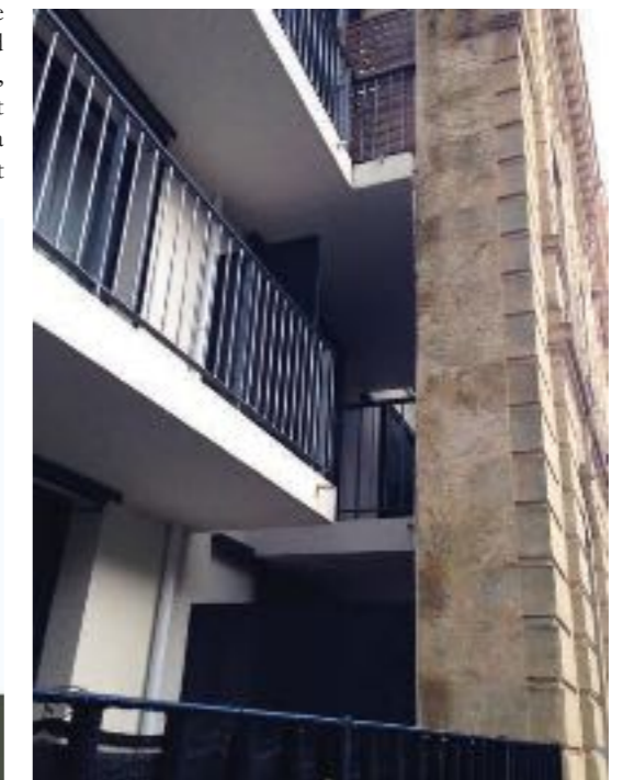
Fig. 6- Espace sombre entre la façade ancienne et l'appartement (© V. Caubet)
