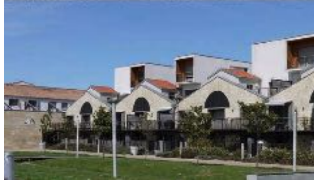
Fig. 5- À Village Bacalan, les anciennes façades sont ajourées et le contemporain émerge entre les pignons pour ponctuer et souligner l'ancien (© Leclercq & Associés / © Ch. Moneix)
