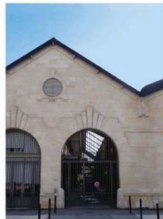
Fig. 5 - Ouvrir ses coquilles côté pour lui redonner vie : du chai reconverti en logements par Canal Architecture (© M. Dando)
