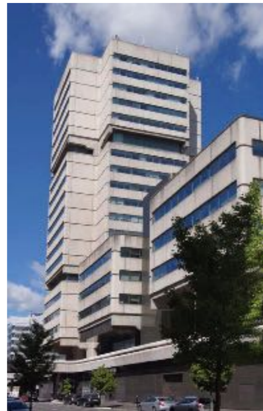
Fig. 5- La « tour de la CUB », maintenant métropole, aux tailles de guêpe épaissies, avec son extension et son entrée principale redescendue sur la rue. (© Ch. Callais)
