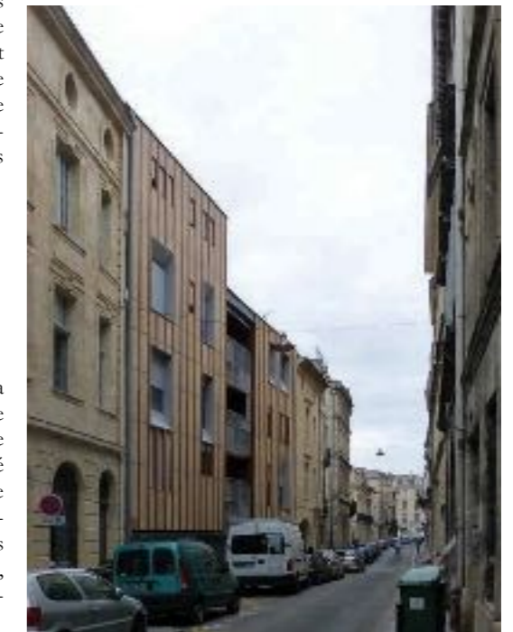
Fig. 1- Le rythme de la façade fait référence au rythme vertical des ouvertures des bâtiments voisins (© Th. Jeanmonod)
