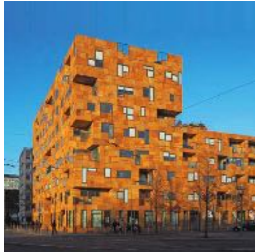
Fig. 1 - Square Pey-Berland (LAHAT architectes). Une utilisation de la pierre qui perd de son sens quand celle-ci n'est pas locale, revêtant une teinte hors contexte (© A. Herbert)
