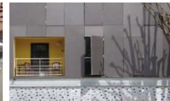
Fig. 8- Les volets mobiles du Stadion par un jeu modulent la façade au cours de la journée (©A. Bousignes)
