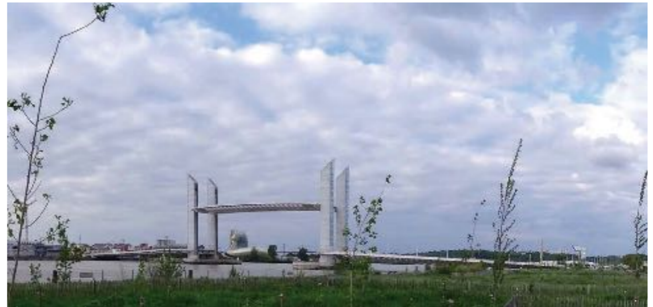
Fig. 1 - Le pont Chaban-Delmas (Lavigne et Chéron architectes), désormais porte du Port de la Lune depuis l'Océan (© Ch. Callais)
