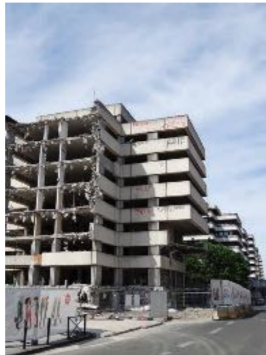
Fig. 8- Destruction de la tour la Croix-du-Mail : quels critères pour la démolir ? (© Ch. Callais)
