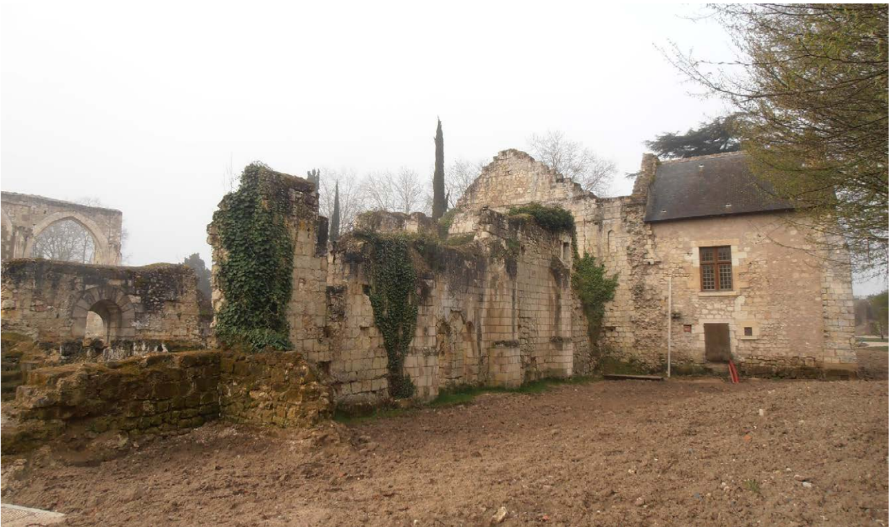
Photo 240 : le « régulier » vu du nord-est
