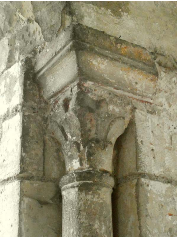
Photo 136 : colonnette du déambulatoire
