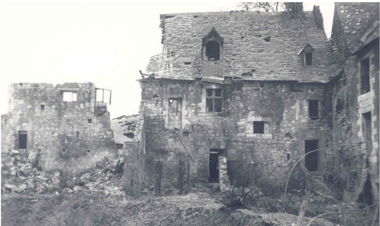
Photo 236 : les restes du « régulier » en 1951, après les bombardements de 1944 (vue du nord)
