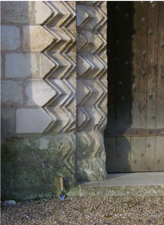
Photo 273 : détail sur la moulure occidentale de la porte d'entrée du réfectoire. Les deux assises inférieures, protégées par le remblaiement du 15 e siècle, n'ont pas été trop abîmées et ont pu échapper à la restauration
