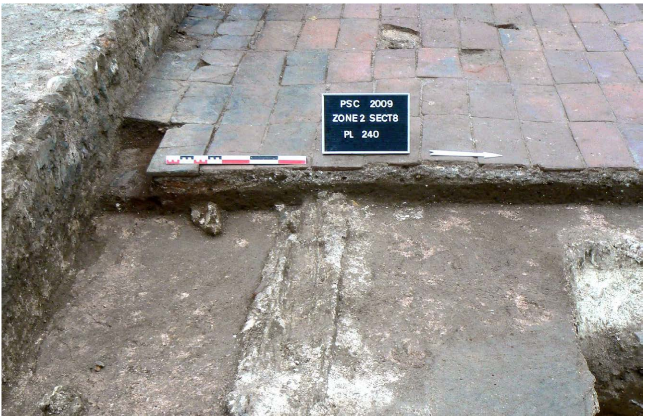
Photo 154 : le bourrelet de mortier F 1087 fossilisé sous le sol F 1028 (vue de l'est)
