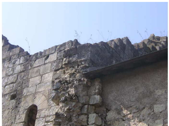
Photo 185 : détail de l'angle nord-est de l'extrémité nord de l'aile orientale du carré claustral, montrant notamment les contreforts d'angle et l'épaulement du fronton du pignon (vue du nord-est)
