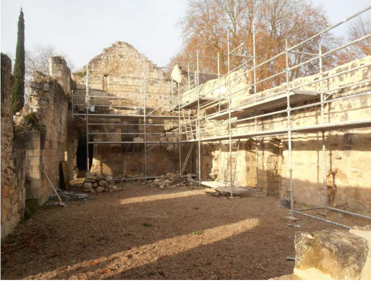
Photo 246 : l'intérieur du « régulier » en cours de restauration (vue vers l'ouest)
