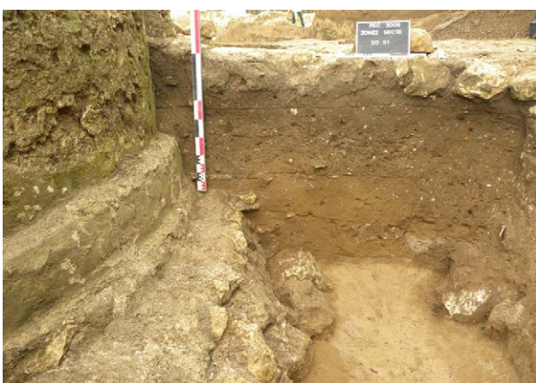
Photo 39 : la fondation de l'abside de l'église n°2 (M 51), côté externe, vue du sud (sondage n°51)
