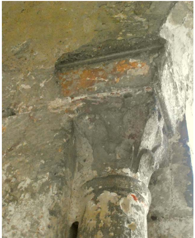
Photo 137 : colonnette du déambulatoire
