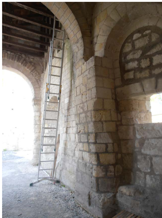
Photo 127 : le raccord sur le contrefort EA 230 de la voûte du déambulatoire au niveau de la jonction entre la travée droite et le début du couloir annulaire (côté sud de l'église, vue de l'est)
