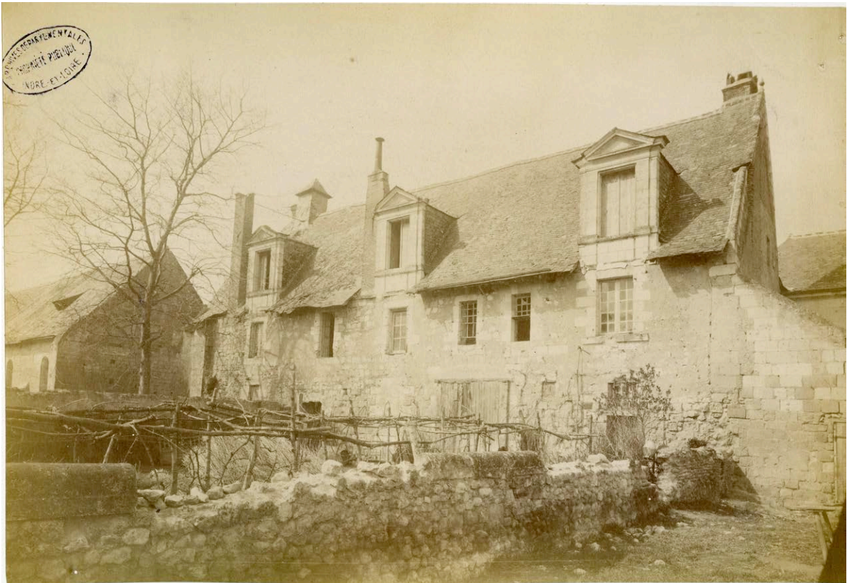
Photo 235 : le « régulier » en 1891, façade sud. A droite de la photo se voit clairement l'appentis accolé au pignon oriental, dont le mur visible est celui de l'extension de l'hôtellerie / infirmerie au 14e siècle (M 232). Tout-à-fait à droite apparaît la porte qui mettait cet appentis avec un petit bâtiment servant de buanderie au 18e siècle, disparu depuis (cliché Boutineau, avril 1891, FRAD037 13 fi276 ; même cliché dans le fonds ancien de la Bibliothèque municipale de Tours, IC 876)
