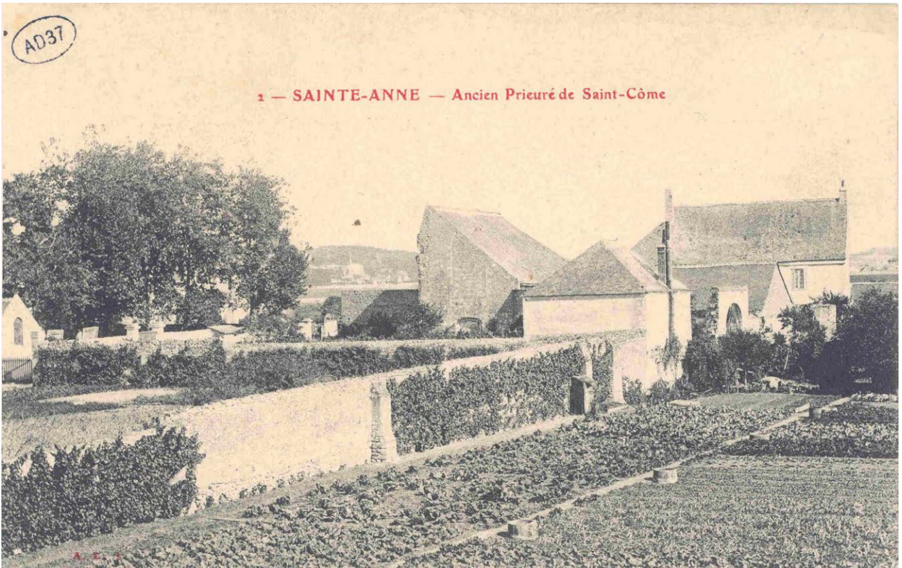
Photo 356 : vue générale du prieuré depuis le sud-ouest. De droite à gauche : le logis du prieur, le portail d'entrée, la porterie du 18 e siècle, le transept sud de l'église couvert d'un toit en appentis ; le régulier, l'hôtelier et le réfectoire sont derrière le bosquet d'arbres (FRAD037 10fi195_49)
