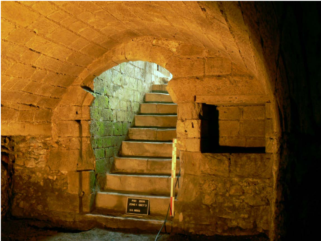
Photo 296 : la cave le long de l'église, sous le logis du sacristain (vue de l'ouest)
