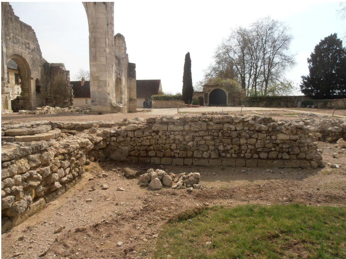
Photo 228 : l'angle sud-est du cloître en cours de restauration en 2014 (vue du nord-ouest)
