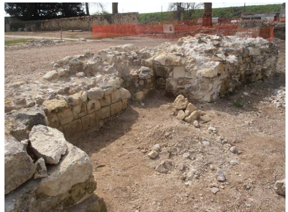
Photo 92 : le mur gouttereau nord de l'église, partie ouest. Derrière le gros massif de fondation de la tour d'escalier de l'époque gothique apparaît un contrefort de l'époque romane (vue prise en mars 2014, lors du piquetage et purge des maçonneries en vue de leur restauration)
