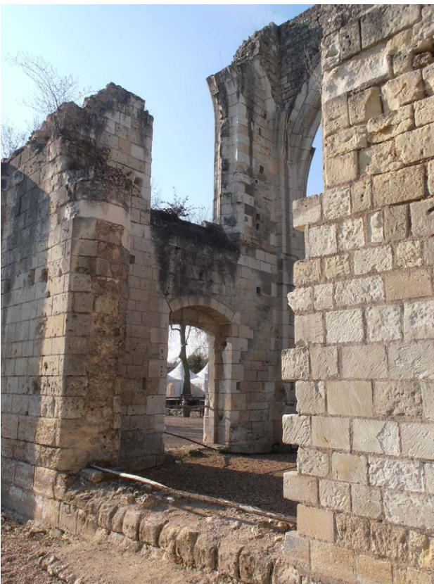
Photo 312 : le transept sud de l'église n°5 vu du sud-est
