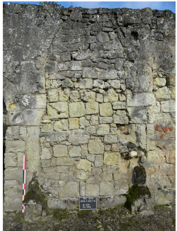
Photo 245b : la cheminée orientale du « régulier » EA 1368 (vue du sud)
