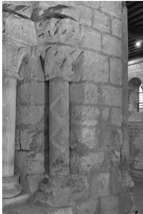
Photo 206 : les colonnettes de l'embrasure de la fenêtre est de l'abside de la chaire du lecteur (EA 1217, piédroit sud)
