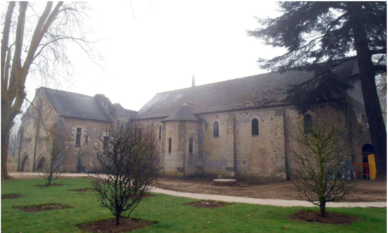
Photo 194 : le réfectoire des moines et le présumé garage à bateaux (à gauche) (vue du nord-ouest)
