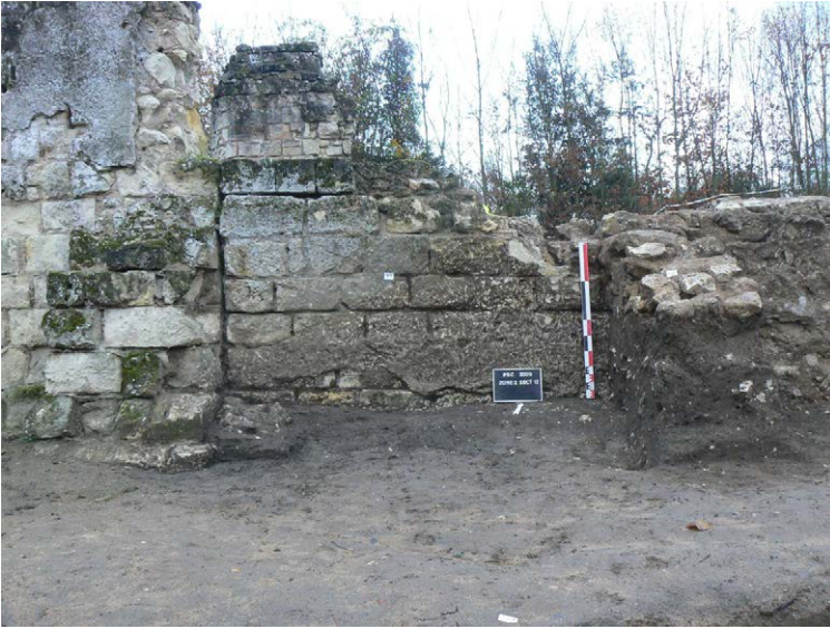
Photo 258 : la façade sud de l'extension du « régulier » M 232 (vue du sud)
