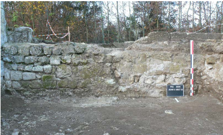
Photo 253 : le mur nord M 48 de l'extension du « régulier » dans son état du 17 e siècle (M 47) (vue du sud). À gauche, le pignon est du « régulier » successifs (vue prise du sud)
