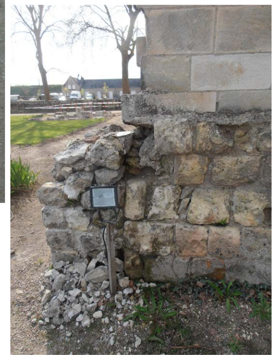
Photo 171 : le rétrécissement de la porte EA 776 dans le gouttereau ouest de l'aile orientale du carré claustral (vue de l'est) dans le sondage n°34 (vue de l'est)
