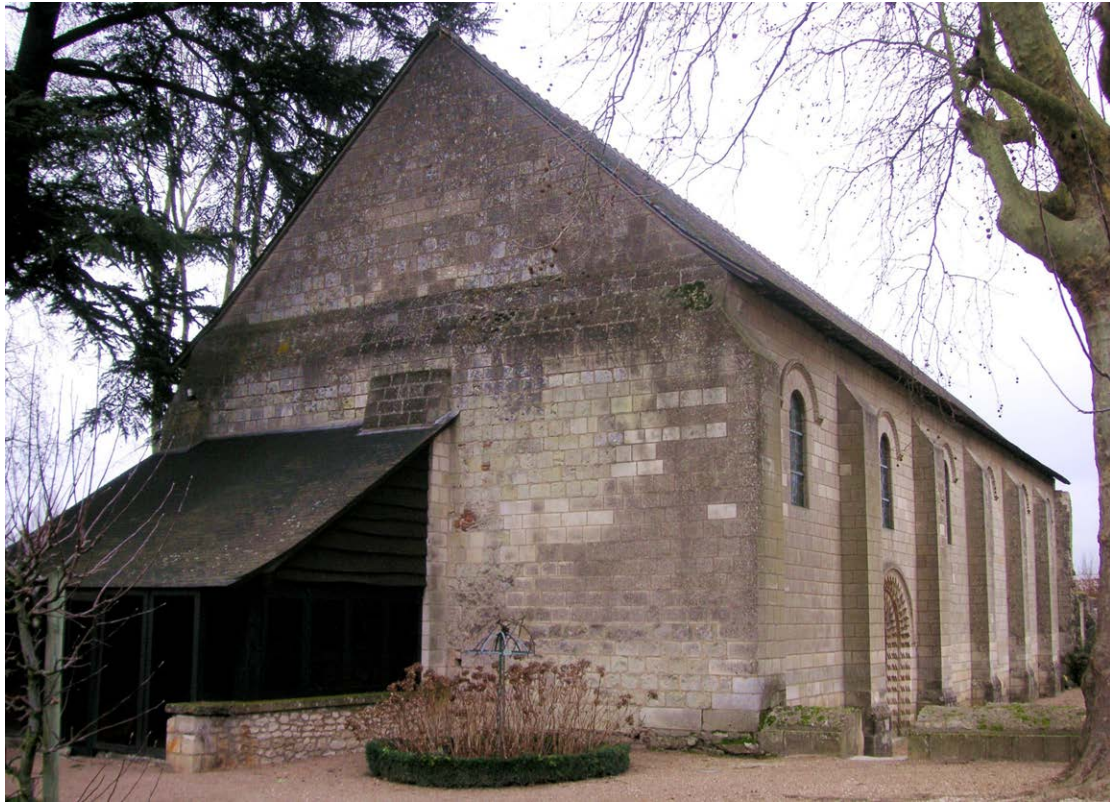
Photo 195 : le réfectoire des moines avant la démolition de l'appentis moderne plaqué sur son pignon occidental (vue du sud-ouest)
