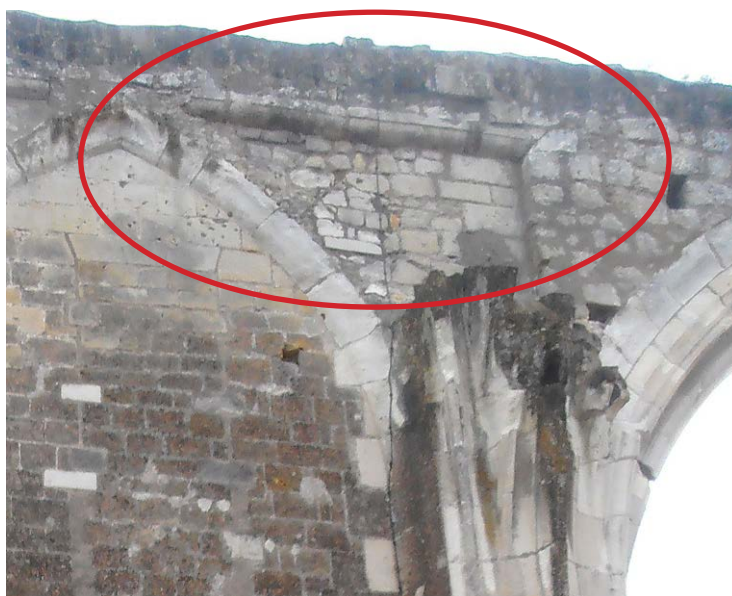
Photo 96bis : le détail montre la corniche soulignant un simple angle de maçonnerie et non une pile composée à l'angle du transept et du chœur
