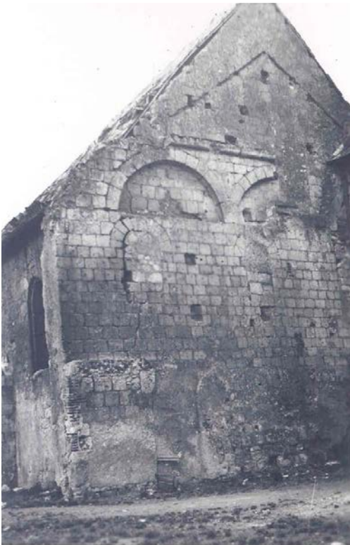
Photo 183 : le parement interne du mur gouttereau ouest de l'aile orientale du carré claustral, M 55, prise en 1948 avant restauration (vue du sud-est)
