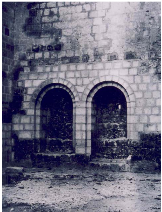
Photo 212 : les placards aménagés dans le pignon ouest du réfectoire des moines, pendant la restauration de Bernard Vitry (vers 1951, archives du STAP)
