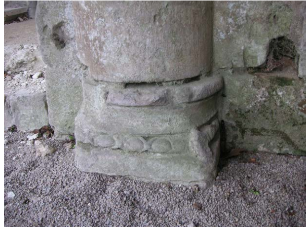
Photo 139 : base des colonnes engagées du déambulatoire
