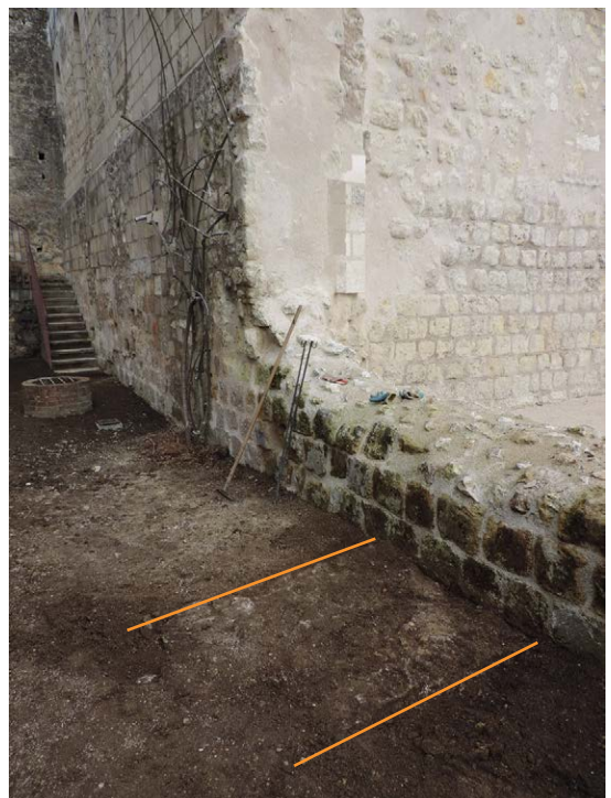
Photo 365 : mur pignon barrant l'aile orientale du cloître après destruction de la salle capitulaire (vue du sud)
