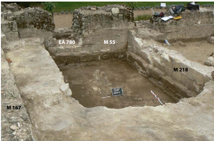
Photo 169 : face interne du mur ouest de l'aile orientale du carré claustral, dans le sondage n°34 (vue de l'est)
