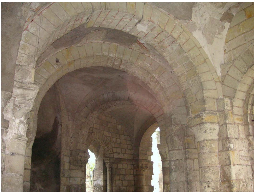
Photo 126 : la voûte du déambulatoire, côté sud (vue depuis le nord-est)
