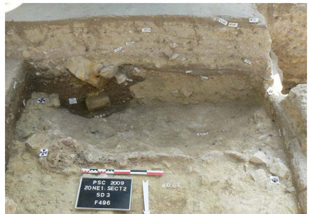
Photo 77 : le bac de préparation du mortier F 496 dans le sondage n°3
