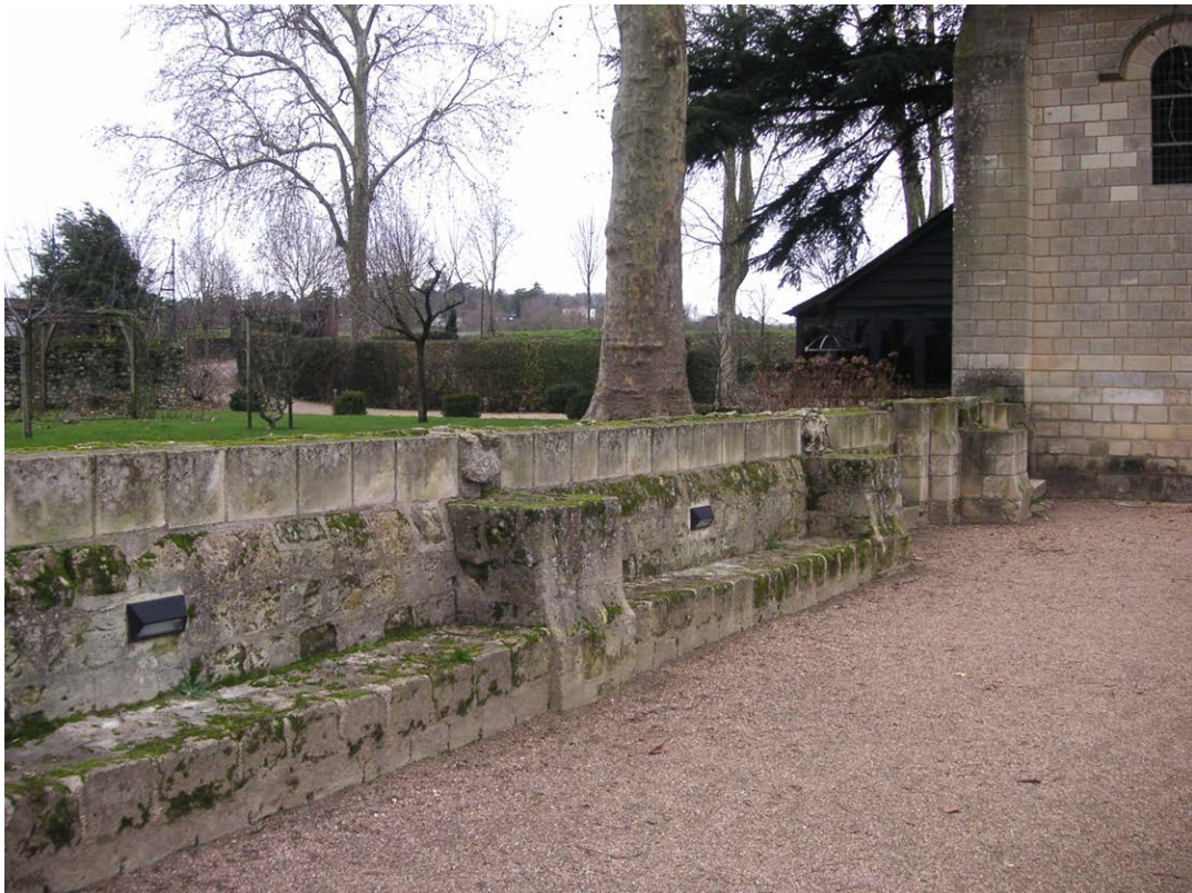
Photo 214 : l'extrémité nord du gouttereau oriental de l'aile des conves (M 261), très restauré au 20 e siècle
