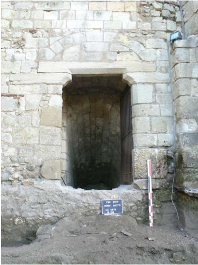
Photo 298 : la porte d'entrée du logis de sacristain et l'accès à la cave en-dessous (vue de l'est)sacristain (vue de l'ouest)
