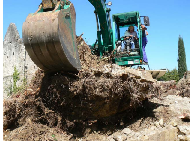
Photo 6 : dessouchage d'un des grands platanes poussés au-dessus du mur est de la salle capitulaire
