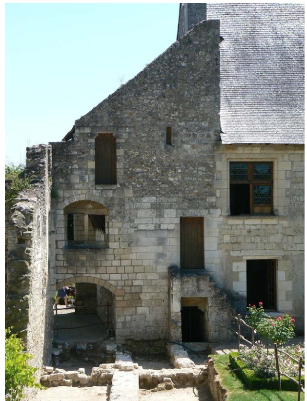
Photo 304 : le pignon oriental du logis du sacristain et l'extension nord du logis du prieur. Au premier plan, l'extrémité orientale du mur M 14 et les fondations du corps de liaison entre le logis du sacristain et le logis du prieur (vue de l'ouest)
