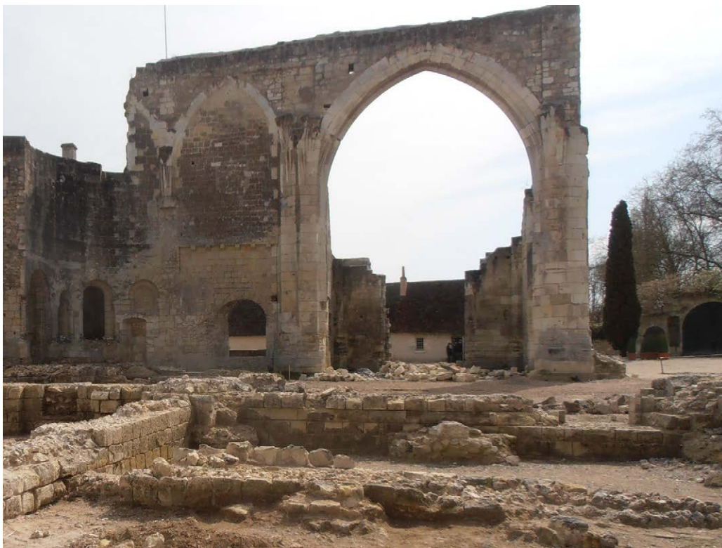
Photo 104 : le soubassement du bras nord du transept de l'église n°4, vue du nord. À l'arrière-plan, l'arche gothique du bras sud du transept. Au premier plan, le mur délimitant la sacristie, à l'extrémité sud de l'aile orientale du cloître. Appliqué contre le mur du transept se voient encore les restes du massif de l'escalier permettant de racheter la différence de niveau entre le sol de la sacristie et celui du transept
