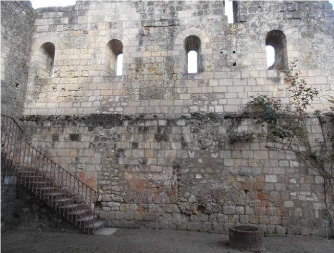
Photo 178 : le parement interne du mur gouttereau oriental de l'aile orientale du carré claustral, M 56 (extrémité nord, vue de l'ouest)du carré claustral (vue de l'ouest)
