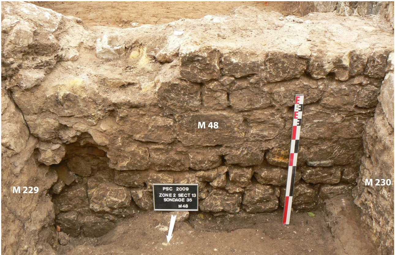
Photo 256 : le mur M 48, dans son état du 17 e siècle (M 47), parement nord, dans le sondage n°35 (vue du nord)
