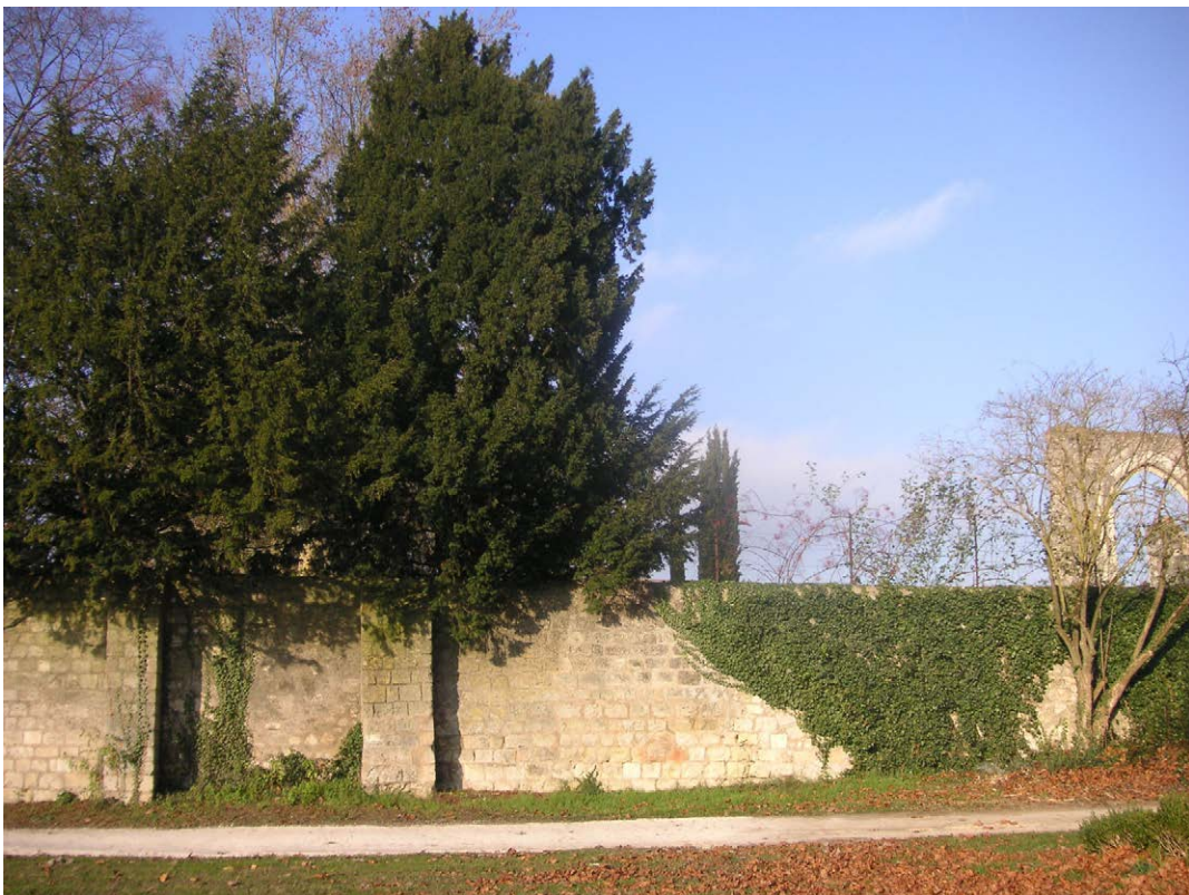
Photo 357 : mur sud de clôture du prieuré, avec la porte d'entrée (entre les deux contreforts) murée au 17 e siècle (vue du sud)
