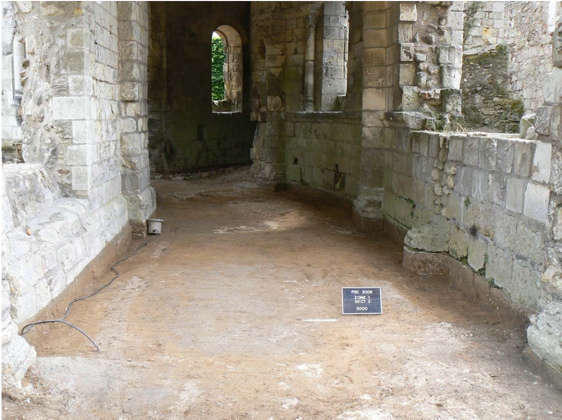
Photo 132 : partie sud du déambulatoire après décapage. Le niveau du sol exposé date du 15 e ou du 16 e siècle, mais correspond à peu près au niveau primitif, si l'on en juge par le niveau des bases de colonnes
