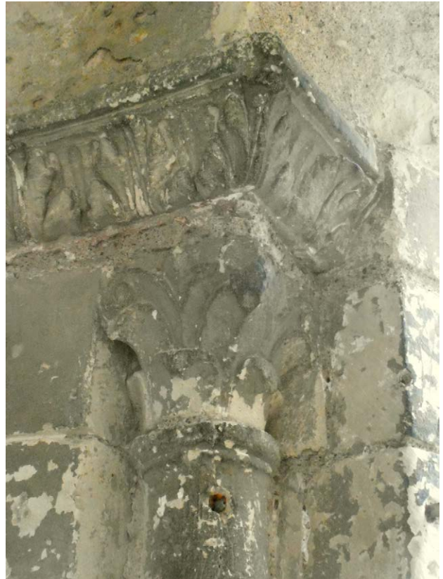
Photo 135 : colonnette d'angle et chapiteau de l'entrée de la chapelle axiale, côté sud
