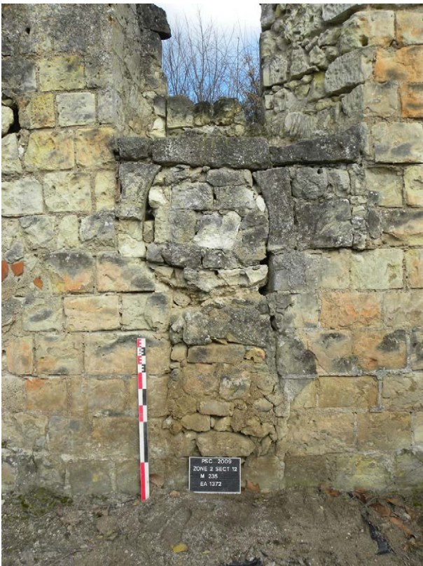
Photo 245d : le placard oriental EA 1372 dans le gouttereau nord du « régulier », et ses bouchages successifs (vue prise du sud)
