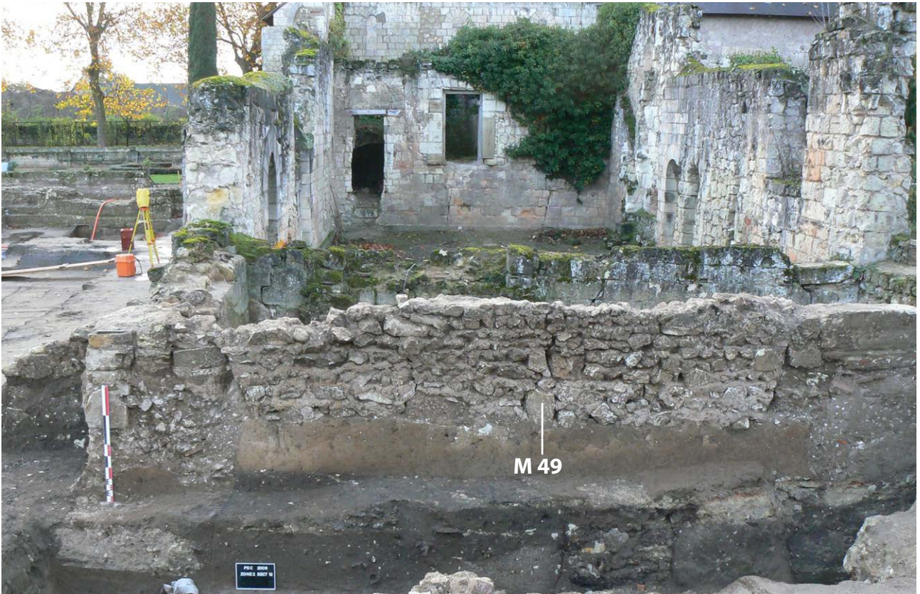
Photo 344 : le mur M 49, soubassement de la façade à colombage de l'appentis construit au 17 e siècle dans le prolongement du « régulier »
