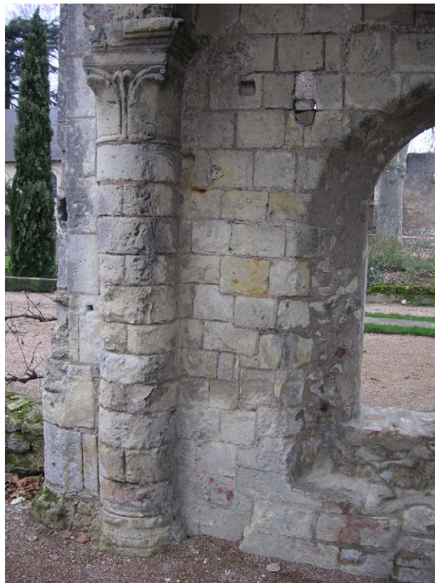
Photo 98 : la colonne engagée EA 169, vestige de la croisée du transept de l'église n°4
