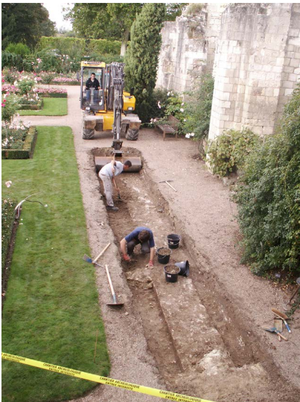
Photo 303 : le mur de clôture du jardin du prieur M 14, dans la tranchée n°1 du diagnostic de 2006 (vue de l'est)
