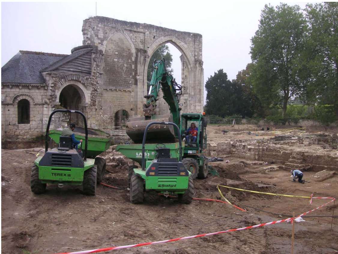
Photo 7 : des terrassements préalables à la fouille très importants
