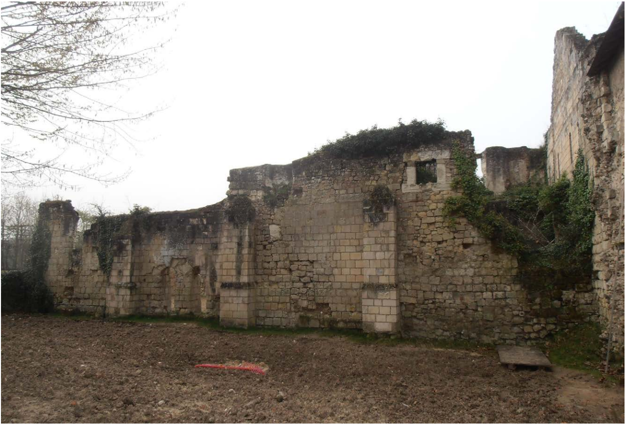
Photo 241 : façade nord du « régulier » en 2013 (vue du nord)
