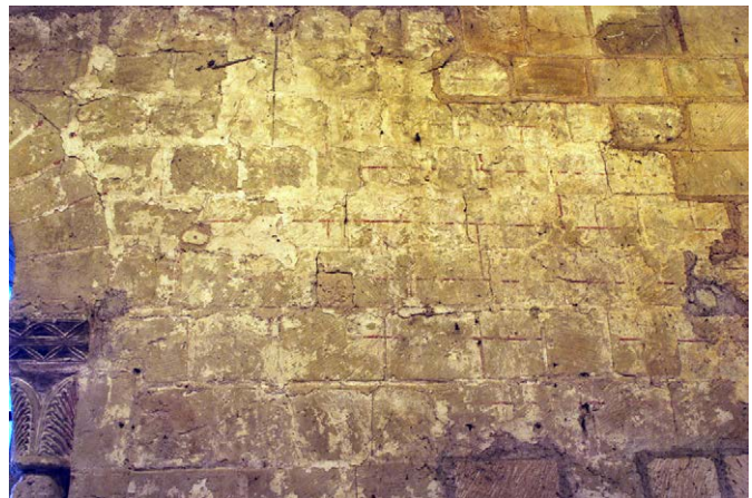
Photo 199 : détail de l'appareil de faux joints rouges qui couvre les parois intérieures du réfectoire des moines (gouttereau sud – M 271 – entre les fenêtres EA 1199 et 1200)
