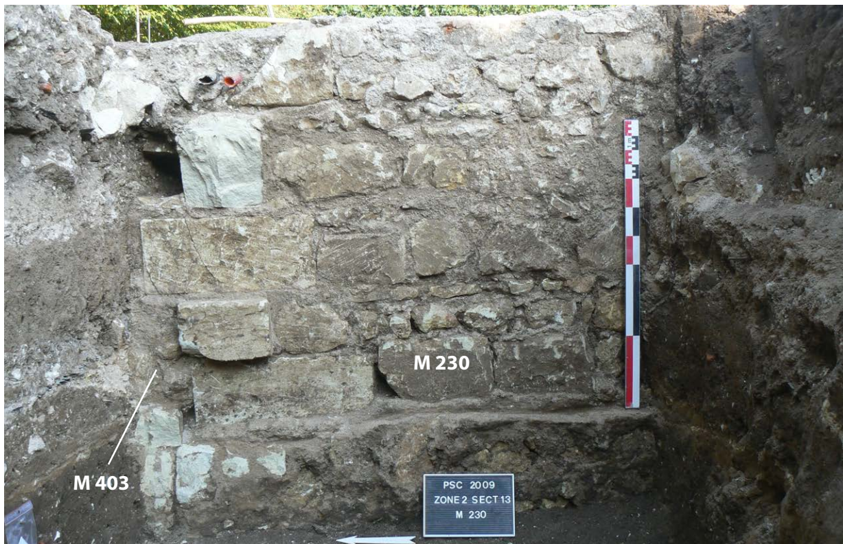
Photo 341 : la face interne de la fondation du pignon occidental du sous-prieuré (M 230) dans le sondage n°35 (vue du sud-est)
