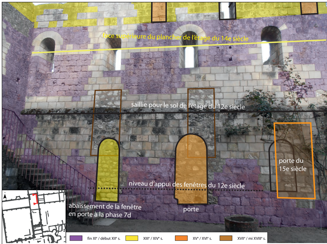
Figure 39 : analyse du bâti du parement interne du mur gouttereau est de l'aile orientale du carré claustral (vue de l'ouest)
