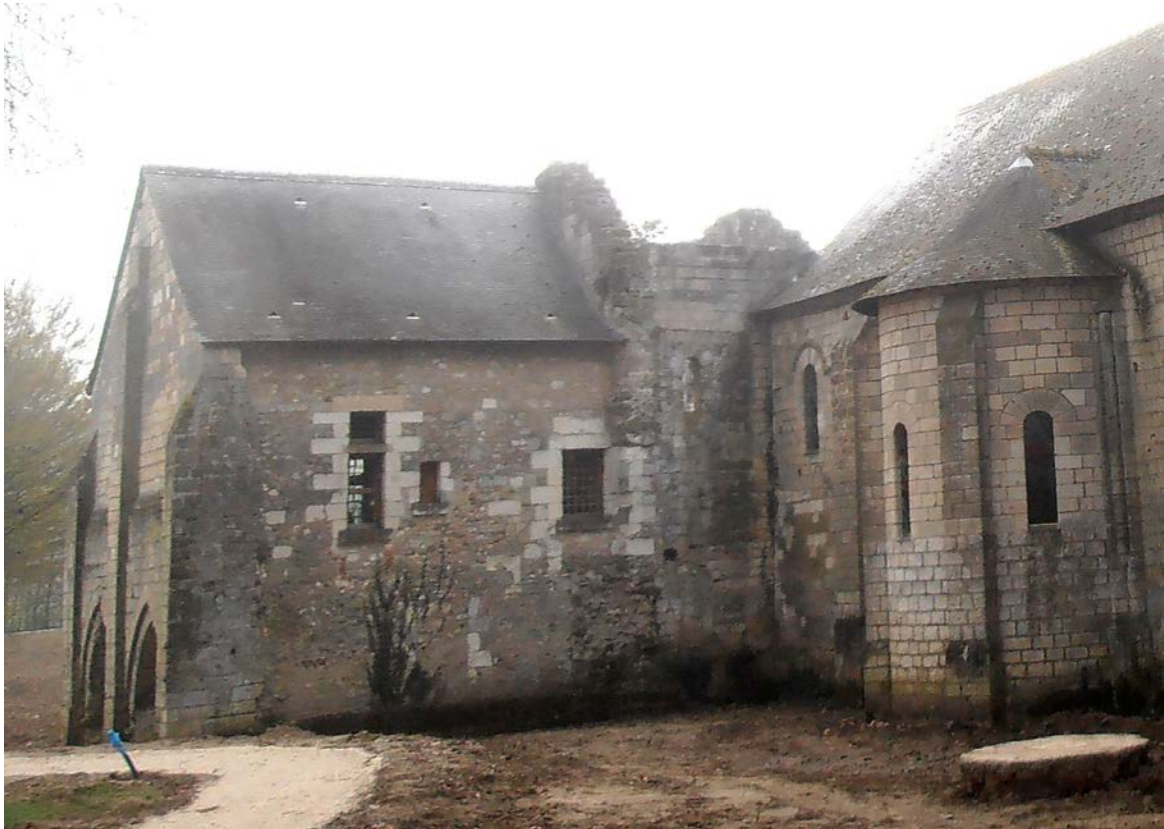
Photo 188 : le présumé garage à bateaux, à l'extrémité nord de l'aile orientale du carré claustral ; à droite, le réfectoire des moines (vue de l'ouest)
