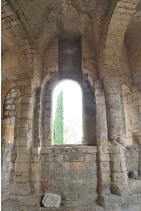
Photo 119 : le rond-point du chœur côté externe : le mur M 162, la baie EA 217 et les supports EA 231 et EA 232
