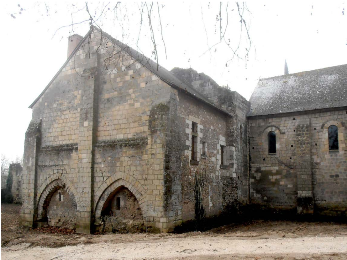
Photo 186 : le présumé garage à bateaux, à l'extrémité nord de l'aile orientale du carré claustral ; à droite, le réfectoire des moines (vue du nord-ouest)
