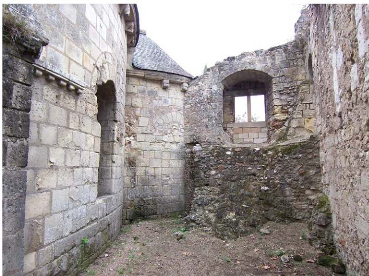
Photo 295 : le massif de maçonnerie qui dissimule les escaliers EA 622 (en haut à droite) et EA 623 (vers l'avant, dans l'axe de la fenêtre) (vue de l'ouest) (photo du cabinet de géomètre Serge Labaille, 2006)
