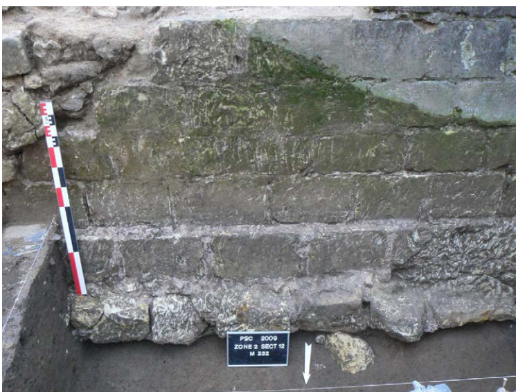
Photo 259bis : semelle de fondation de la façade sud de l'extension du « régulier » M 232, dans le sondage n°41 (vue du nord)
