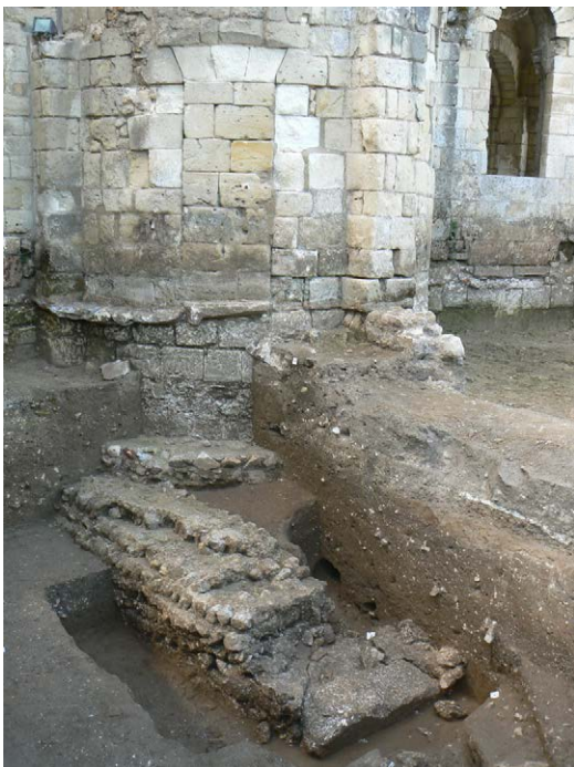
Photo 68 : les murs M 248 et M 249, formant l'angle sud-est du bâtiment B du premier monastère (sondage n°48, vue du sud-est)
