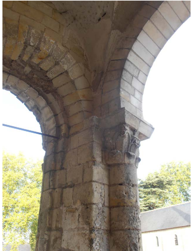
Photo 129 : le raccord de la voûte du déambulatoire, côté nord de l'ouverture centrale du rond-point du chœur
