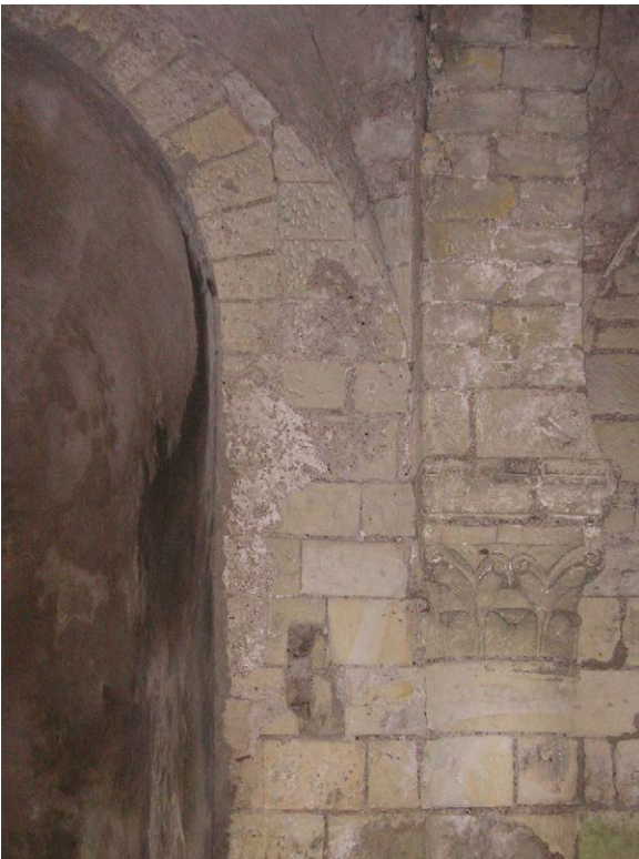
Photo 130 : le raccord de la voûte du déambulatoire, côté ouest de l'ouverture de la chapelle sud-est
