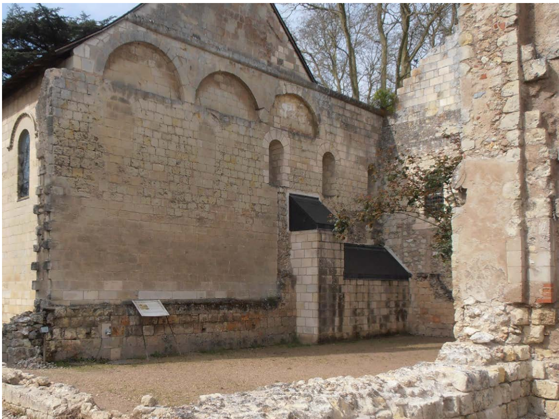
Photo 182 : le parement interne du mur gouttereau ouest de l'aile orientale du carré claustral, M 55 (vue du sud-est)
