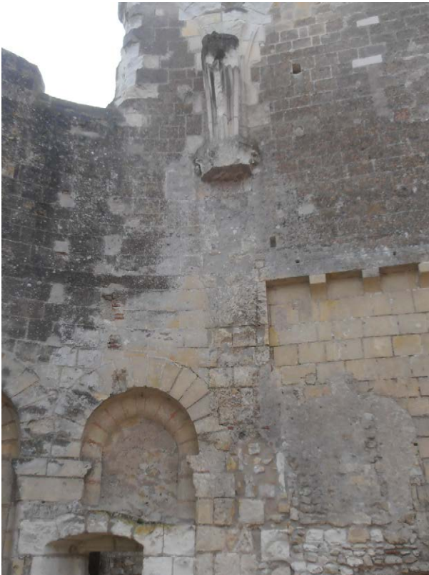
Photo 109 : la liaison entre la travée droite de chœur et l'abside de l'église n°4, vue vers le sud
