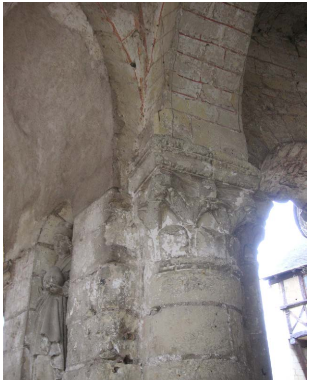
Photo 131 : le raccord de la voûte du déambulatoire, côté sud de l'ouverture de la chapelle axiale
