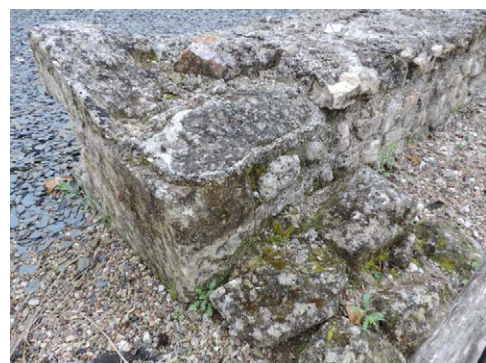
Photo 52 : le piédroit oriental de la porte EA 1018, avec les traces du bûchage d'une saillie de maçonnerie
