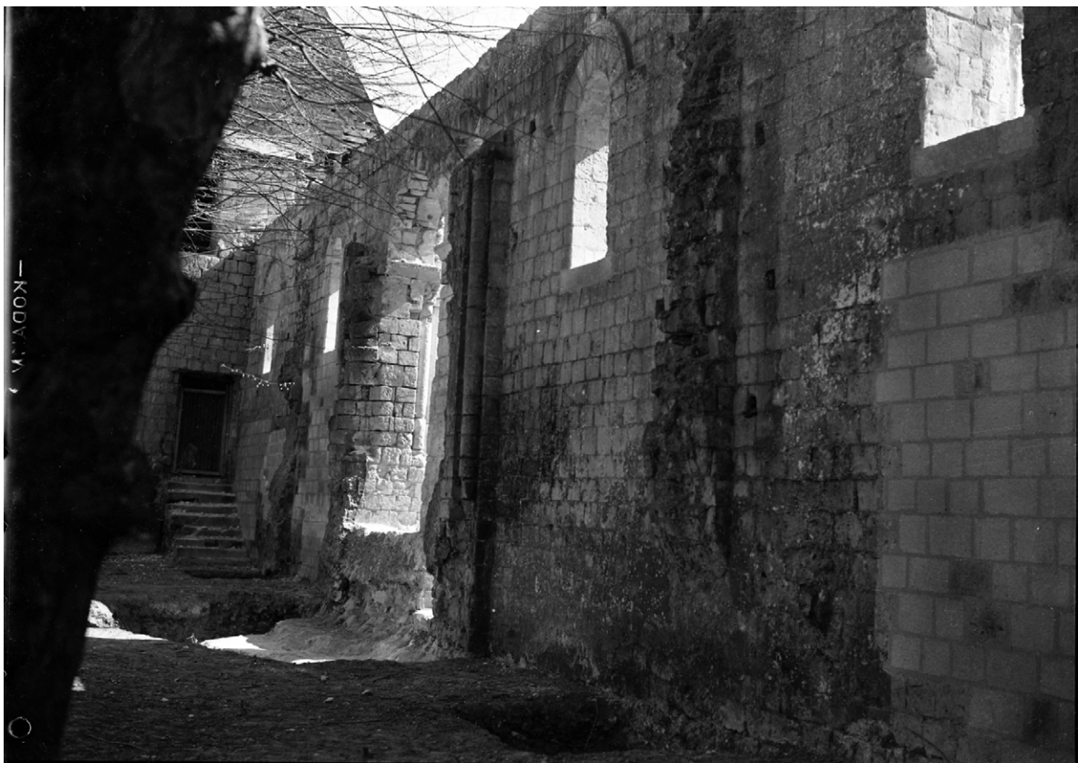
Photo 204bis : parement extérieur du gouttereau nord du réfectoire des moines (M 272) au début de sa restauration par l'architecte en chef Bernard Vitry (photo Robert Arsicaud, FRAD037 5Fi000184)
