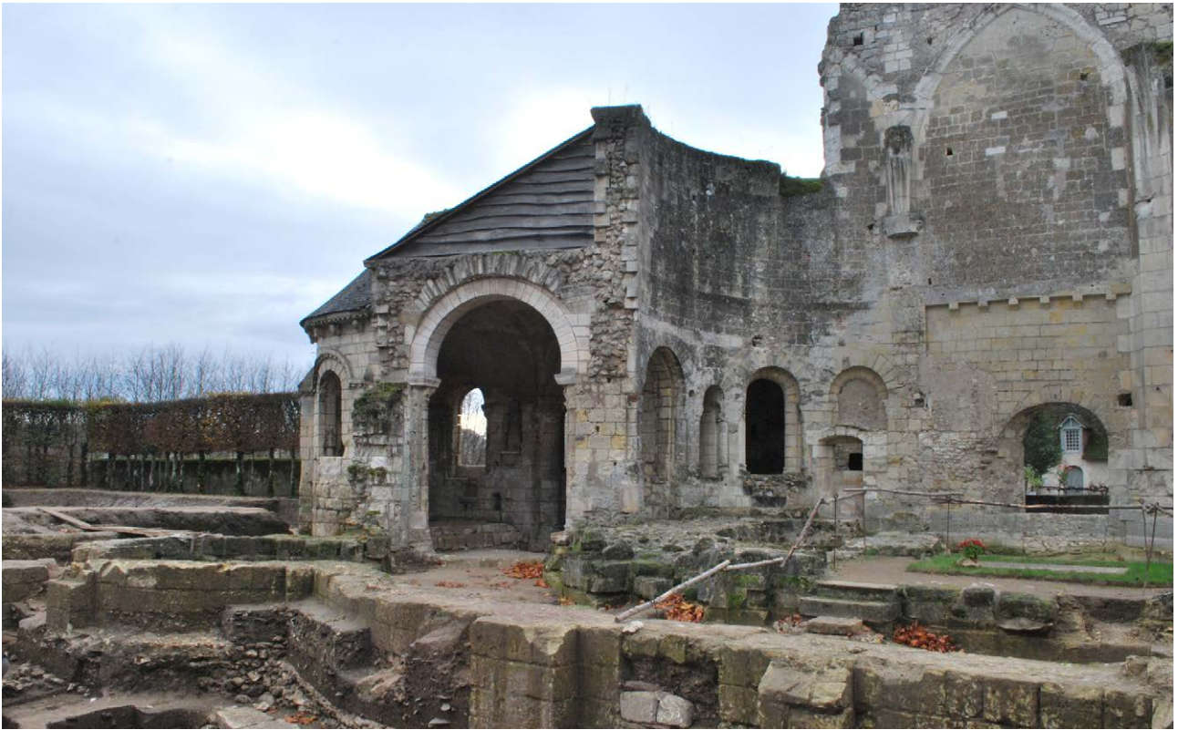
Photo 123 : le rond-point du chœur et le déambulatoire, vus du nord
