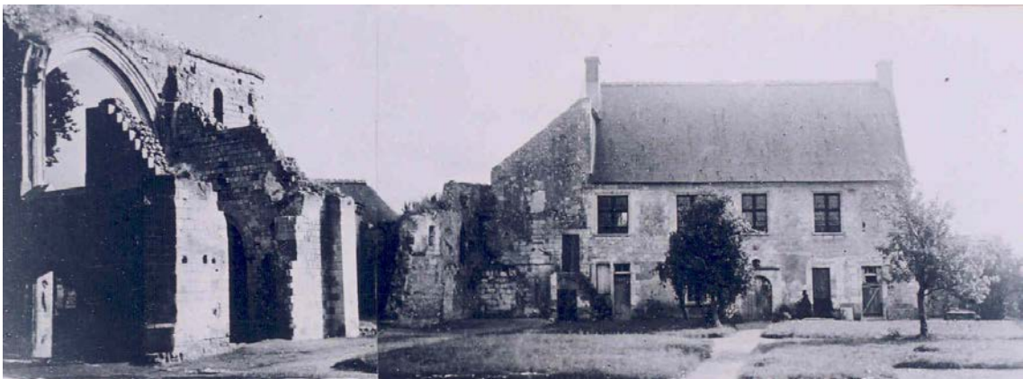
Photo 379 : le logis du prieur photographié vers 1951 par l'architecte en chef Bernard Vitry (montage, archives du STAP)
