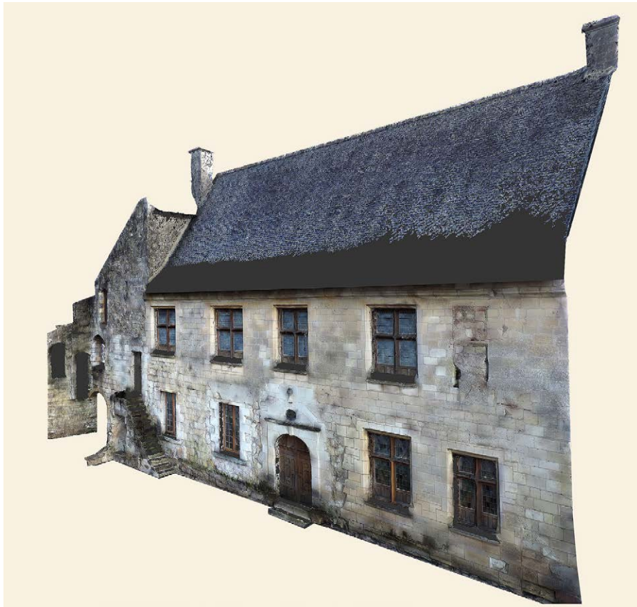
Photo 270 : modélisation 3D de la façade ouest du logis du prieur par lasergrammétrie (Matthieu Gaultier, Sadil)
