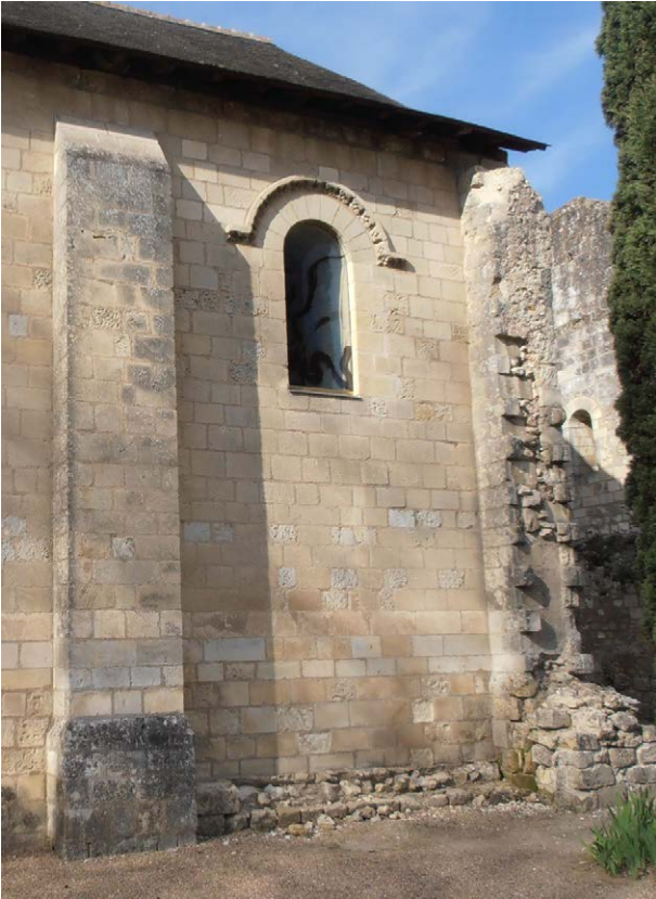
Photo 231 : les restes du banc claustral devant la travée orientale du réfectoire, épargnés par la restauration de Vitry (vue du sud)
