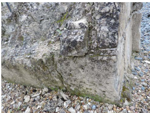
Photo 52 : le piédroit occidental de la porte EA 1018, avec les traces du bûchage d'une saillie de maçonnerie
