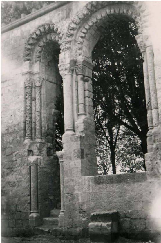
Photo 202bis : la chaire de lecteur du réfectoire des moines en cours de restauration par Bernard Vitry, au début des années 1950. On distingue notamment l'arrachement de l'abside côté ouest, avec la colonnette du piédroit sud de la fenêtre ouest et le départ de la frise de pointes de diamant qui la surmonte (vue prise du sud-est)
