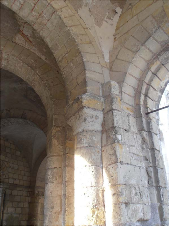
Photo 128 : le raccord de la voûte du déambulatoire, côté sud de l'ouverture centrale du rond-point du chœur
