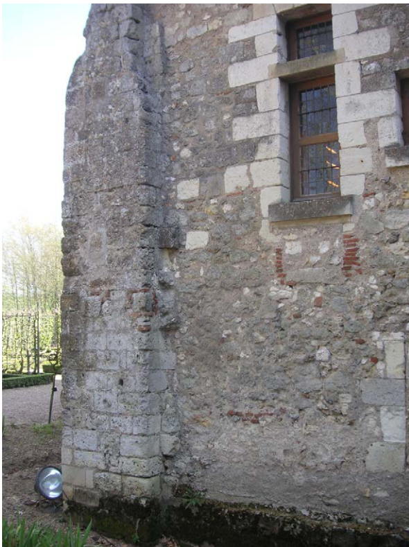
Photo 189 : l'angle nord-ouest du présumé garage à bateaux avec, en partie basse, les restes de maçonnerie primitive, avant la reconstruction du 15 e siècle (vue du sud-ouest)
