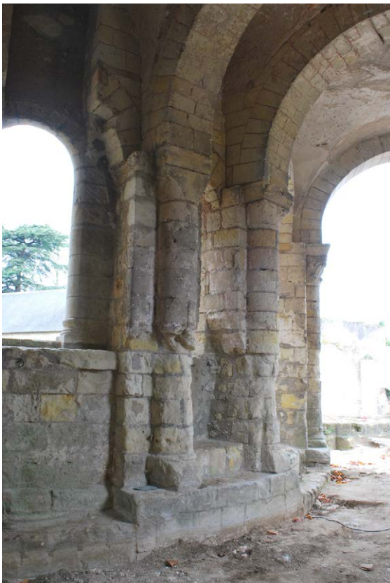
Photo 121 : le rond-point du chœur côté externe : le mur M 162, la baie EA 217 et les supports EA 232 et EA 233
