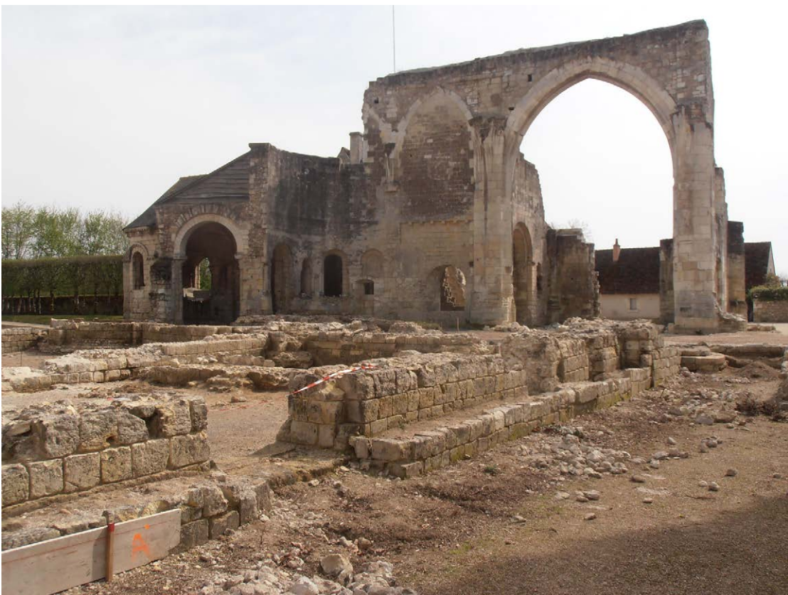
Photo 230 : le banc claustral le long de la salle capitulaire, en mars 2014 (vue du nord-ouest)
