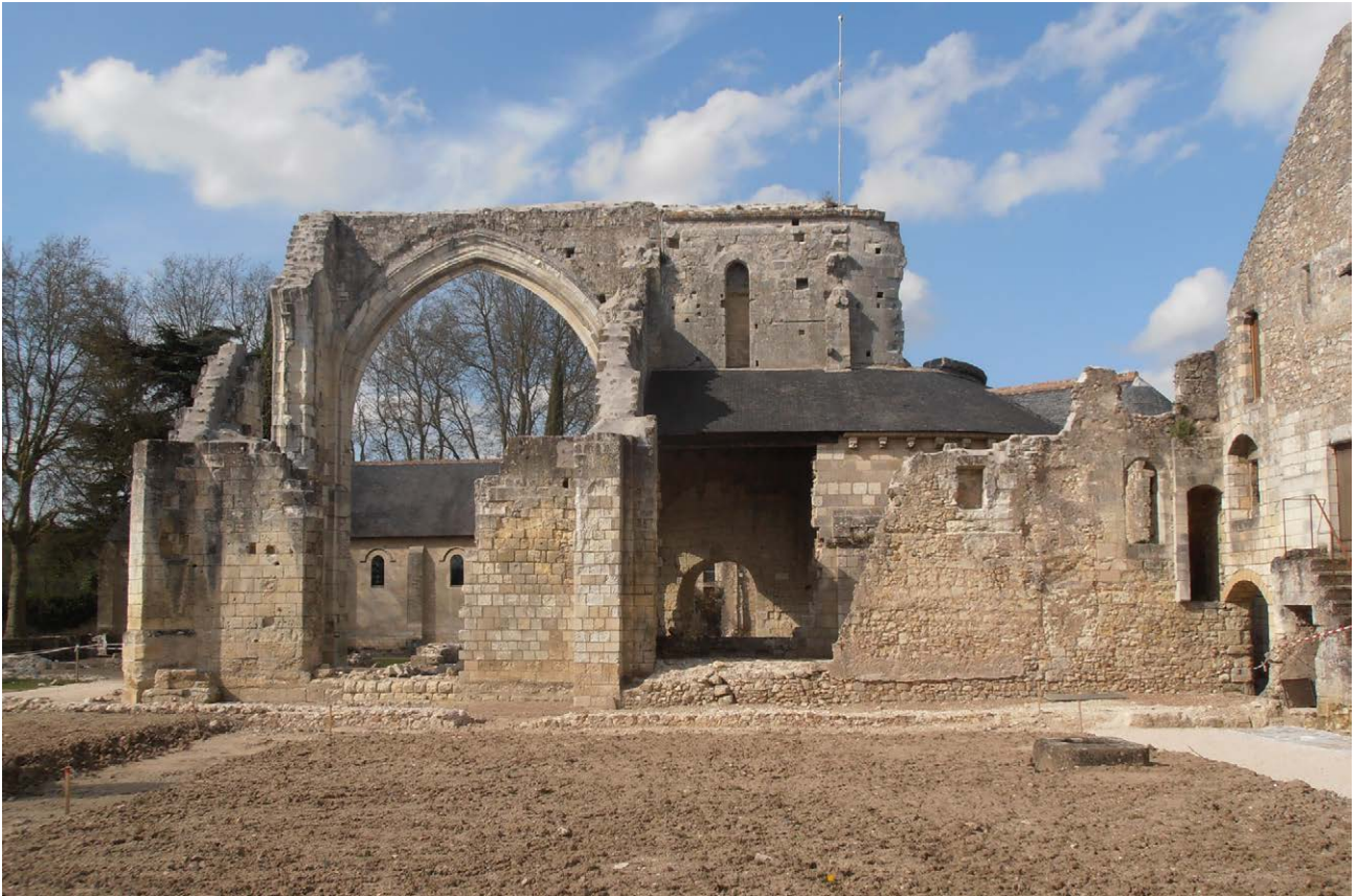
Photo 99 : vue latérale de l'église (transept sud et chevet) depuis le sud. État en mars 2014
