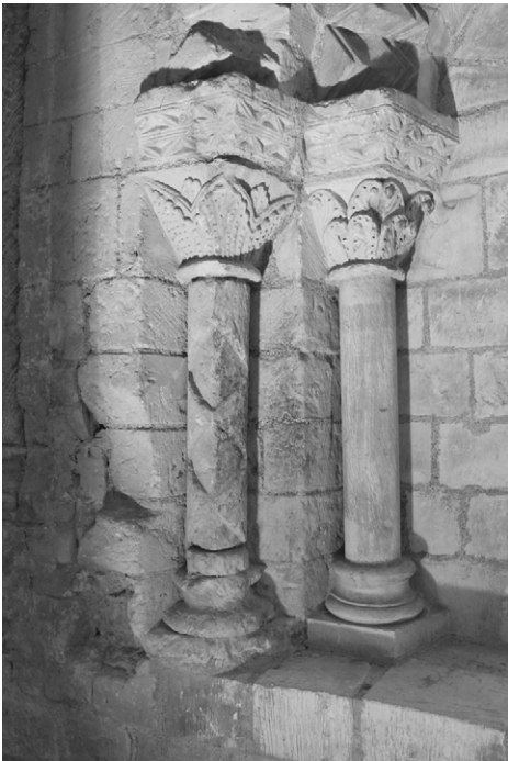
Photo 205 : les colonnettes de l'embrasure de la fenêtre ouest de l'abside de la chaire du lecteur (EA 1215, piédroit sud)
