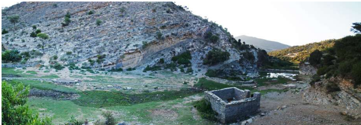
FIGURE 9.4 – Vue panoramique du barrage sur la vallée de May Ayni, à mi-chemin entre le site de Wakarida et Sewne (figure 8.21). Cliché : N. Blond, 2017.
