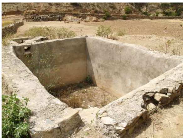
FIGURE 9.7 – Citerne entièrement maçonnée dans une parcelle de fond de vallon, au niveau de WK11 (fig. 3.4, p. 128), vallée de Ka Ebile. Cliché : N. Blond, 2017.
