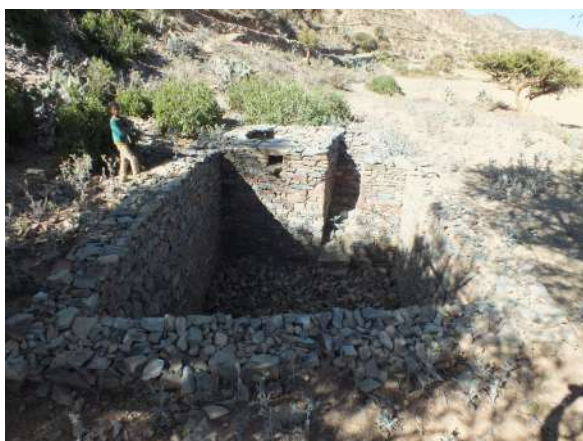
FIGURE 9.5 – Citerne en pierre sèche, vallée de May Ayni, fond non maçonné. Cliché : Y. Callot, 2013.
