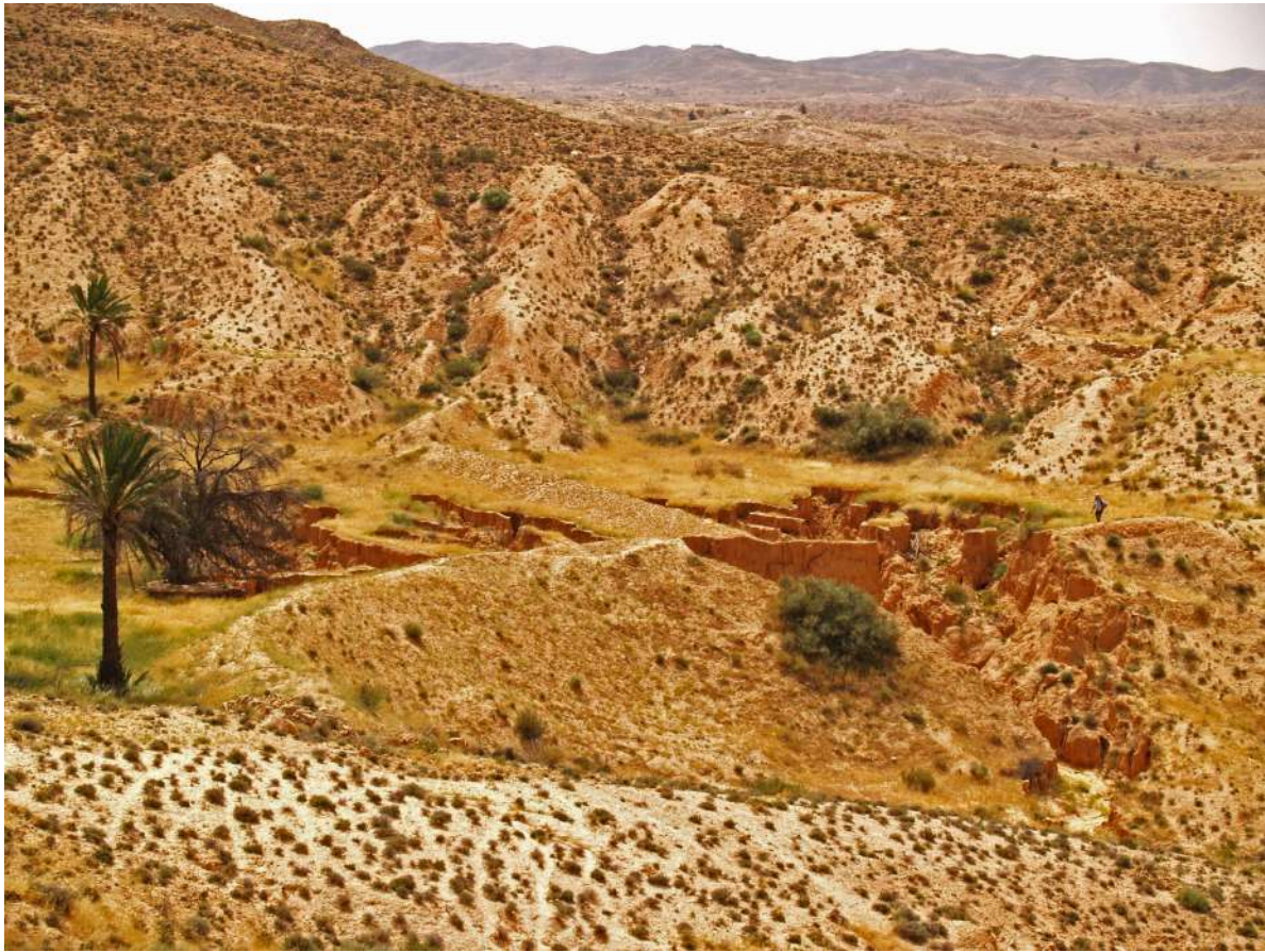
FIGURE 10.25 – Brèche dans la tabia et ravines dans le jesr BDh (Matmata, Tunisie). Cliché : N. Blond, 2017, tiré de Blond et al. (2019).
