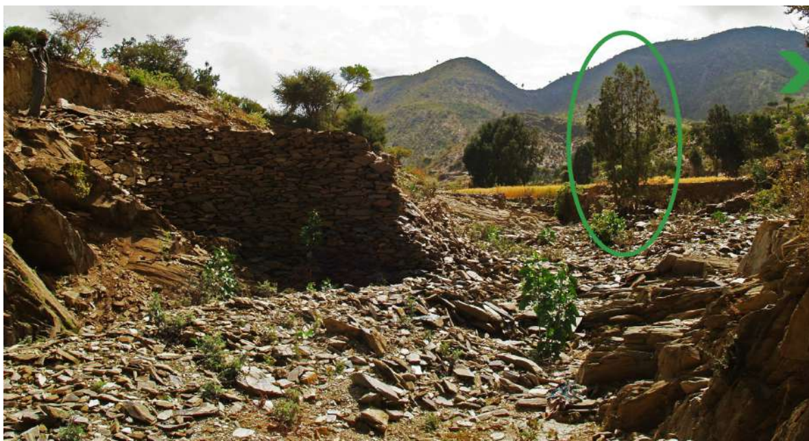
FIGURE 6.10 – Barrage de Ka Ebile effondré en 2014. Cliché : N. Blond, 2014.
