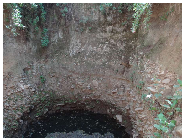
FIGURE 9.8 – Vue de l’intérieur du puits de MAa. La surface de l’eau est située à environ 7 m de profondeur. Cliché : N. Jacob, 2017.
