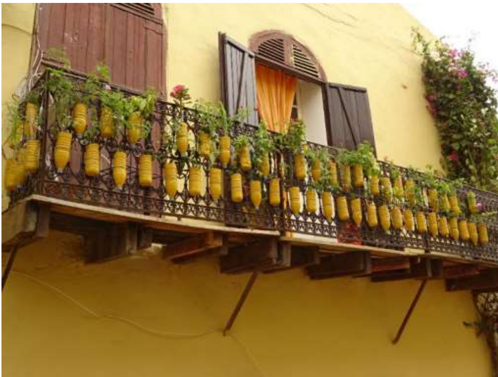
Couverture : balcon et récupération sur l'île de Gorée (Sénégal) (Florentin, 2018)
