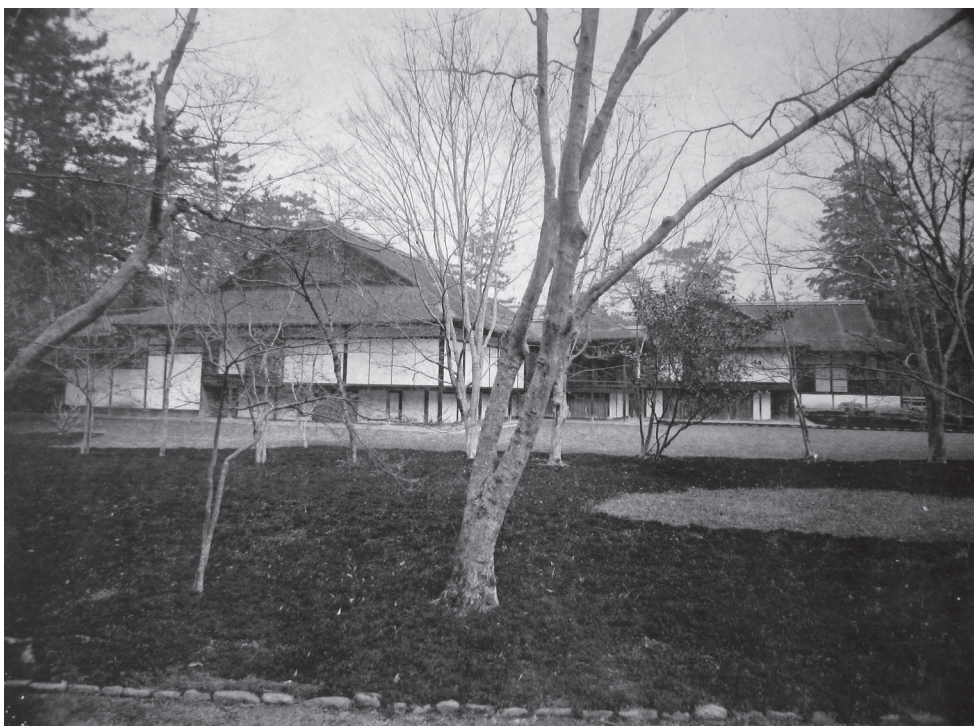
Fig. 1-2 : Photographies de la villa Katsura ( shoin ) publiées en 1932 dans Katsura rikyū oshashin oyobi jissoku-zu (Photographies et relevé des plans de la villa impériale de Katsura), Kawakami Kunimoto, 1932.
