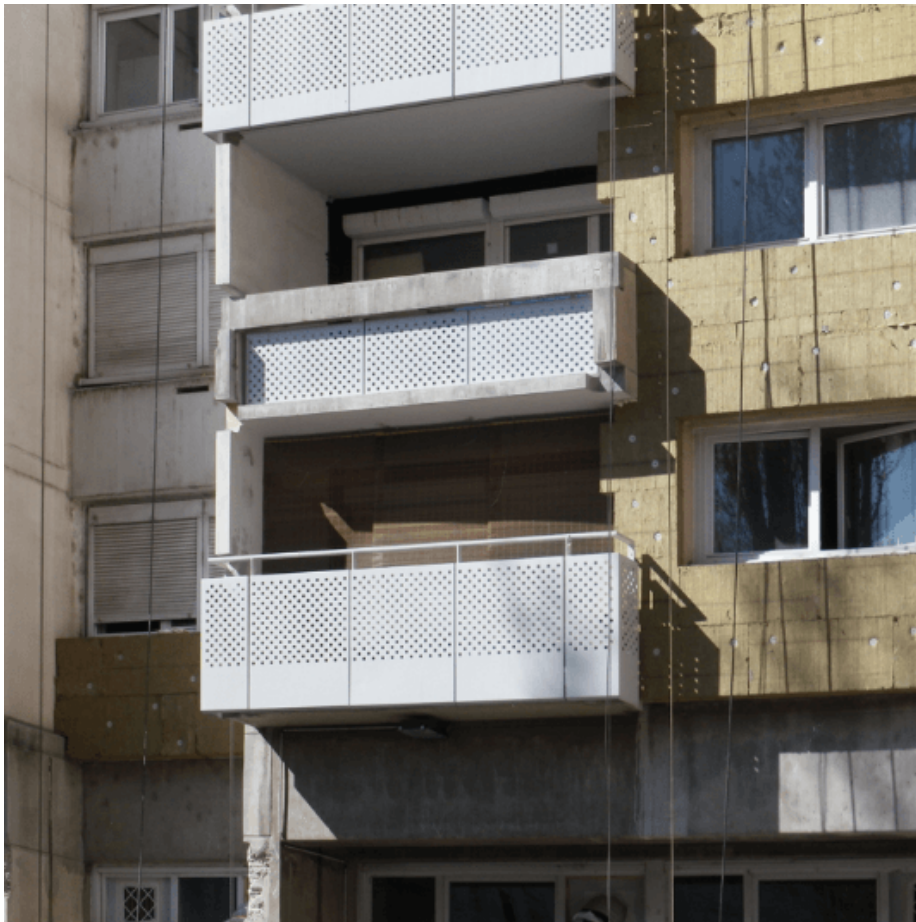
Figure 1 : Photographie des balcons du 50 Arlequin pendant les travaux de réhabilitation, Villeneuve de Grenoble, le 26 mars 2016.
