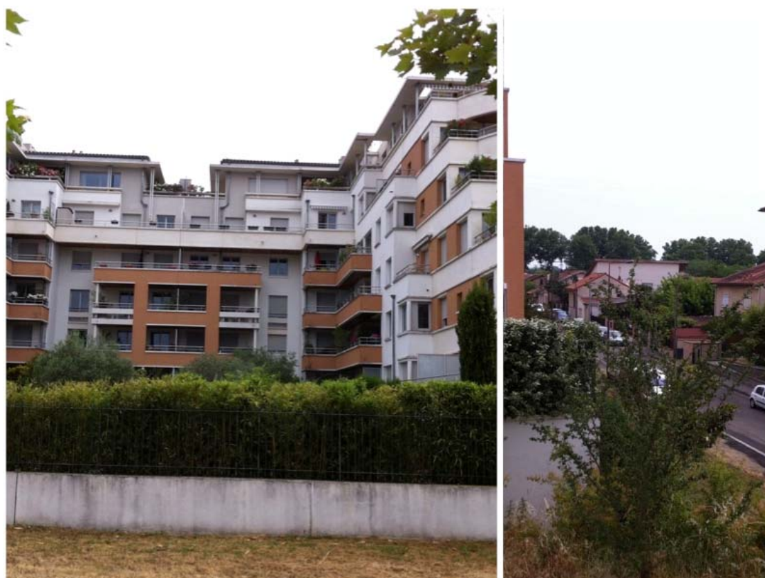
Figure 1. La Cité Job à Toulouse
