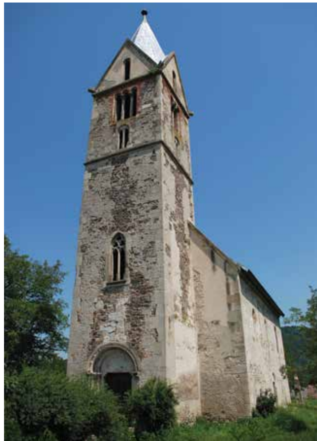
◄ Fig. 1. Église de Strei. Vue extérieure depuis le nord-ouest. Cliché de l'auteur.
