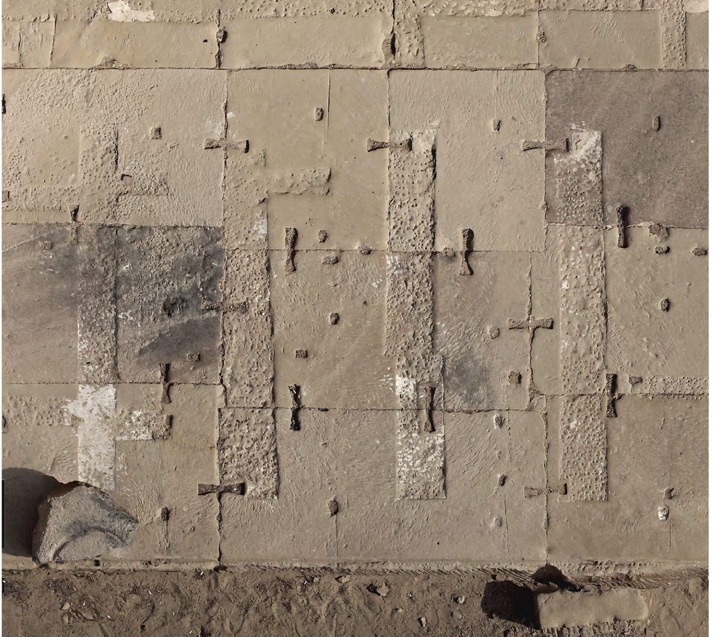
Fig. 11 Ortho-image de l'assemblage des blocs du mur péribole de Dendara
