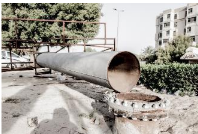
Photographie 8 : Panneau gisant sur le sol, Fintas, Koweït, © Manuel Benchetrit, 2017.
