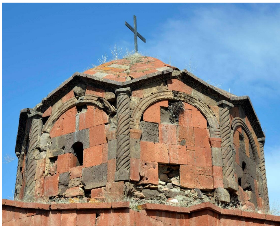
Fig. 46. Zařinj. Tambour et coiffe en ombrelle. Photo Zaven Sargsyan.
