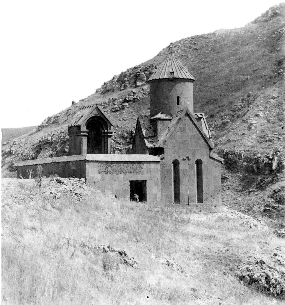
Fig. 17. Xckōnk'. Chapelle St-Grégoire l'Illuminateur. Vue générale du nord-ouest. MHA n° tb058354, c. 1900.
