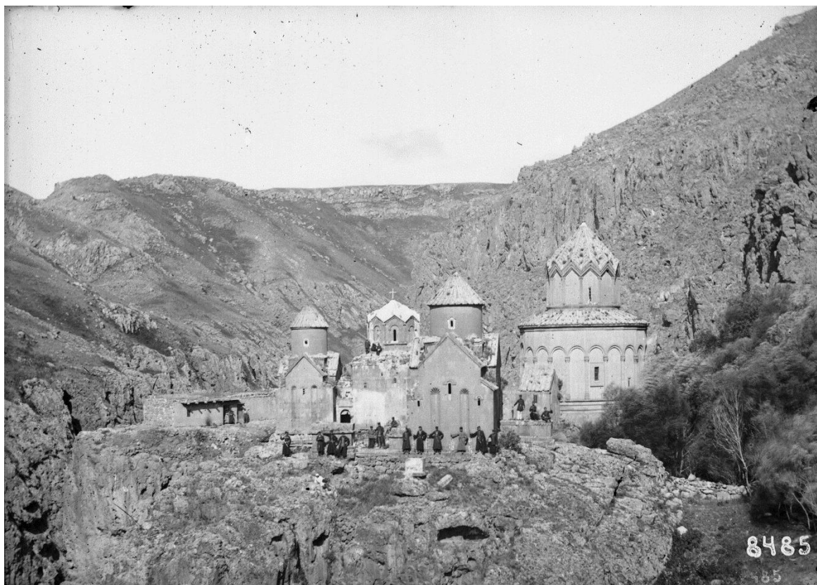
Fig. 3. Xckōnk'. Vue générale de l'est, avec le groupe de quatre sanctuaires. Photo Y. K'iwrk'č'ean, 1881, MHA n° 8485.
