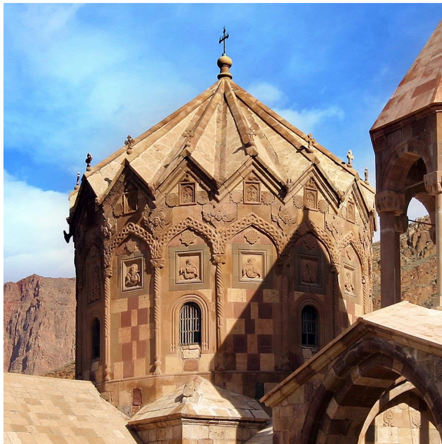
Fig. 65. Daraşamb (nord-ouest de l'Iran). St-Etienne. Tambour et dôme en ombrelle. Photo Ara Melikian (Tabriz).
