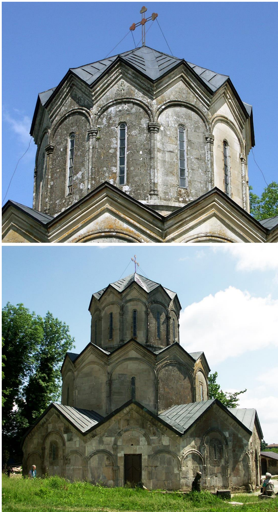
Fig. 85. Kacxi (Géorgie, 1010-1014). Tambour et dôme en ombrelle. Vue générale du nord-ouest.
