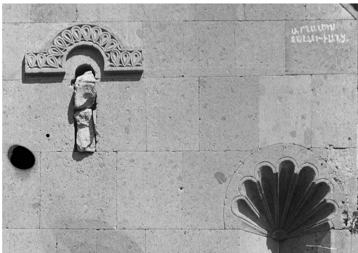
Fig. 16. Xckōnk'. Chapelle St-Etienne. Détails de la façade sud : ornement de la fenêtre centrale et trompe coquillée en haut de l'une des deux niches dièdres. Photo T'. T'oramanean, c. 1910, MHA n° 4390.
