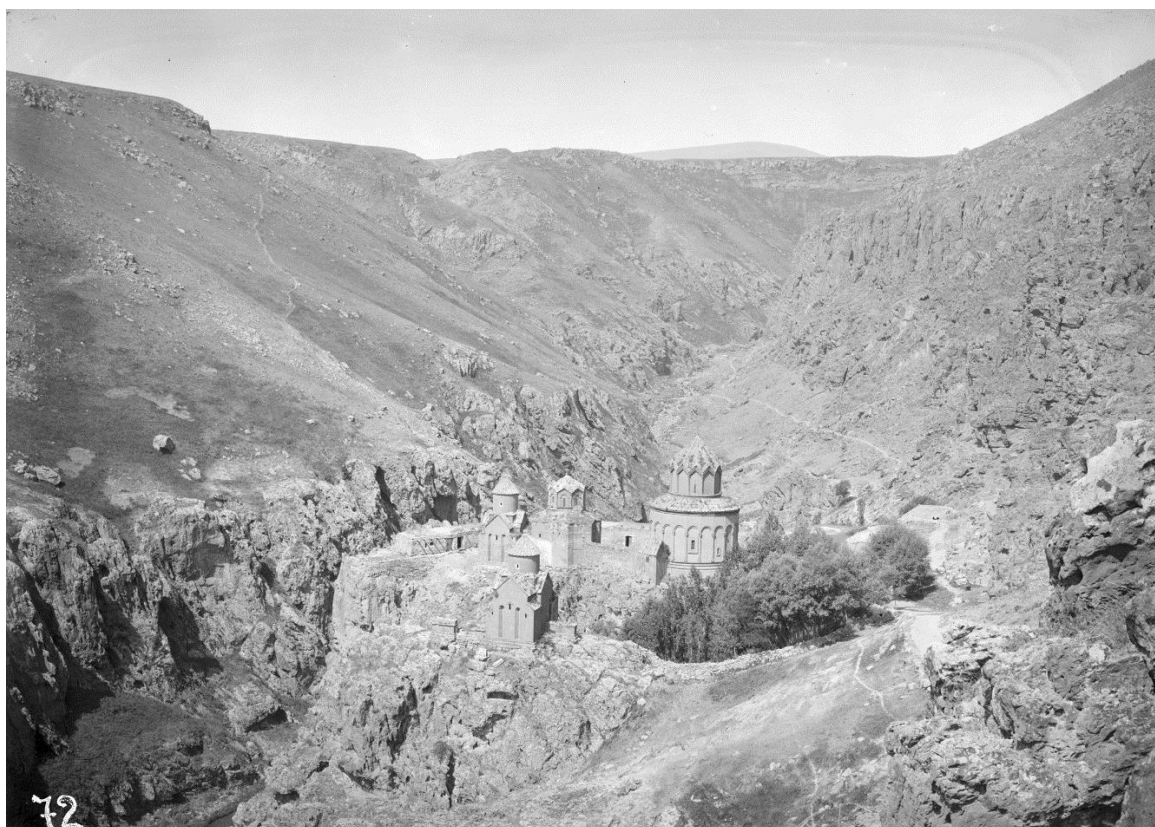
Fig. 4. Xckōnk'. Vue générale du nord-est, avec le groupe de quatre sanctuaires. Photo G. Yovsēp'ean, c. 1900, MHA n° 72.
