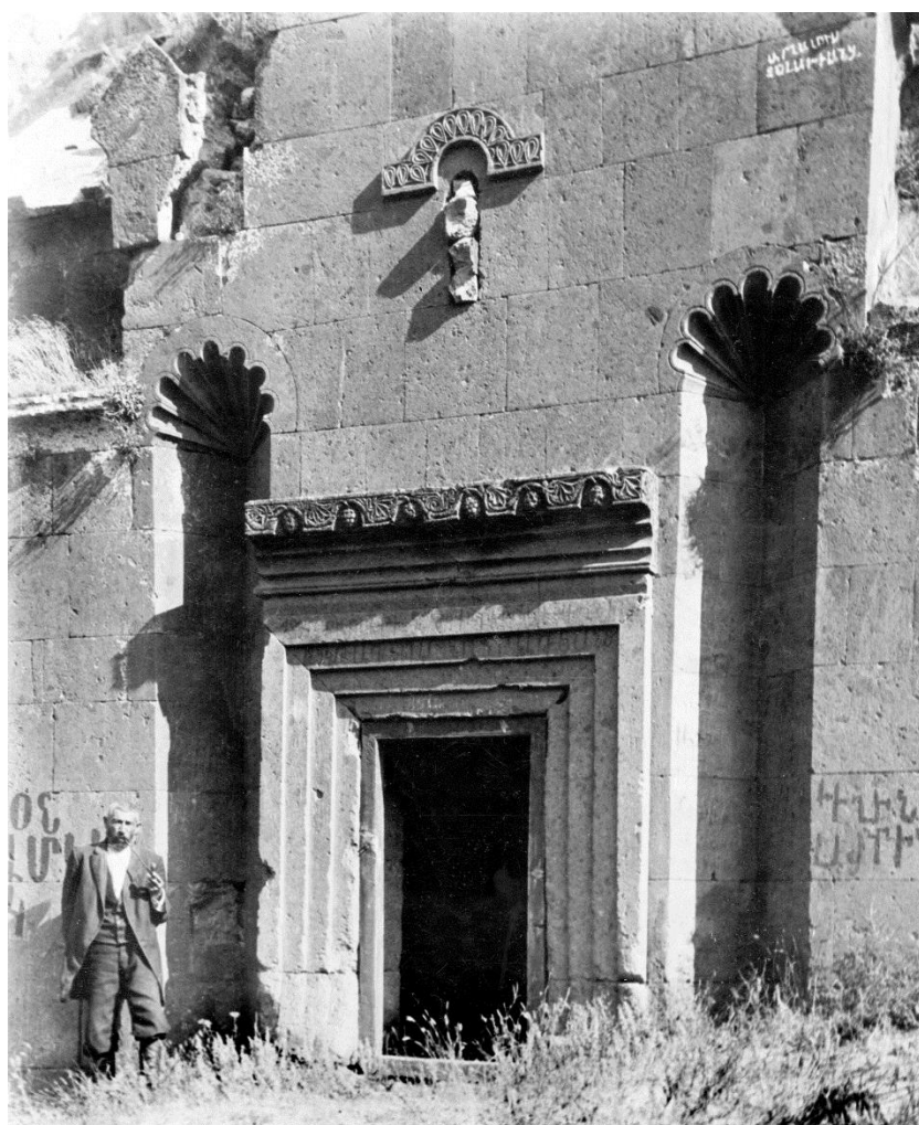
Fig. 14. Xckōnk'. Chapelle St-Etienne (déb. XI e s.). Façade sud. MHA n° tb058360, c. 1900.
