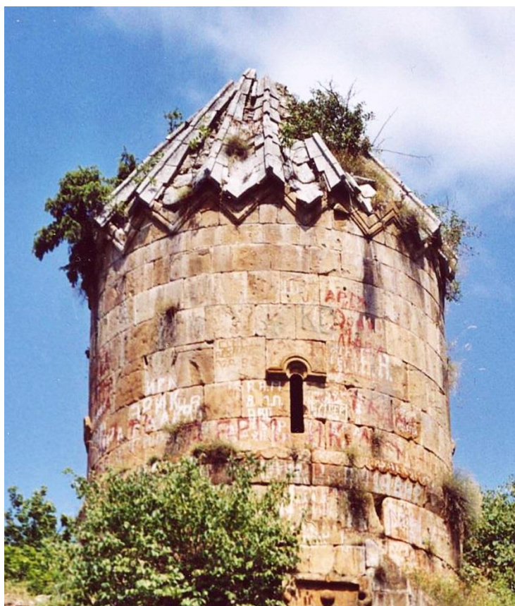
Fig. 59. Gtič, monastère. Église principale (1241-1246). Tambour et dôme en ombrelle.
