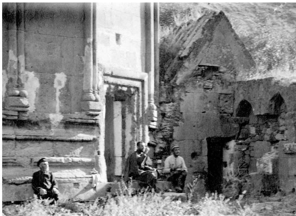
Fig. 42. Xckōnk'. St-Serge. Détail de la façade sud avec portail et édicule non cultuel plus à l'est. Photo c. 1900, MHA n° tb058362.
