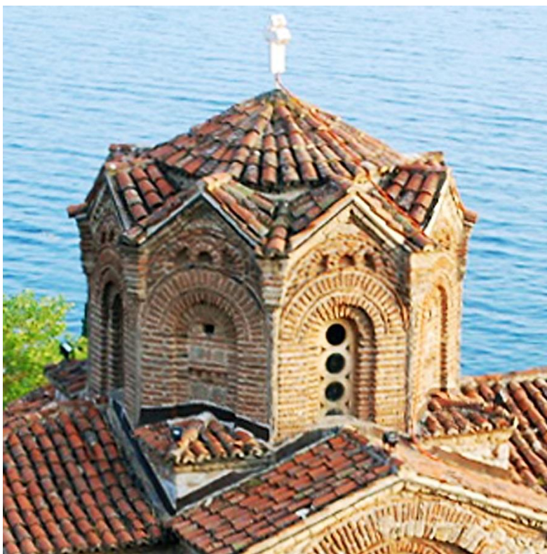
Fig. 100. Kaneo (Macédoine). St-Jean (XIII e -XIV e s.). Tambour à pignons, étroite portion annulaire d'ombrelle, puis coiffe arrondie au centre du dôme. Photo http://commons.wikimedia.org .
