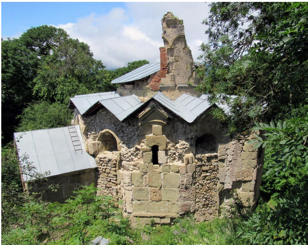
Fig. 86. Bočorma (Géorgie, c. fin du X e s.). Toit annulaire plissé à série de pignons.
