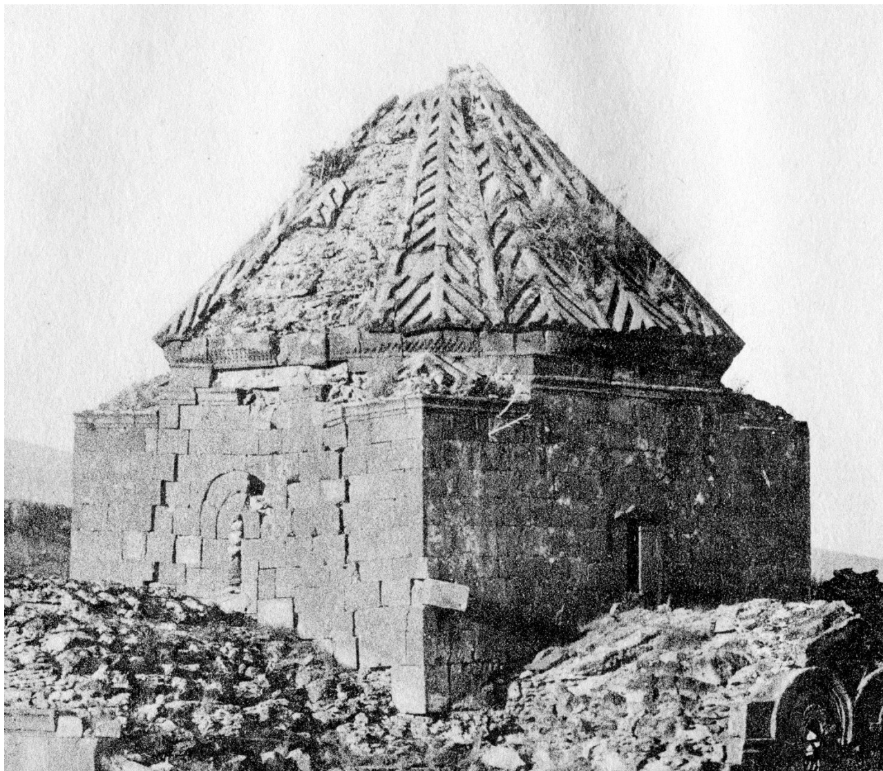
Fig. 49. Tekor. St-Serge (fin du v e s.). Tambour cubique archaïque. Dôme à faible ombrelle ajouté peut-être au début du xi e s. Photo N. Marr (1908).
