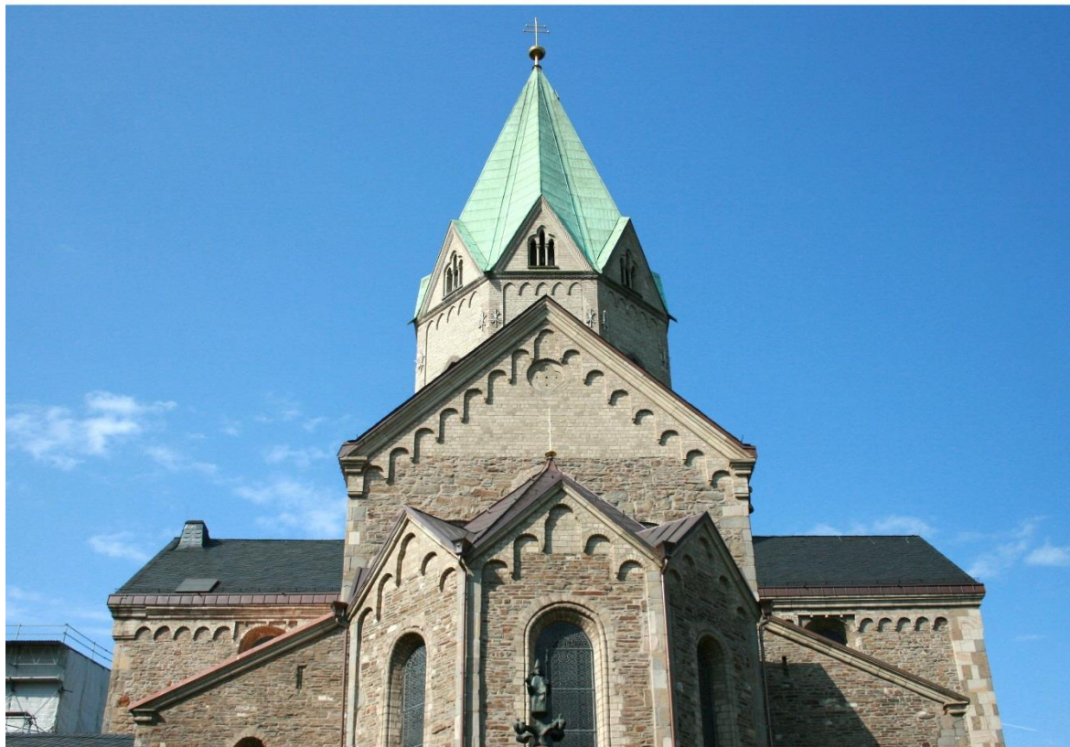
Fig. 109. Werden (Essen). Église St-Léger. Portion d'ombrelle à cinq plis sur l'abside (c. 1230). Détails de photos en ligne Von Beckstet - Eigene et https.commons , et Frank Vincentz et wikipedia.org .
