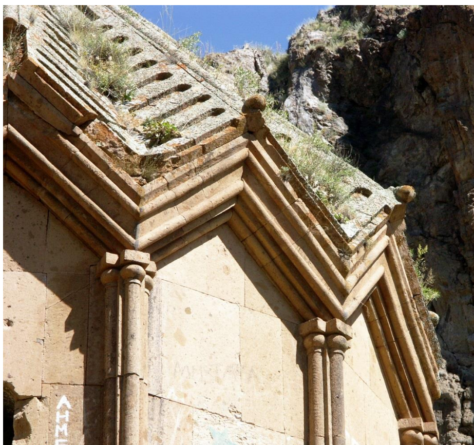
Fig. 51. Xckōnk'. St-Serge. « Antéfixes » en bec d'oiseau au sommet des pignons. Photo de 2013.
