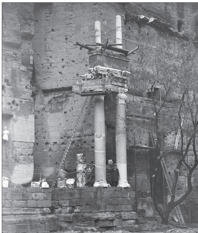
Fig. 194 - La restauration de quelques colonnes du front de scène en 1926 (cliché P. Abel, Médiathèque de l'Architecture et du Patrimoine, inv. n° MH0105870).
