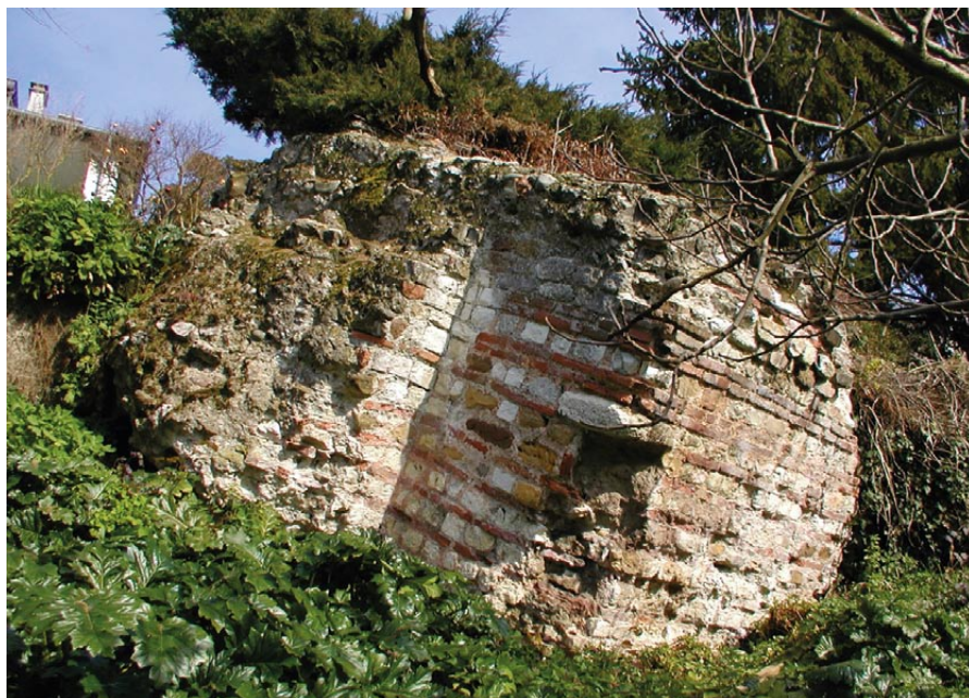
Fig. 21 : Élément du rempart antique de Beneharnum ayant basculé dans la pente (photo Jean-Pascal Fourdrin, IRAA-CNRS).
