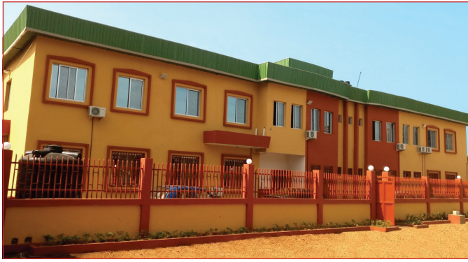
Figure 1. Vue latérale du Cerfig.
