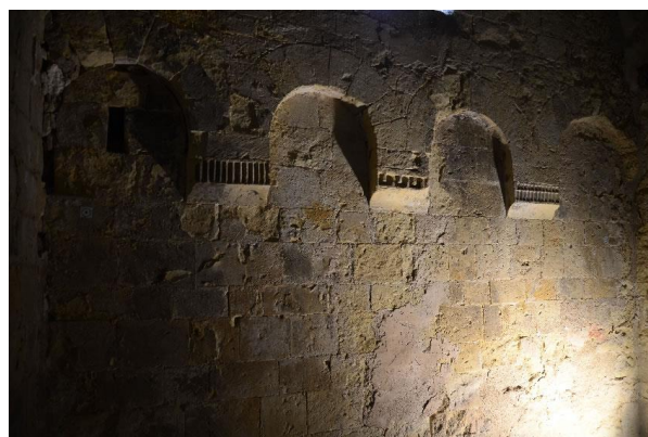
Castellane, chapelle Saint-Thyrse de Robion. Vue de détail des arcatures aveugles sur le mur pignon ouest de la nef (SDA 04).
