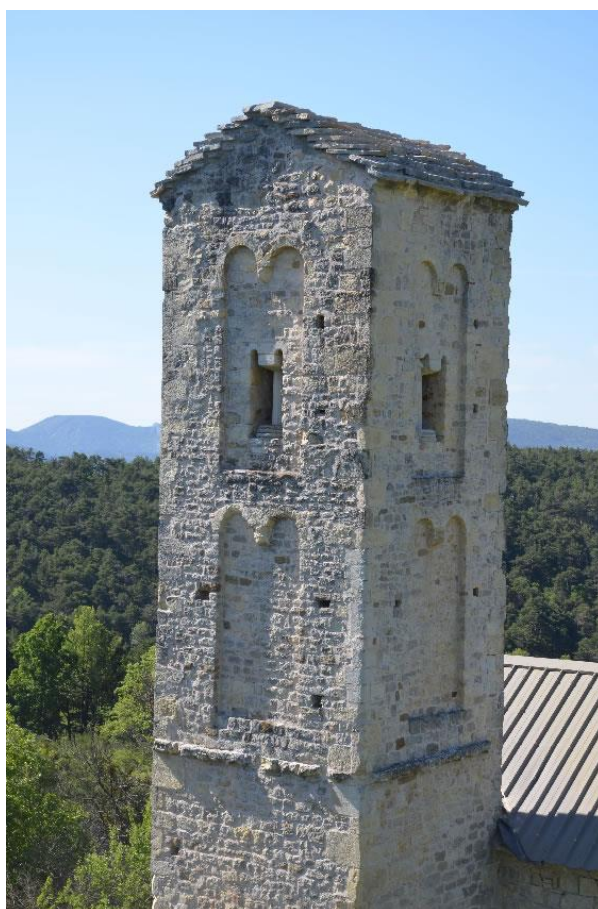
Castellane, chapelle Saint-Thyrse de Robion. Vue de détail des parties hautes du clocher depuis le nord-ouest (SDA 04)
