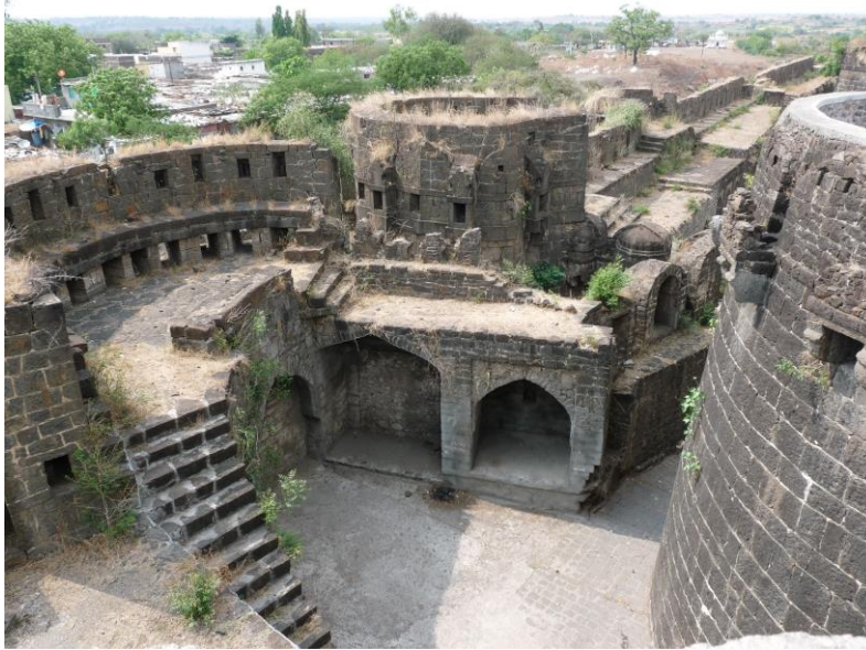
Figure 47 : vue de la barbacane de l'entrée P1
