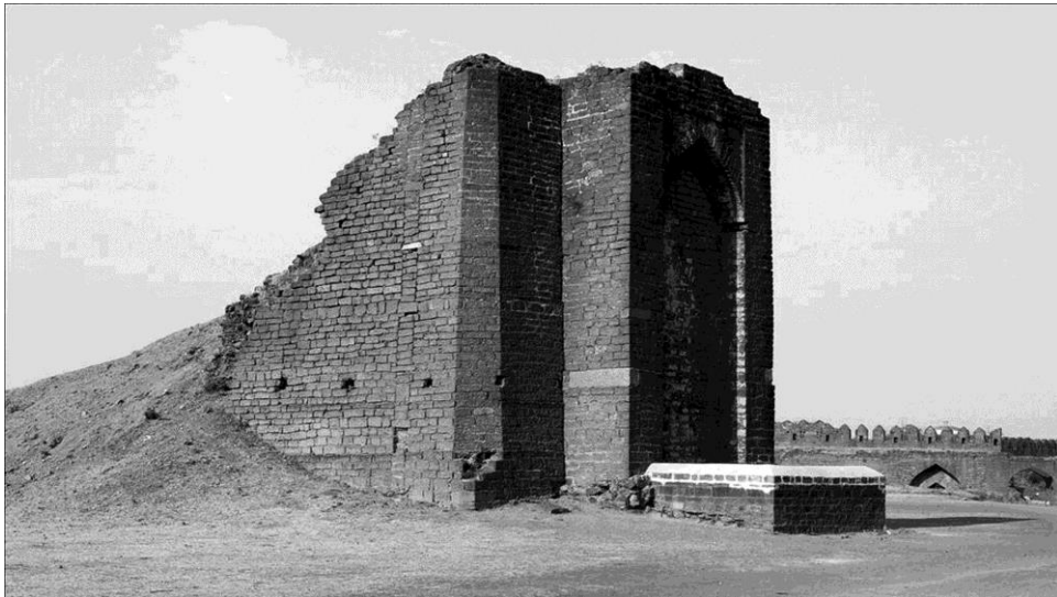
Figure 32 : tour à eau de Bidar (Kanataka)
