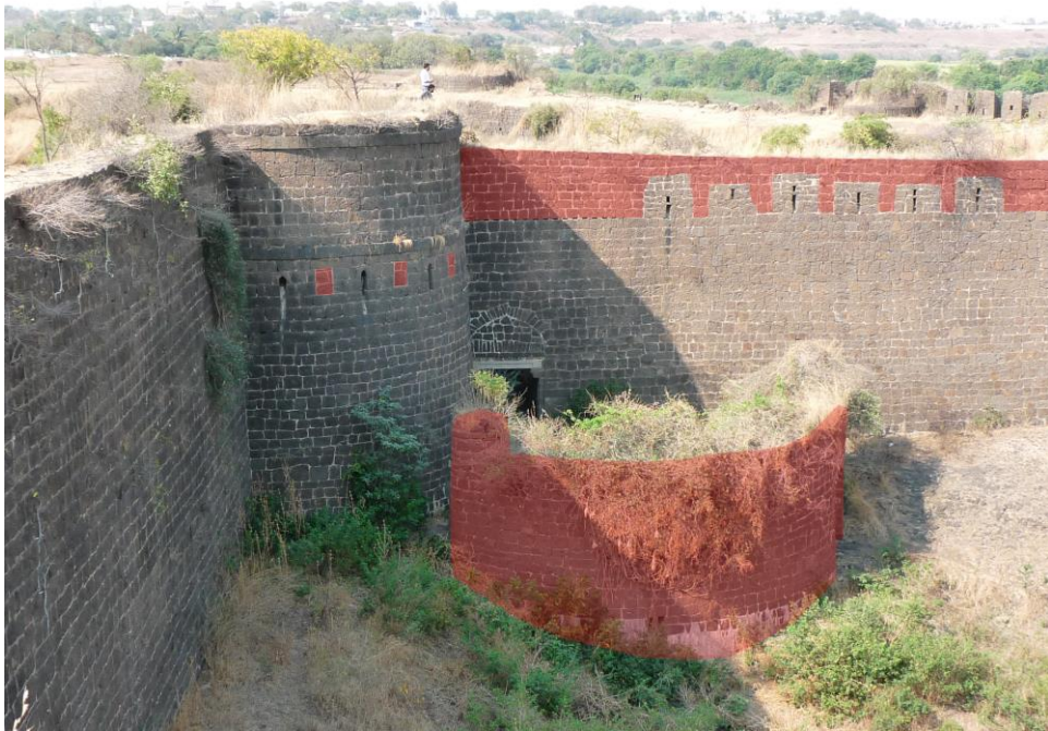
Figure 55 : surélévation de la fortification du Naya Qilah et ajout de la barbacane devant P5
