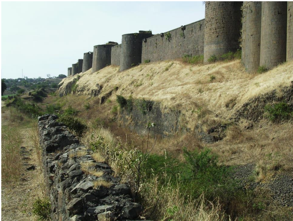
Figure 89 : front sud et le fossé
