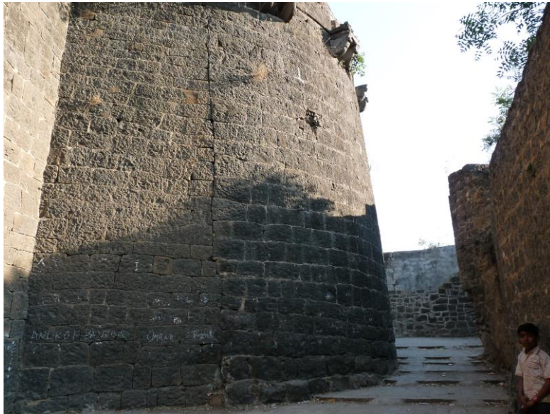
Figure 48 : coup de sabre correspondant à l'arrachement sur la droite de la photo (P1)
