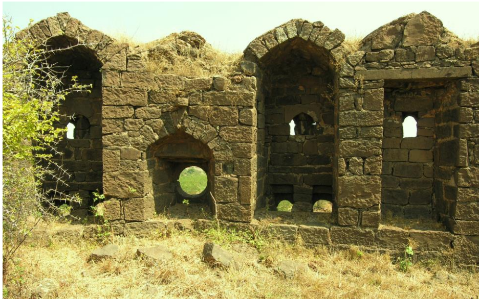
Figure 81 : éléments défensifs du parapet de Bidar, Purana Qilah , 17 ème siècle
