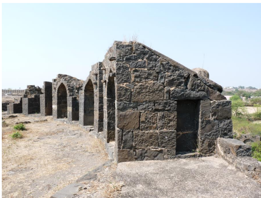
Figure 85 : merlons casematés des bastions d'angles 14 et 67
