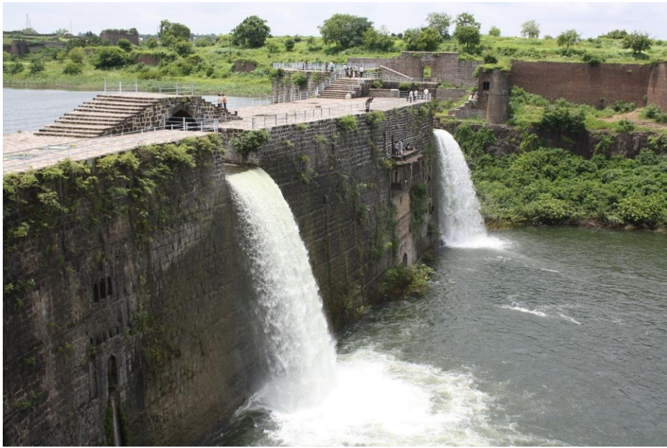
Figure 12 : lâcher d'eau du barrage de Naldurg, après la mousson
