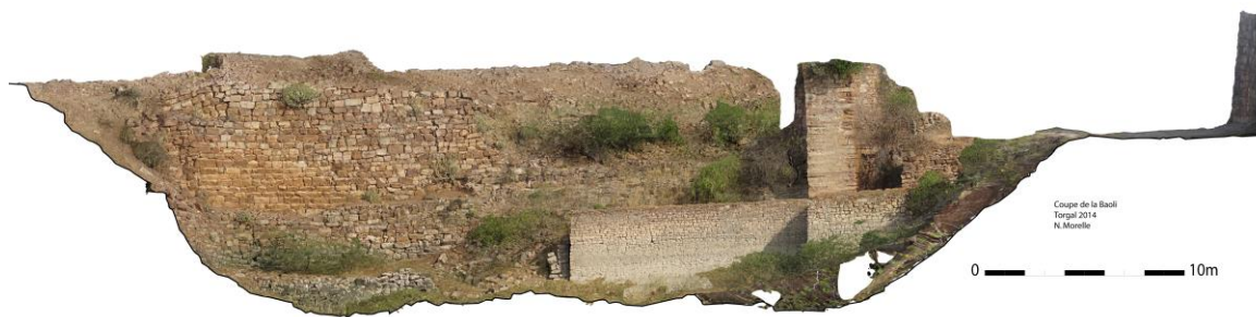
Figure 29 : coupe de la bâoli modifiée par l'ajout d'une tour à eau, Torgal (Karnataka)
