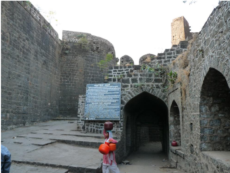
Figure 45 : le cheminement en chicane entre les deux enceintes fortifiées
