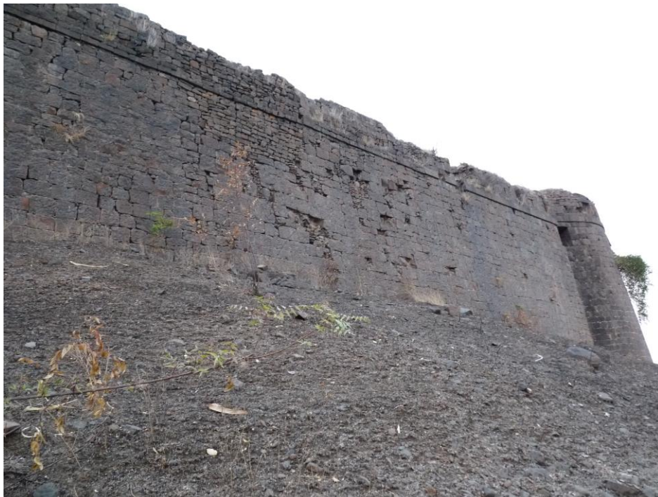
Figure 91 : partie du front sud criblée de marques de boulets métalliques avec réparations successives. Lors du siège de Kalyâna en 1656, le chroniqueur Moghol Muhammad Sâlih Kambû, 'Amal-i Sâlih rapporte : "some parts of walls of walls are subject to regular beating by several gun batteries to weaken these positions"
