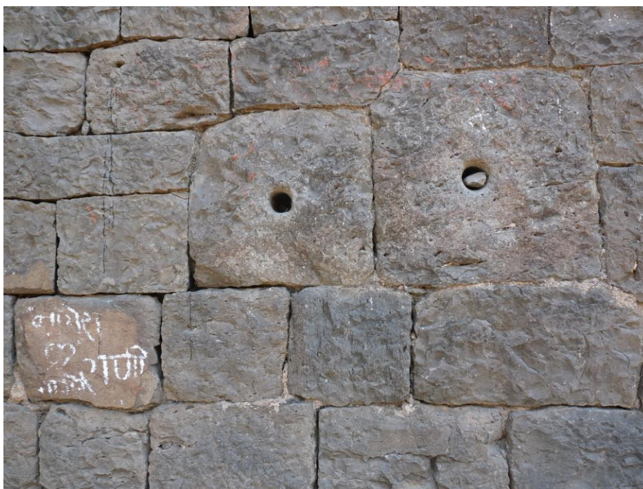
Figure 79 : éléments de base de pivot pour canon en réutilisation dans la fortification de Naldurg
