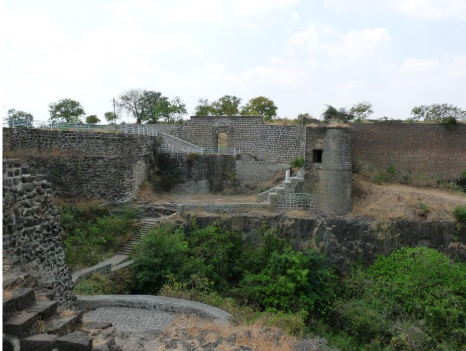
Figure 62 : vue des portes du Naya Qilah depuis le barrage
