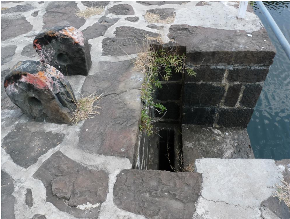
Figure 17 : écluse située sur la partie sommitale du barrage
