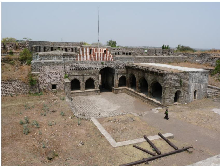
Figure 46 : vue de l'arrière de la porte principale depuis l'intérieur du fort
