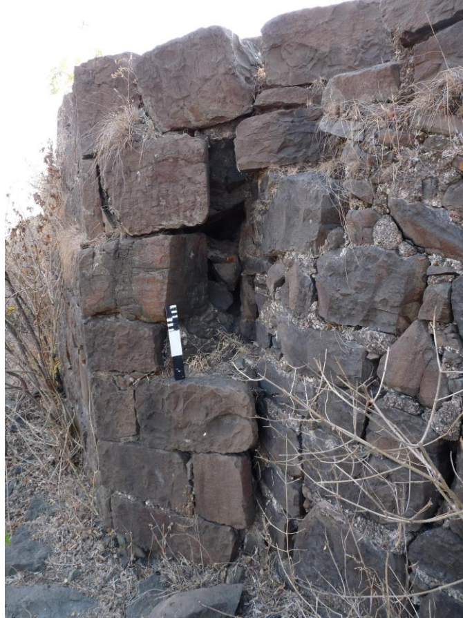
Figure 92 : rehaussement de l'enceinte des tours 33 à 39
