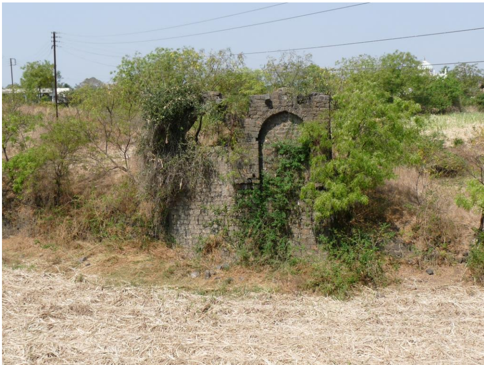
Figure 30 : tour à eau, extérieur du fort de Naldurg (ouest)
