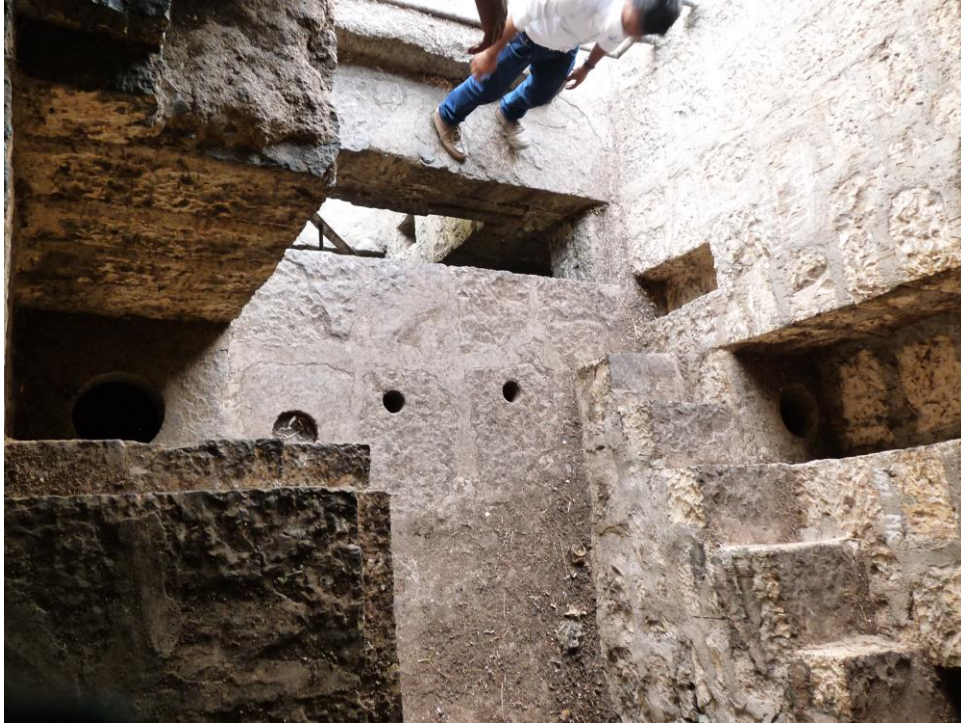
Figure 19 : arrivée d'eau à l'intérieur du barrage
