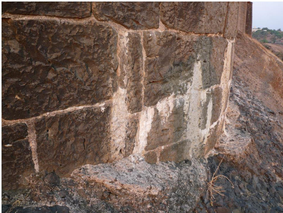
Figure 144 : coulée de chaux des joints sur la semelle de fondation (front sud de la fortification)
