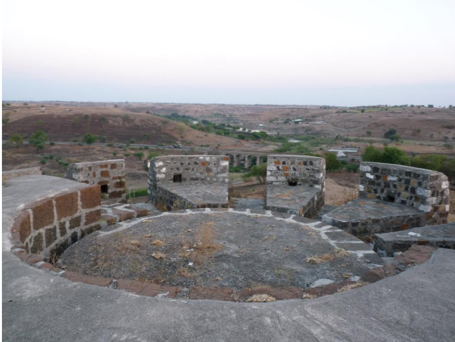
Figure 114 : plate forme sommitale de la tour polylobée de Naldurg
