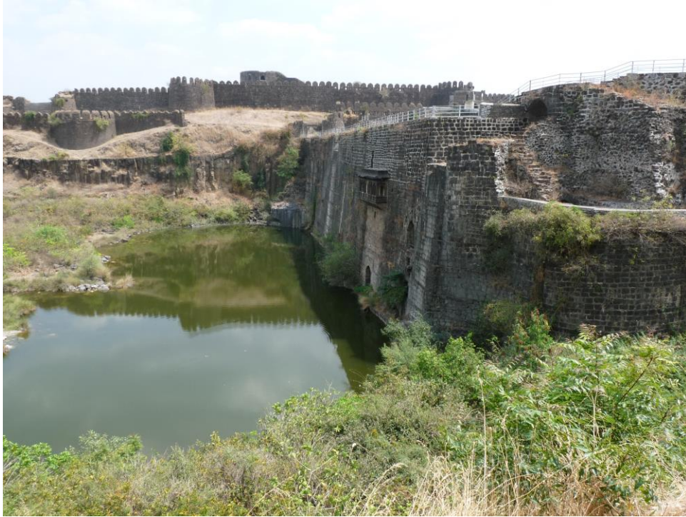
Figure 15 : vue du barrage côté aval avec le balcon du pani mahal
