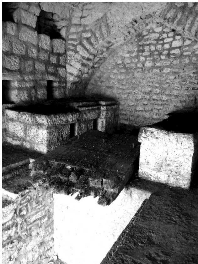
Figure 18 : chambre d'arrivée d'eau à l'intérieur du barrage
