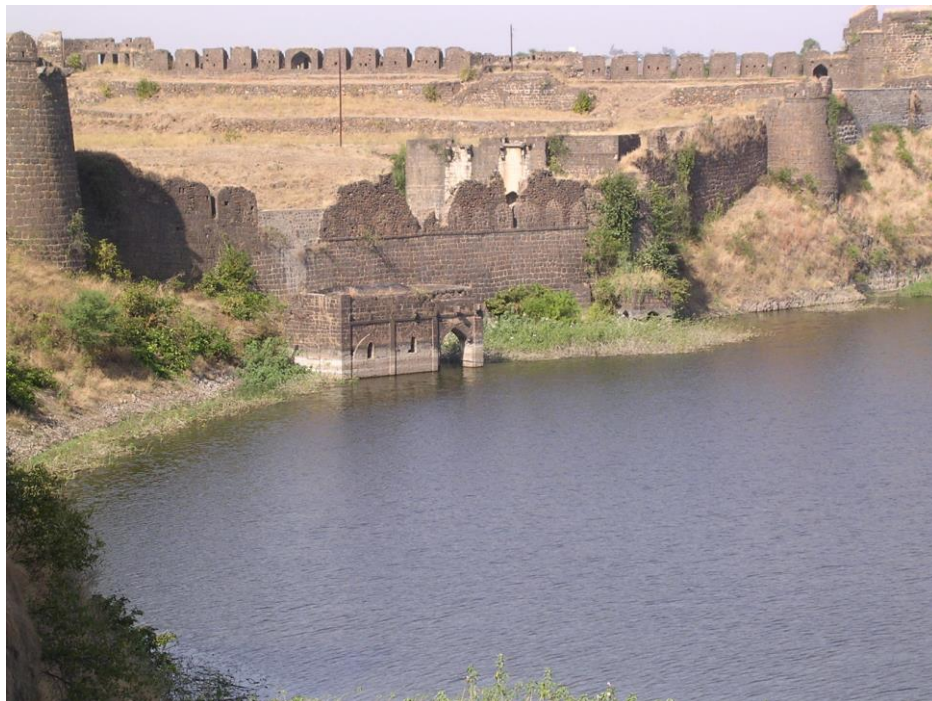
Figure 36 : bâtiment ouvert sur le lac de retenue avec la fortification derrière et la tour à eau en arrière plan
