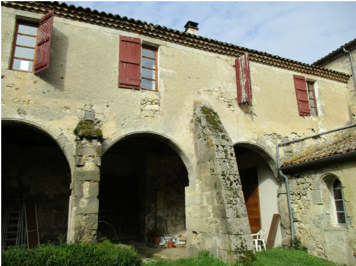
Doc. 6. Le cloître de Lannes, vue de la partie Est (XVIII e s. pour cette aile ?) en juin 2016. Photo S.A.
