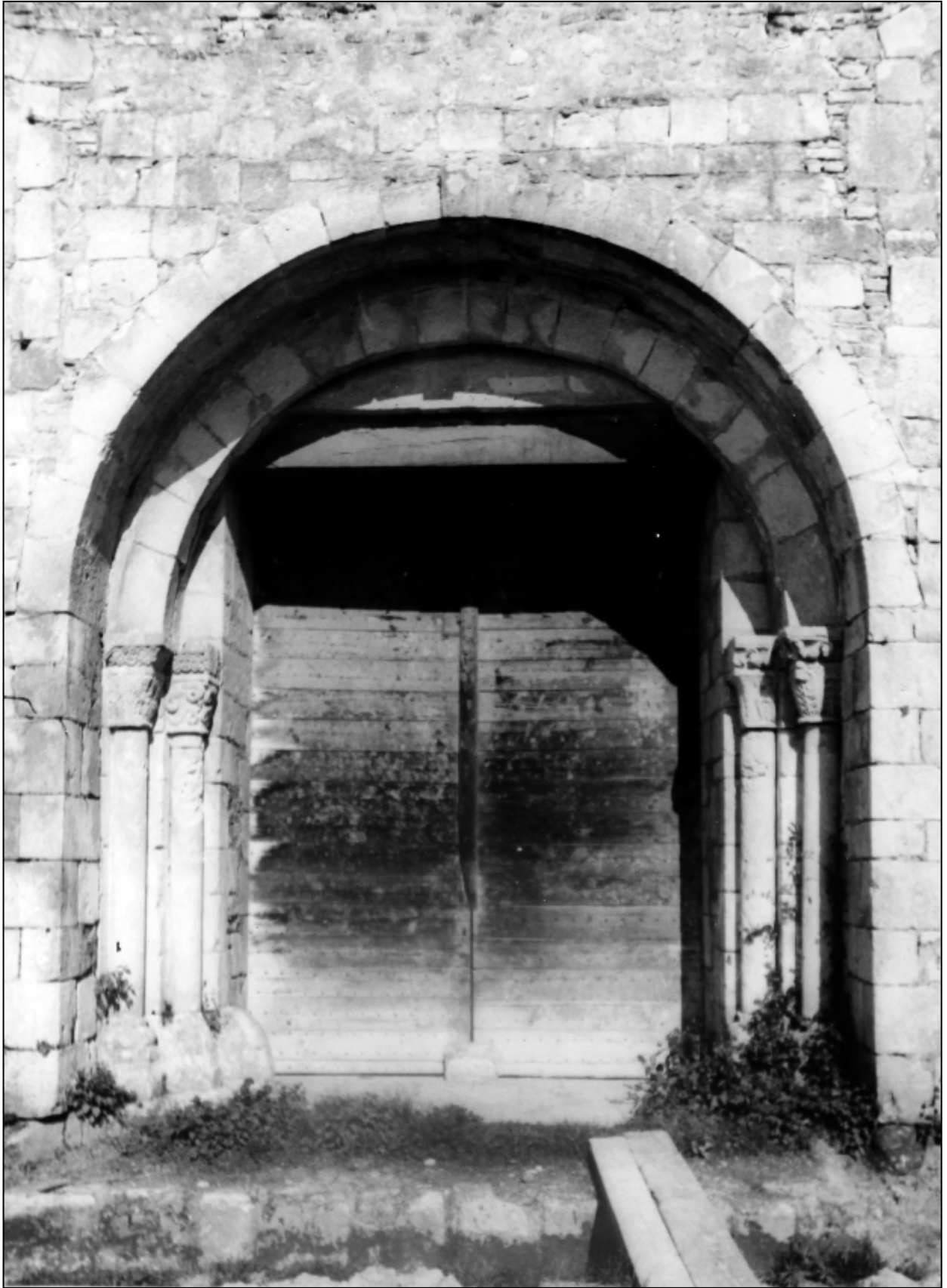
Doc. 9. Le portail ouest, reconstruit au XVII e siècle, lors de fouilles menées vers 1970. Remarquer les pierres de fondation du mur roman originel, devant le mur actuel. Photothèque de la médiathèque d'Arthous.
