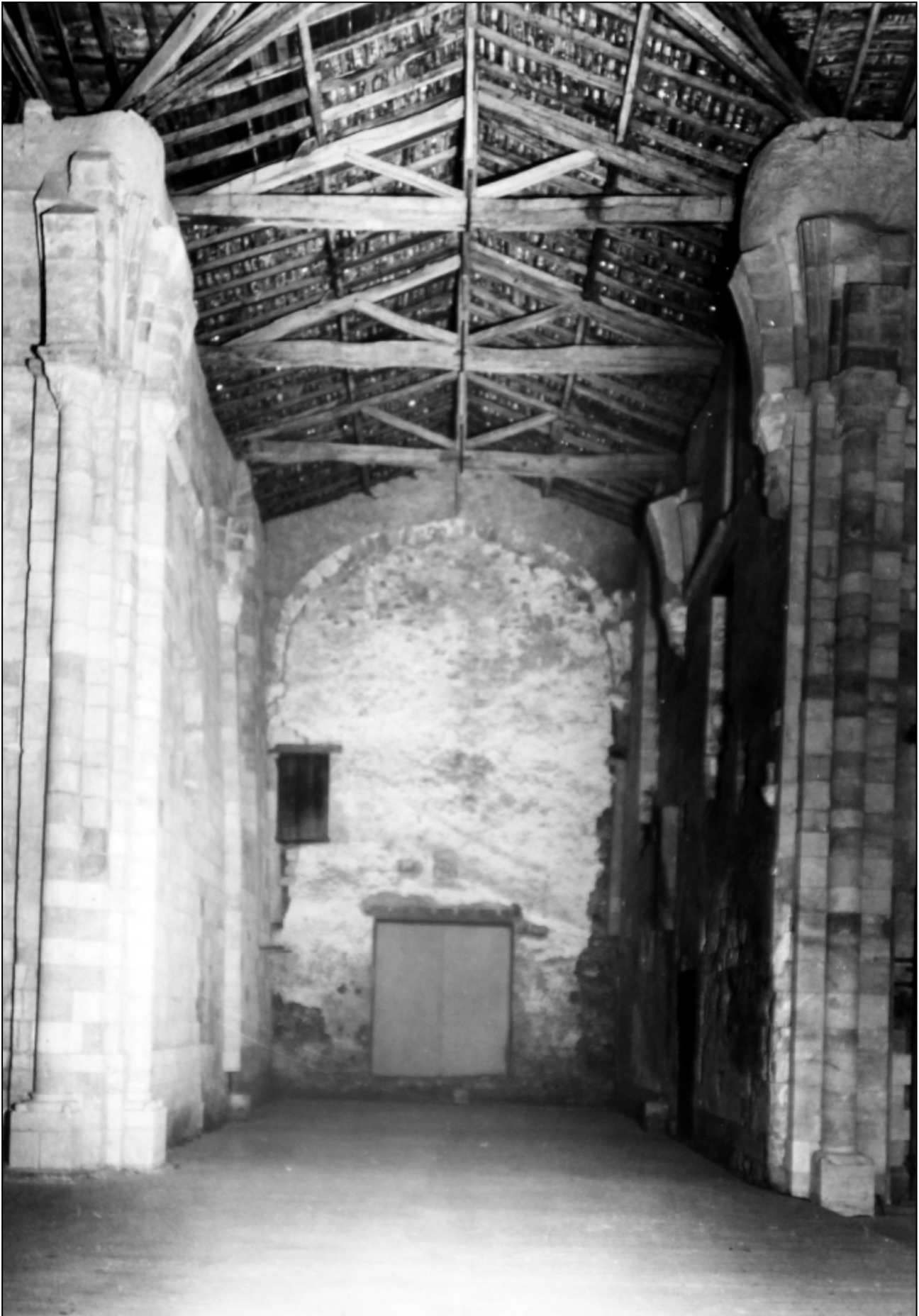
Doc. 8. La nef de l'abbatiale avant la démolition du mur de refend construit en 1727. Photothèque de la médiathèque d'Arthous.
