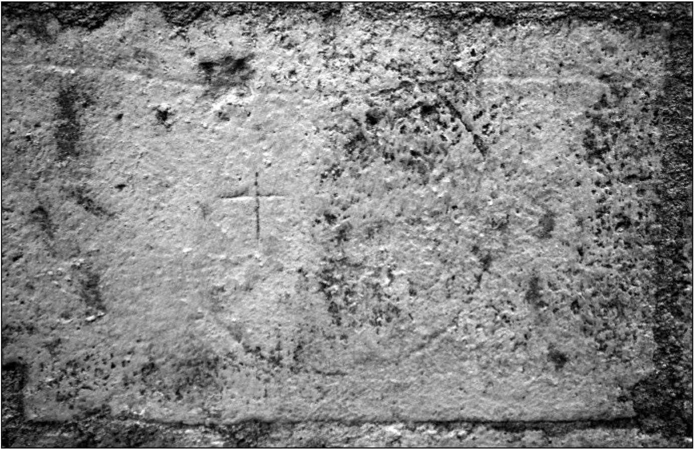
Doc. 31-32. Graffito circulaire peut-être employé pour la taille ou la pose d'une colonne romane. La croix est une marque de tâcheron. Relevé et photo S.A.
