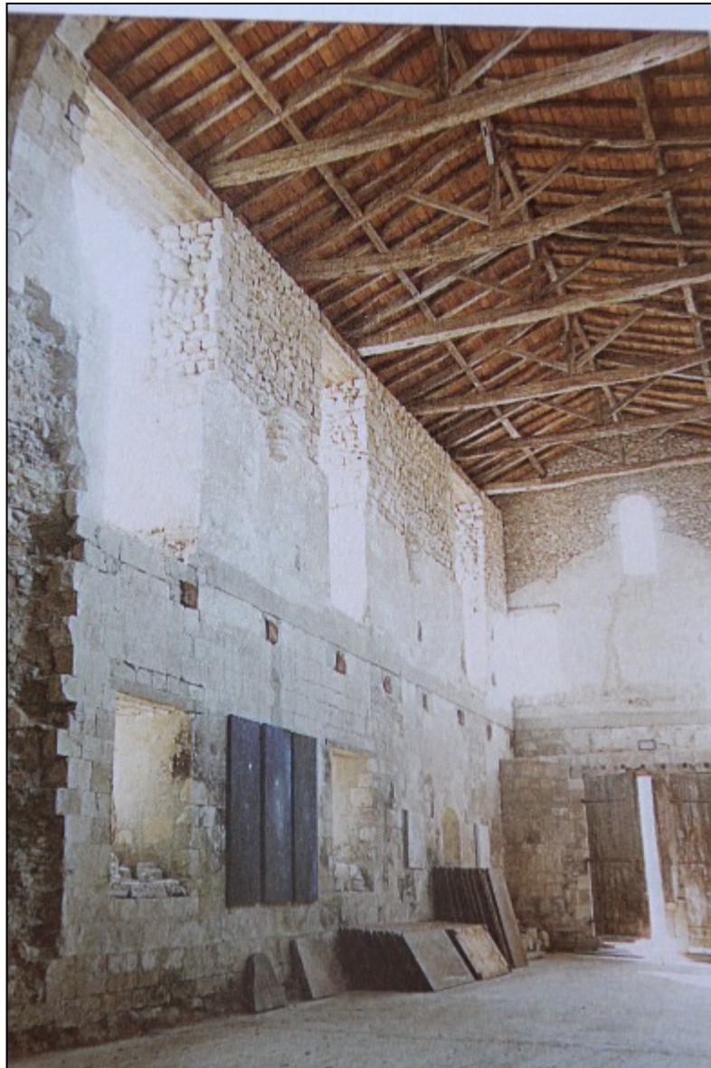
Doc. 84. Vue des premières travées de la nef avant la dernière phase de restauration : on distingue les trous du plancher intermédiaire posé au XIX e siècle pour servir de fenil et les larges ouvertures fenières pratiquées dans la partie haute du mur sud. Photo médiathèque d'Arthous.
