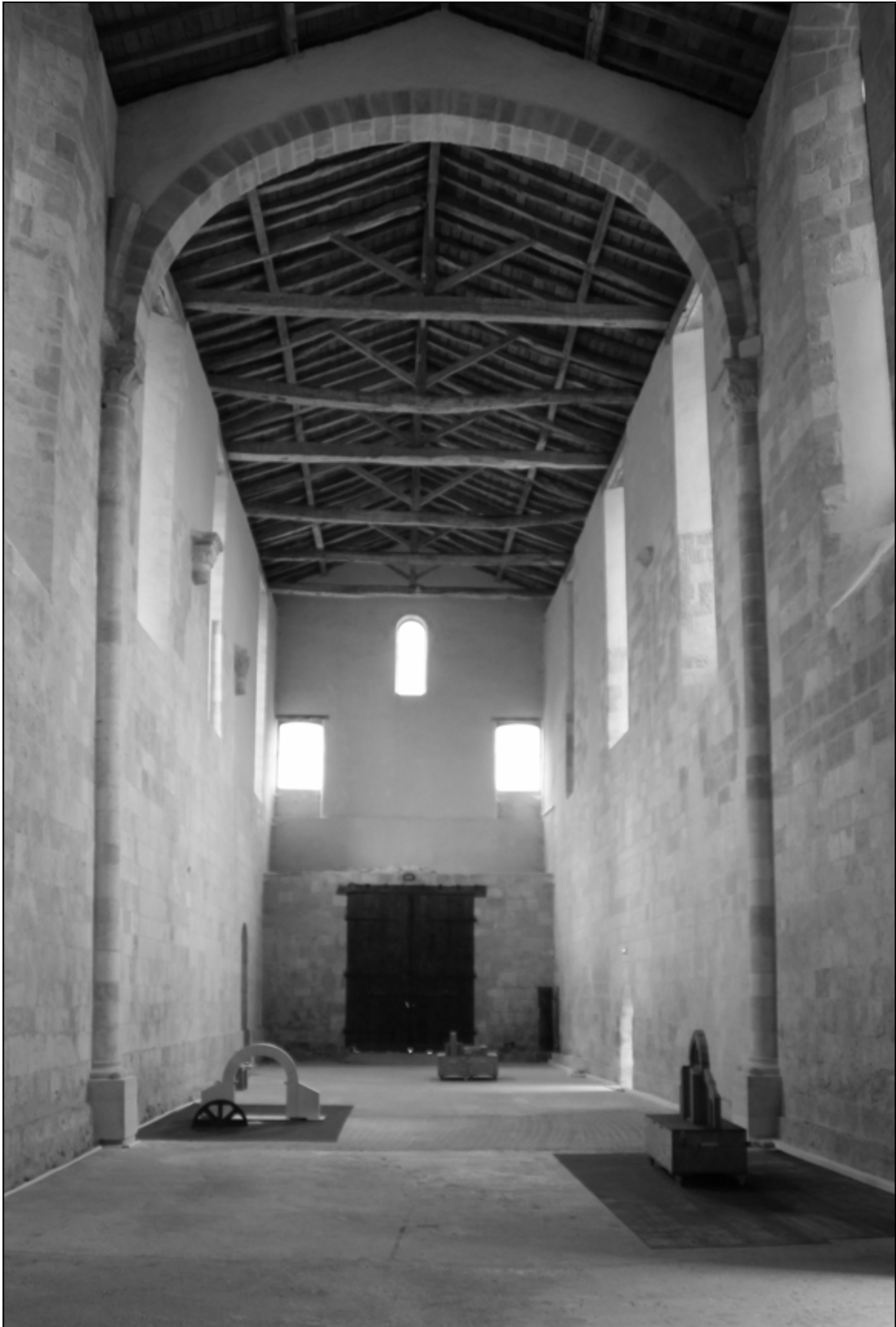
Doc. 11. Vue actuelle de la nef prise depuis la croisée de transept. L'arc doubleau a été restitué au niveau du mur de refend de 1727 détruit. Photo S.A.
