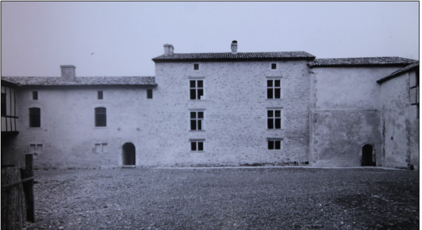
Doc. 92. Vue générale du logis abbatial avant 2000 (photothèque de la médiathèque d'Arthous) : de gauche à droite, on peut voir le réfectoire et les chambres des chanoines, le logis abbatial du XVII e siècle, le logis abbatial des XVI e -XVIII e siècles.
