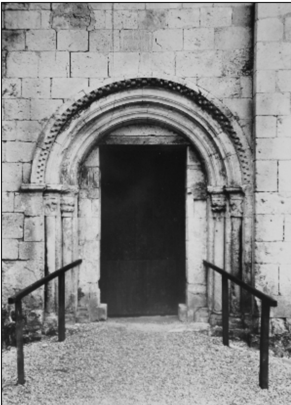
Doc. 4-5. Le mur gouttereau nord de l'abbatiale vers la fin des années 70. Remarquer la hauteur différente des murs de la nef. La voussure intérieure du portail roman nord n'a pas encore été restituée. Photothèque de la médiathèque d'Arthous.
