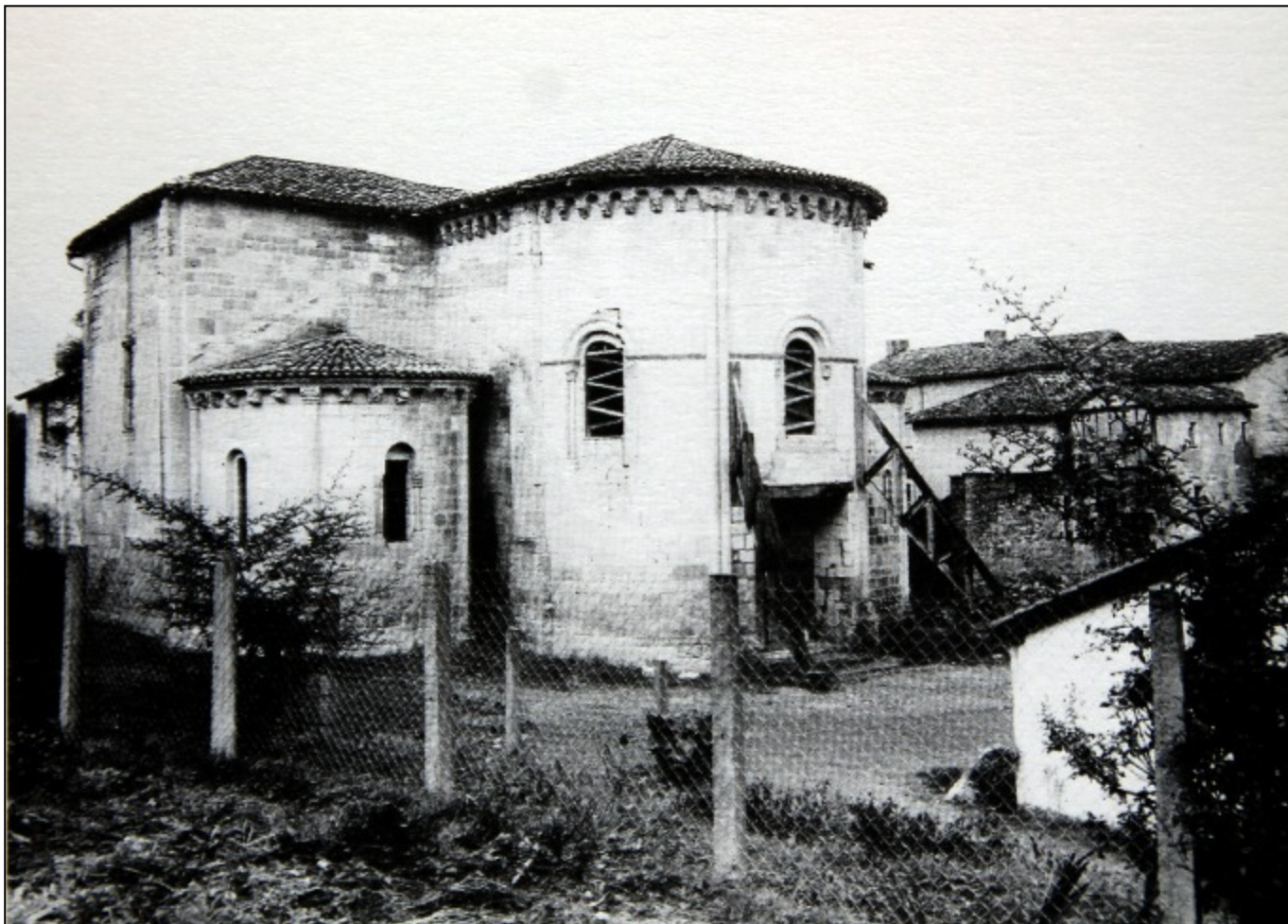
Doc. 2-3. Le chevet de l'abbatiale d'Arthous au début des années 60, au moment de la donation au Conseil général des Landes : remarquer les lézardes dans la maçonnerie et le portail ouvert dans l'abside centrale. Photothèque de la médiathèque d'Arthous.
