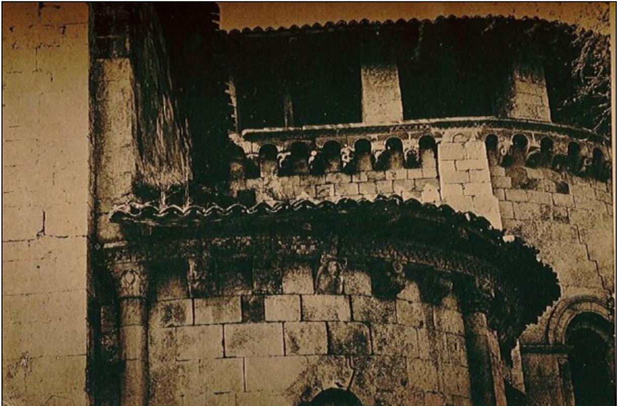
Ces trois photos, qui appartiennent manifestement à une même série, montrent ainsi l'état du chevet peu avant 1890 : l'abside centrale surélevée par des piliers portant la toiture ; les fissures au dessus des fenêtres romanes ; le déchaussement des pierres de la corniche sur l'absidiole nord, etc.
