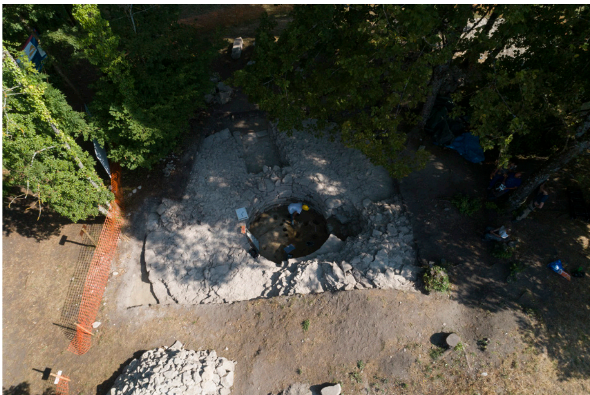
Fig. 20 : Emprise de la tour maîtresse dans le secteur nord. Cliché : O. Veissière (Patrimoine Numérique).
