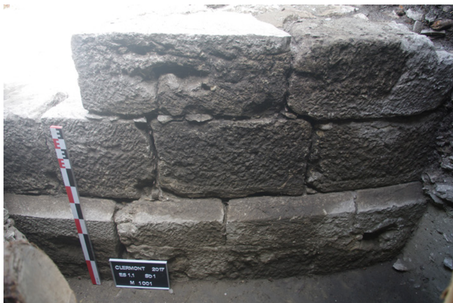
Fig. 106 : Chanfrein sur la tour maîtresse observé en 2017. Cliché: Equipe de fouille 2017.
