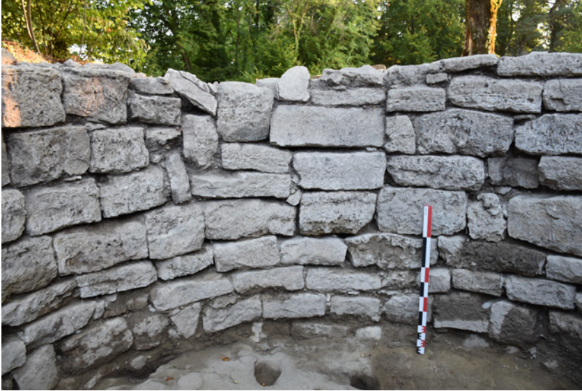
Fig. 26 a et b : Parement intérieur de M 1001. Cliché : Equipe de fouille.
