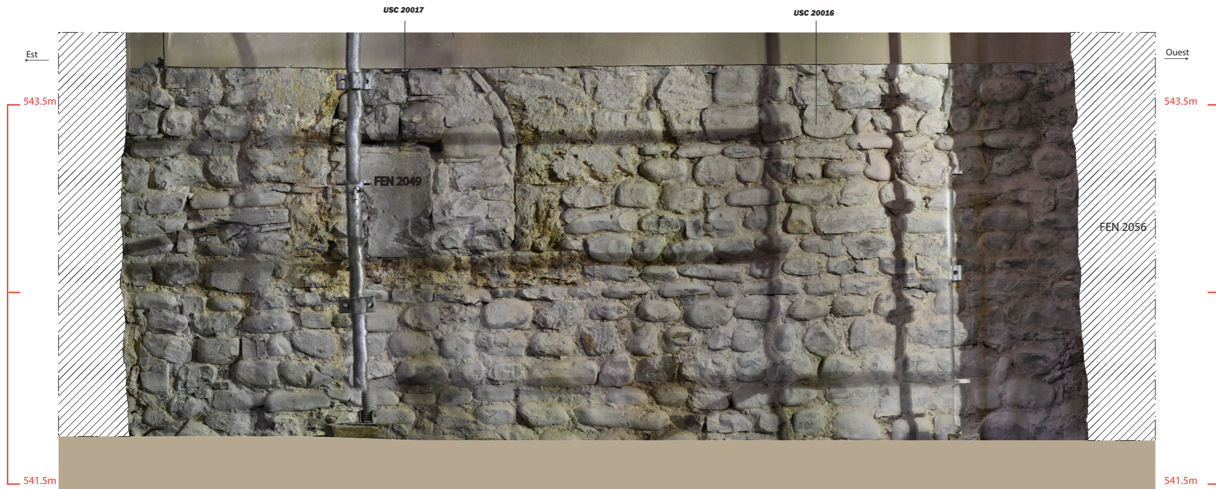
Fenêtre FEN 2049 bouchée
