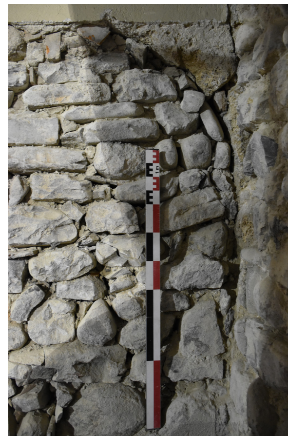
Fig. 28 : Départ d'arc en tuf conservé à l'extrémité ouest de M 2004. Cliché : L. Benoit (UAPB).
