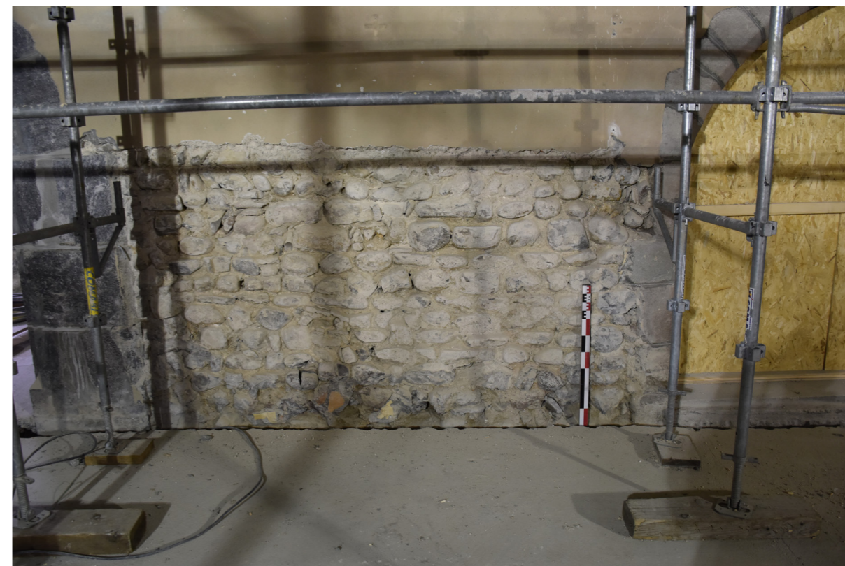
Fig. 31 : Parement USC 20020 venant boucher une ancienne ouverture. Cliché : L. Benoit (UAPB).
