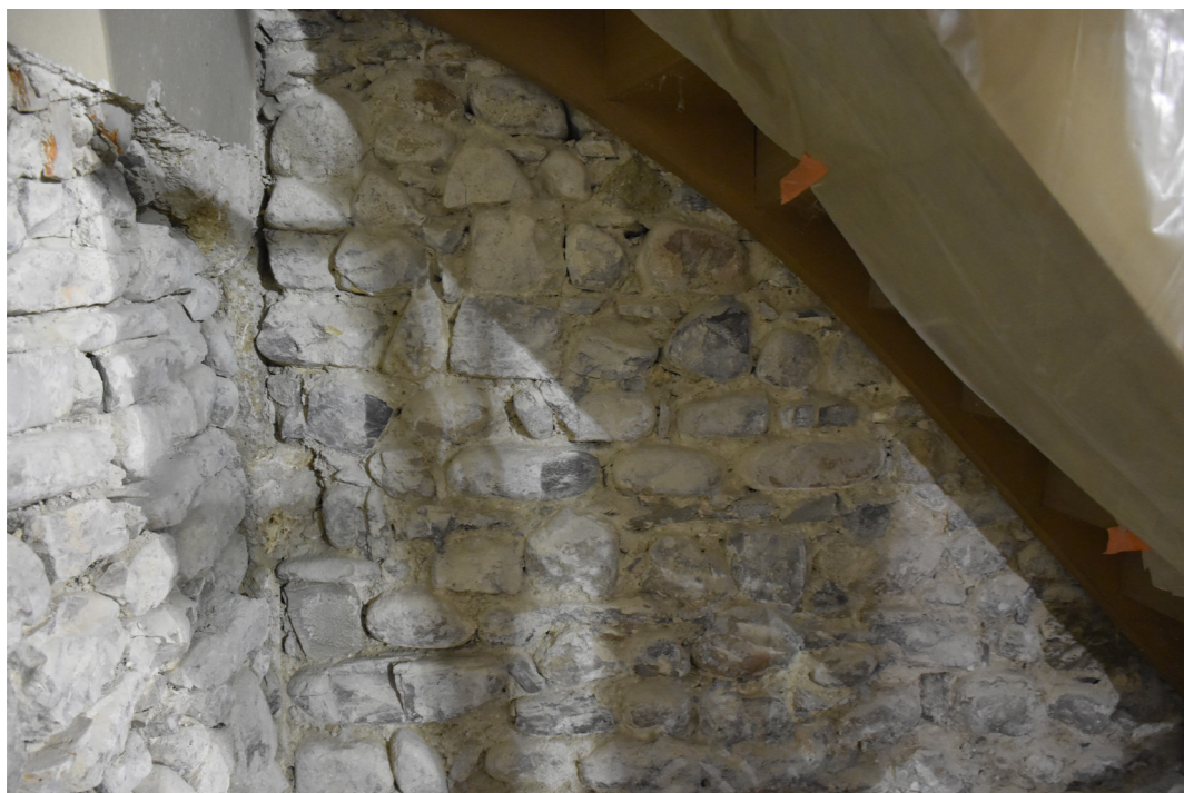
Fig. 45 : Extrémité sud du mur M 2001. Cliché : L. Benoit (UAPB).
