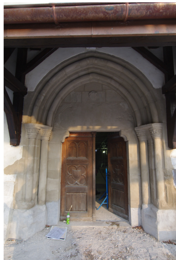
Fig. 43 : Vue d'ensemble du portail de la façade M 2001. Cliché : L. Benoit (UAPB).
