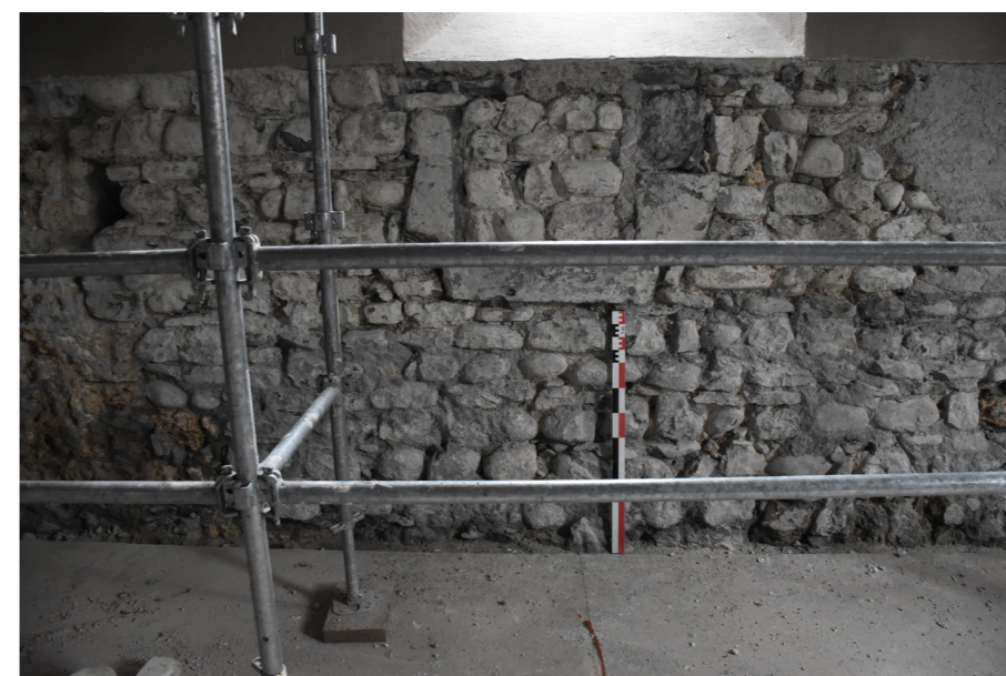
Fig. 22 : Structure indéterminée PLC 2051 aménagée dans le parement USC 20011. Cliché : L. Benoit (UAPB).
