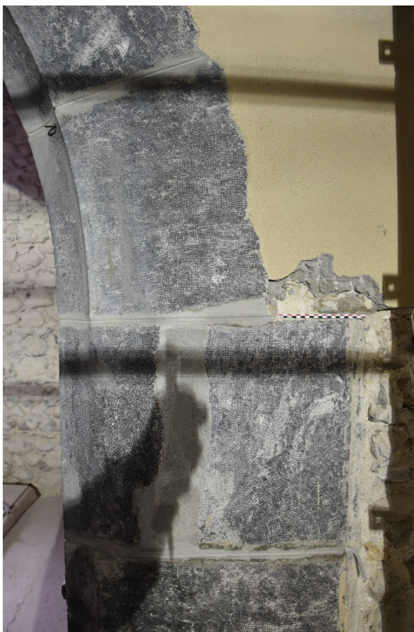
Fig. 30 : Détail de l'arc permettant l'accès à la chapelle latérale ES 2.3. Cliché : L. Benoit (UAPB).
