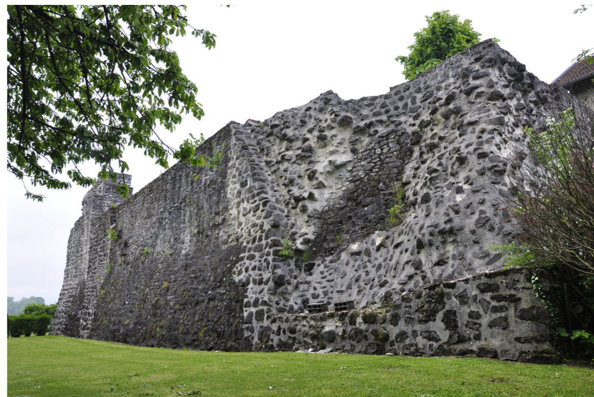
Fig. 5 : Vestiges de la courtine du château. Cliché : C. Guffond (UAPB).
