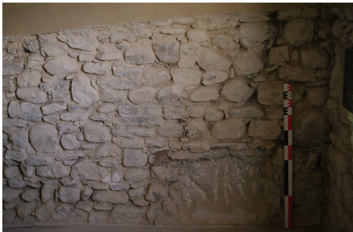
Fig. 33 : Parement occidental du mur M 2007. Cliché : L. Benoit (UAPB).
