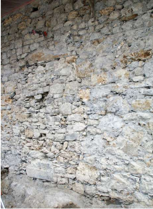
Fig. 58 : Porte - POR 2010 - latérale rebouchée. © Département de la Haute-Savoie / L. Ceci.
