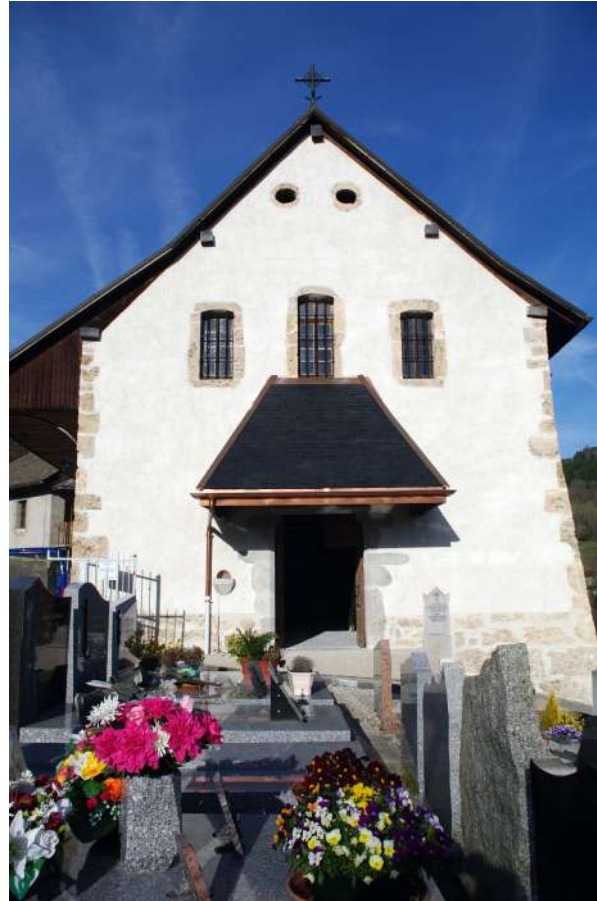
Fig. 35 : Façade sud-ouest où se trouve l'entrée principale. © Département de la Haute-Savoie / L. Ceci.
