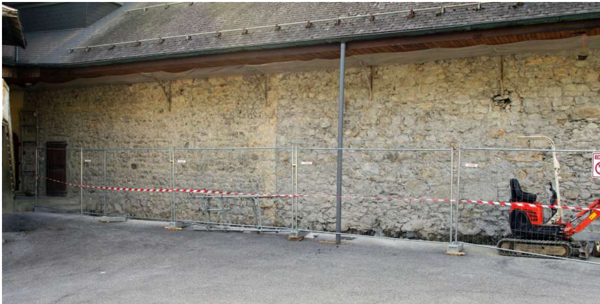
Fig. 1 : Mur nord-ouest de l'église. © Département de la Haute-Savoie / L. Ceci.
