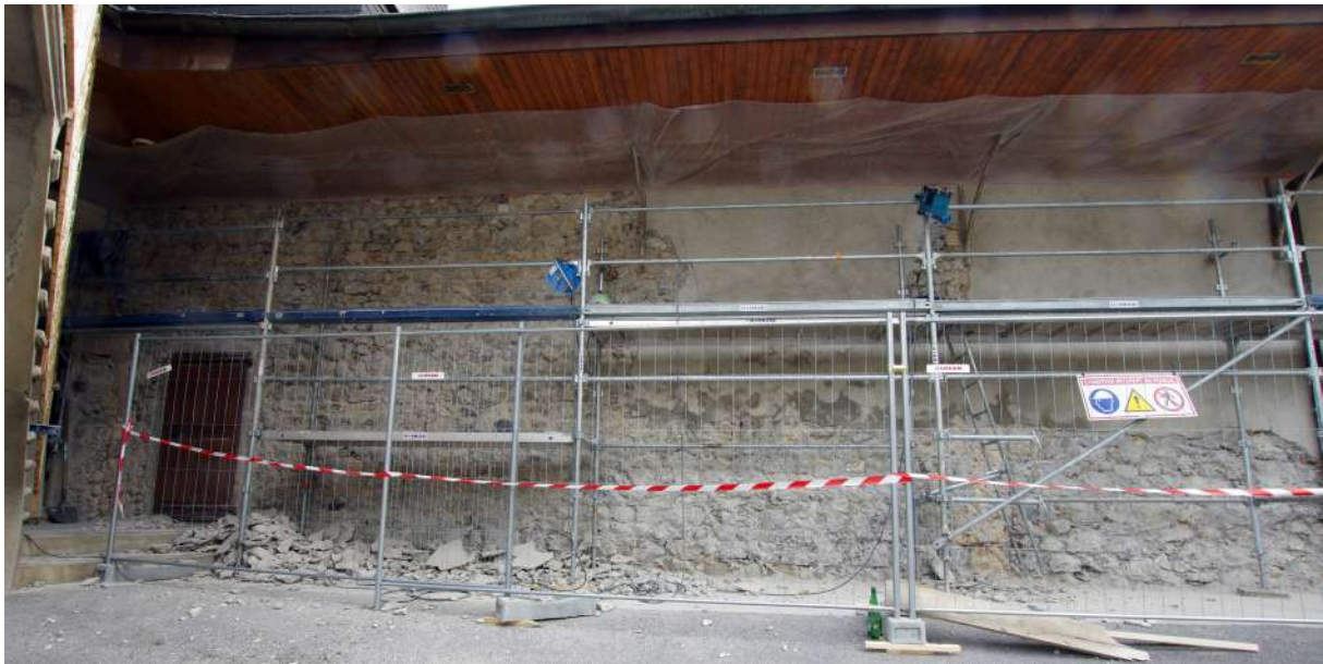
Fig. 20 : Échafaudage utilisé pour l'enlèvement de l'enduit extérieur. © Département de la Haute-Savoie / L. Benoit.
