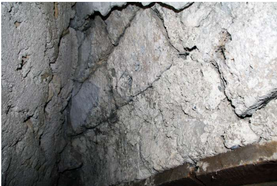
Fig. 73 : Vestiges probablement du cul-de-four de l'édifice primitif. © Département de la Haute-Savoie / L. Benoit.
