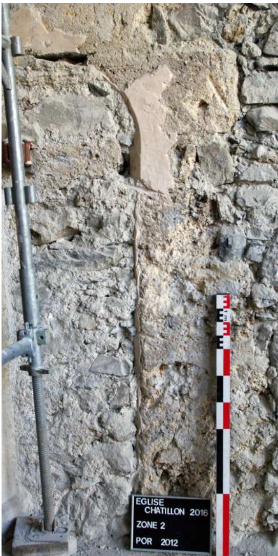
Fig. 51 (En haut à gauche) : Chaine d'angle qui sépare la première de la deuxième phase de construction.
