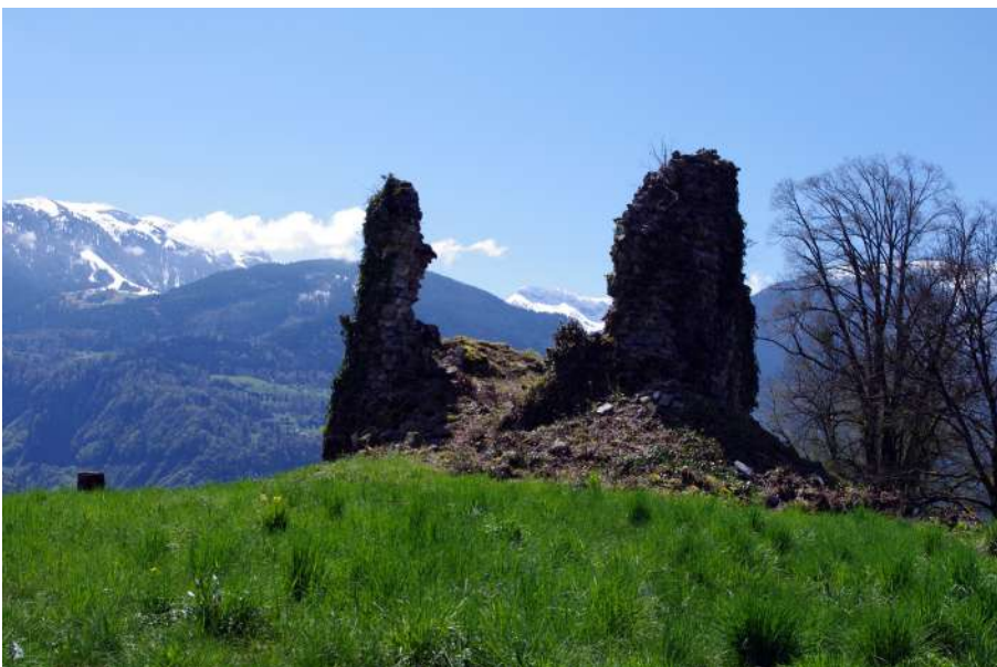
Fig. 29 : Ruines de la « tour maîtresse » du château de Châtillon. © Département de la Haute-Savoie / L. Benoit.
