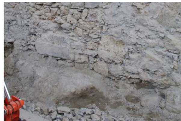
Fig. 60 : Un aménagement récent et fondation sur le substrat rocheux du parement de la Phase 3. © Département de la Haute-Savoie / L. Ceci.
