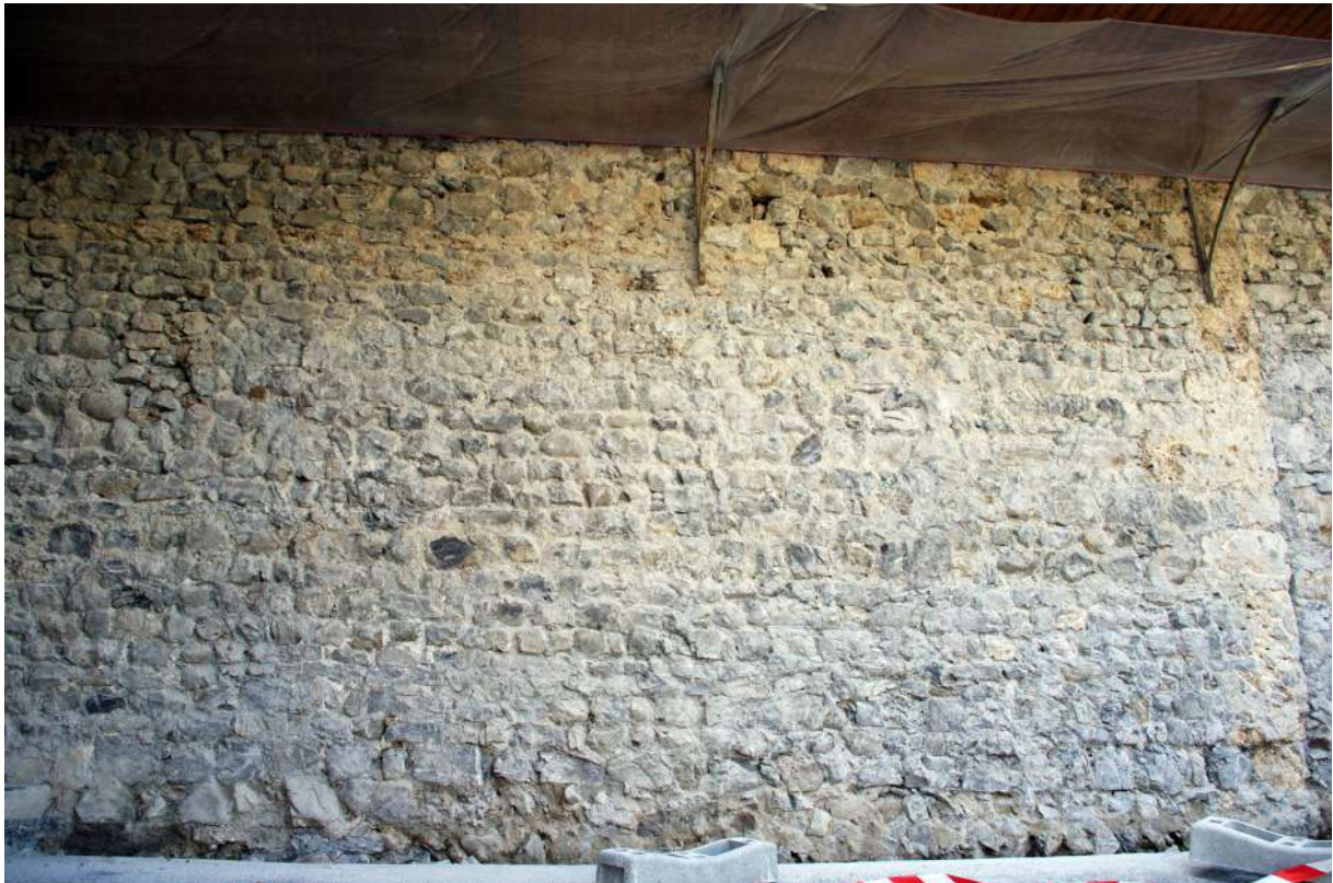
Fig. 49 : Parement nord-ouest de l'église. © Département de la Haute-Savoie / L. Ceci.ci.
