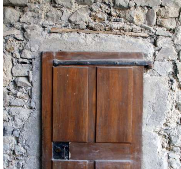
Fig. 59 : Partie supérieure de la porte latérale POR 2011. © Département de la Haute-Savoie / L. Ceci.
