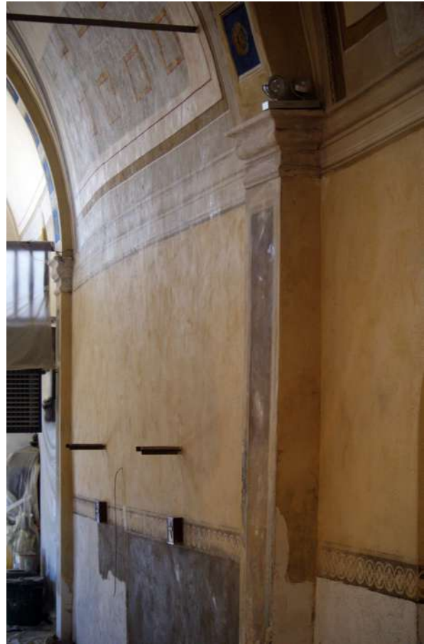
Fig. 54 : Chaine d'angle visible à l'intérieur et qui sépare la première de la deuxième phase de construction.
