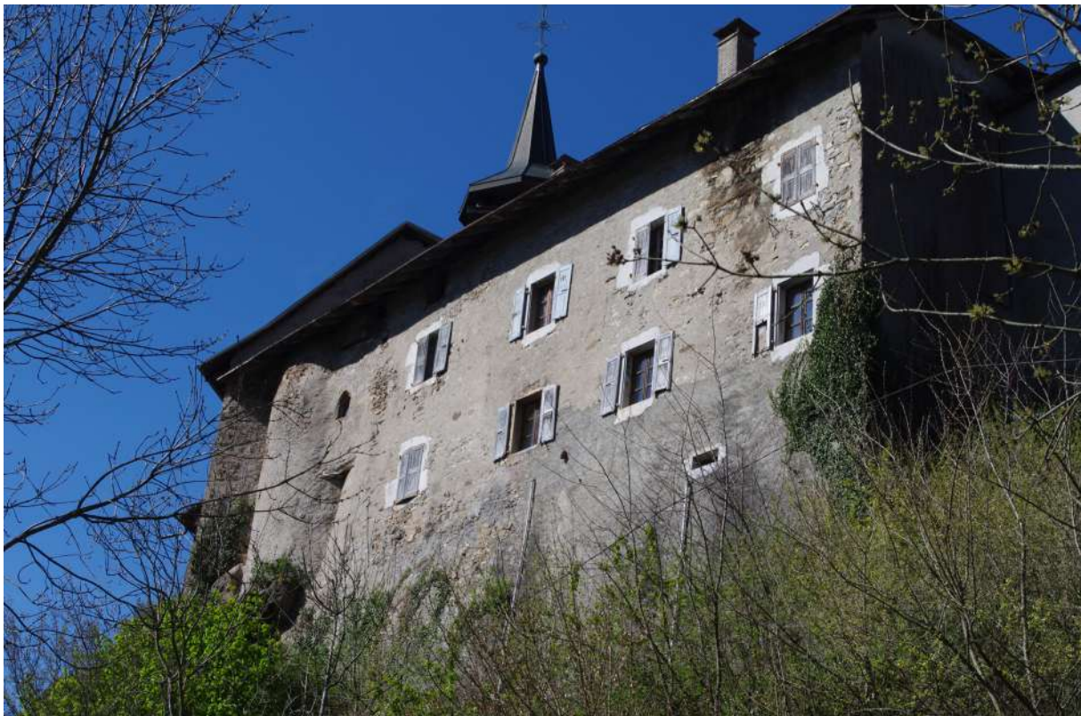
Fig. 15 : Mur nord-est du presbytère. © Département de la Haute-Savoie / L. Ceci.
