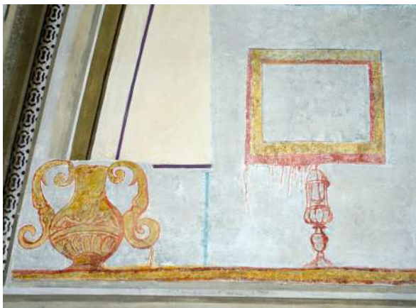
Fig. 47 : Décors dégagés par T. Vitaloni dans la nef. © Département de la Haute-Savoie / L. Ceci.
