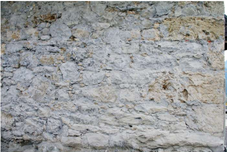
Fig. 70 : Parement de la Phase 3. © Département de la Haute-Savoie / L. Ceci.
