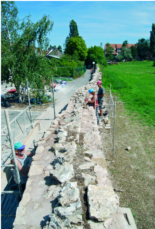
Fig. 3 – Vue de l'arase du mur et des deux états de fortification.
