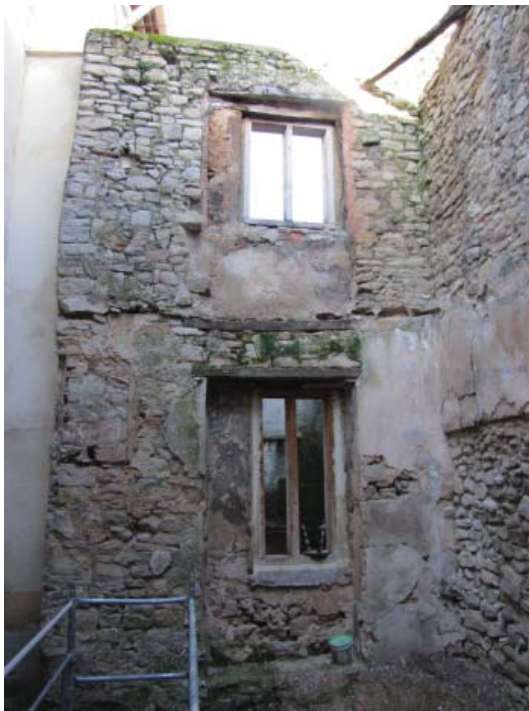
>Fig. 50 : Fenêtres des premier et second étages de la parcelle 128, vue depuis l'est
