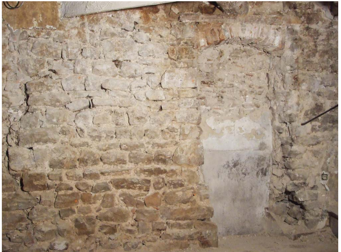
Fig. 18 : Mur MR 1003, parement interne (premier étage) et la fenêtre bouchée FN1017
