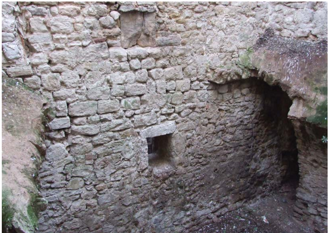
Fig. 40 : Parcelle 128, mur MR2109, parement sud
