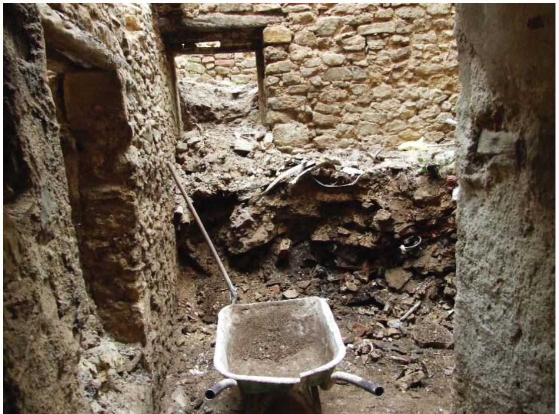
Fig. 4 : Maison de la parcelle 747 (premier étage) en cours de déblaiement.
