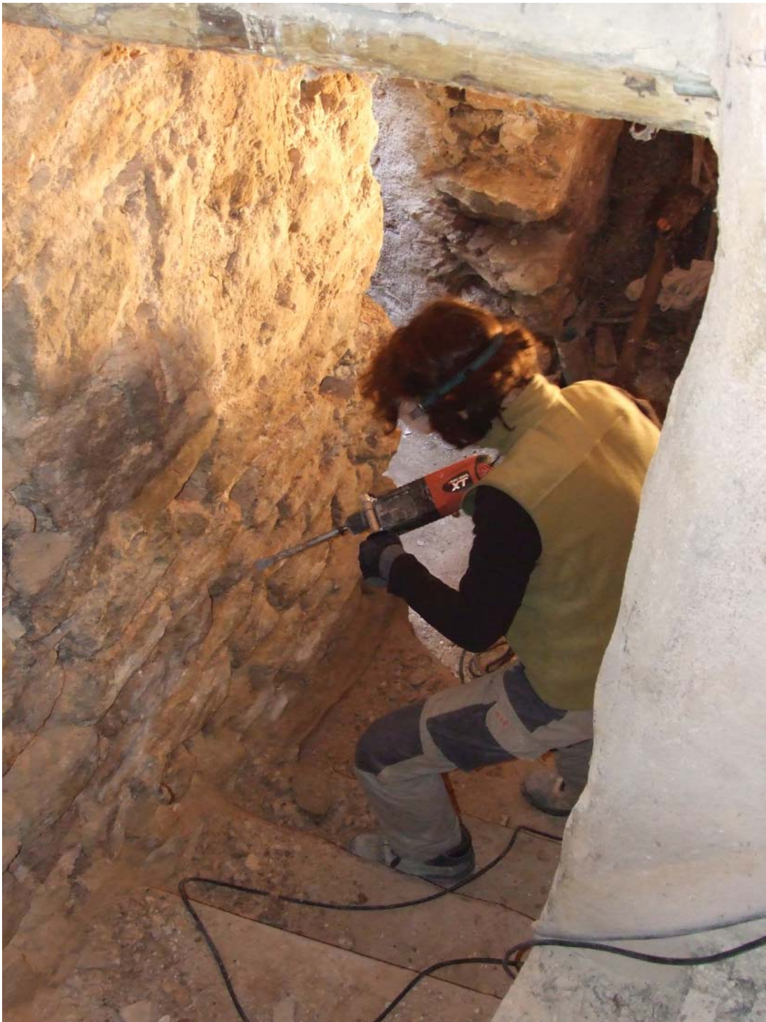
Fig. 5 : Décroûtage au marteau piqueur portatif
