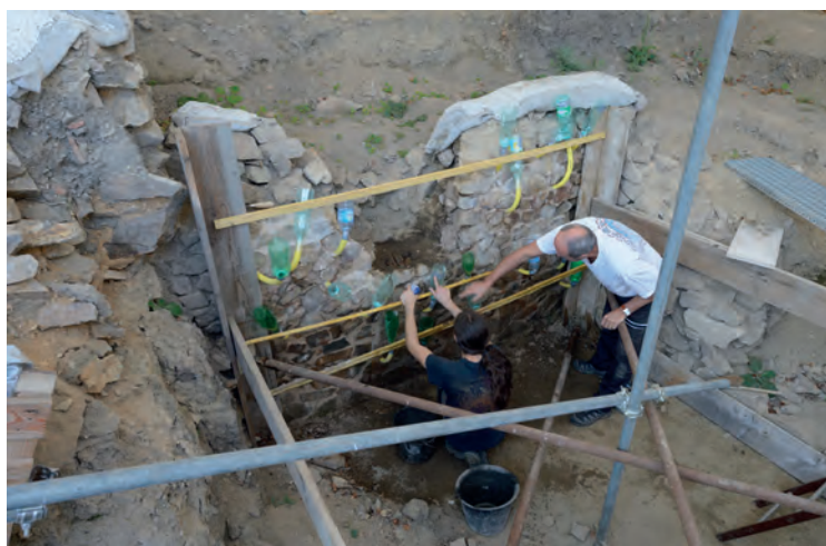
1. Bibracte, Mont-Beuvray. La domus PC2. Injection de chaux dans les murs de la cave AA.
