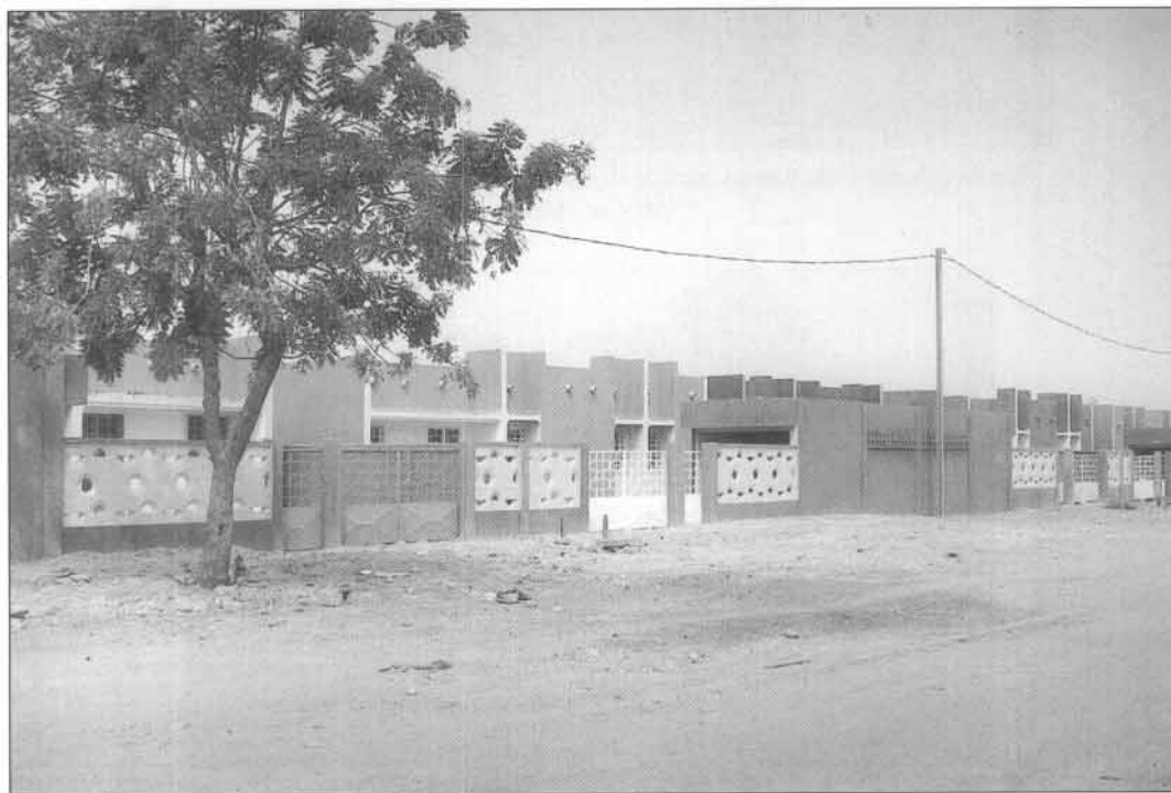
Cité AN IV A : les villas (février 1989).
