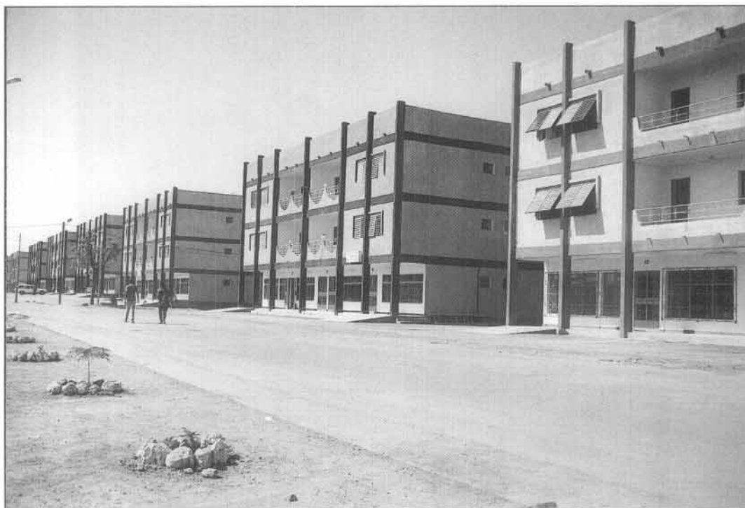
Cité AN III : les immeubles (mars 1987).
