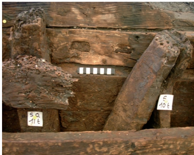
Fig. 32 : Détail de deux tenons de réparations inséré dans un bordage à partir de l'intérieur de la coque. On note des résidus de la poix utilisée pour étanchéifier l'assemblage (cliché G. Boetto).
