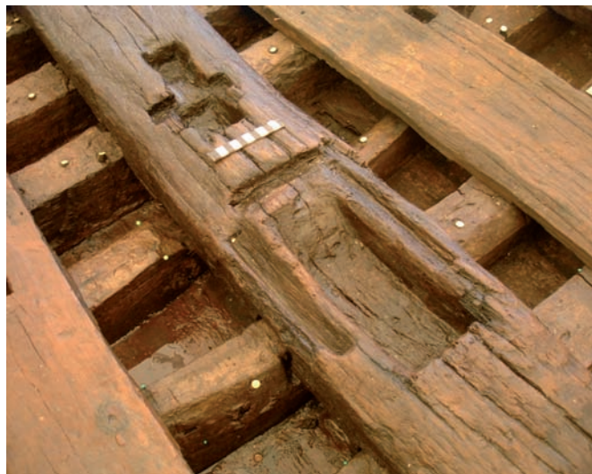
Fig. 26 : Vue depuis nord-ouest des encoches présentes sur la face supérieure de la carlingue/massif d'emplanture du mât. L'encoche plus grande, en premier plan, était destinée à accueillir le pied du mât. Elle est entourée d'entailles pour le logement du fourreau d'étambrai (cliché G. Boetto).
