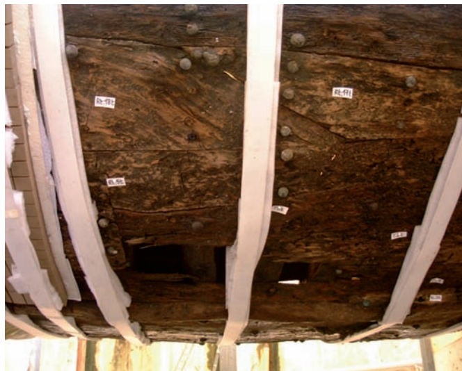
Fig. 9 : Vue de l'extérieur de la coque de la voie d'eau située entre le galbord et le ribord, flanc tribord (cliché G. Boetto).
