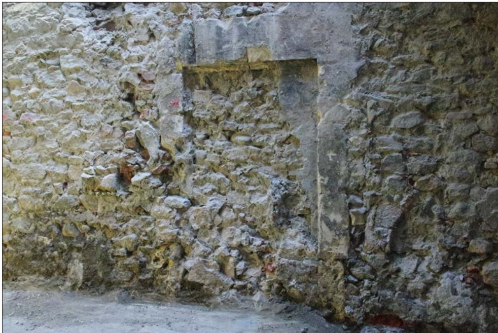
1. Porte P 49 perturbée par des bouchages récents à gauche
