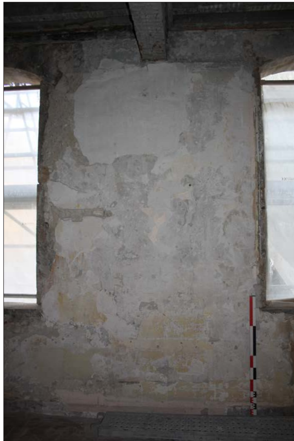
2. Portion de mur enduite entre les fenêtres F 13 et F 14
