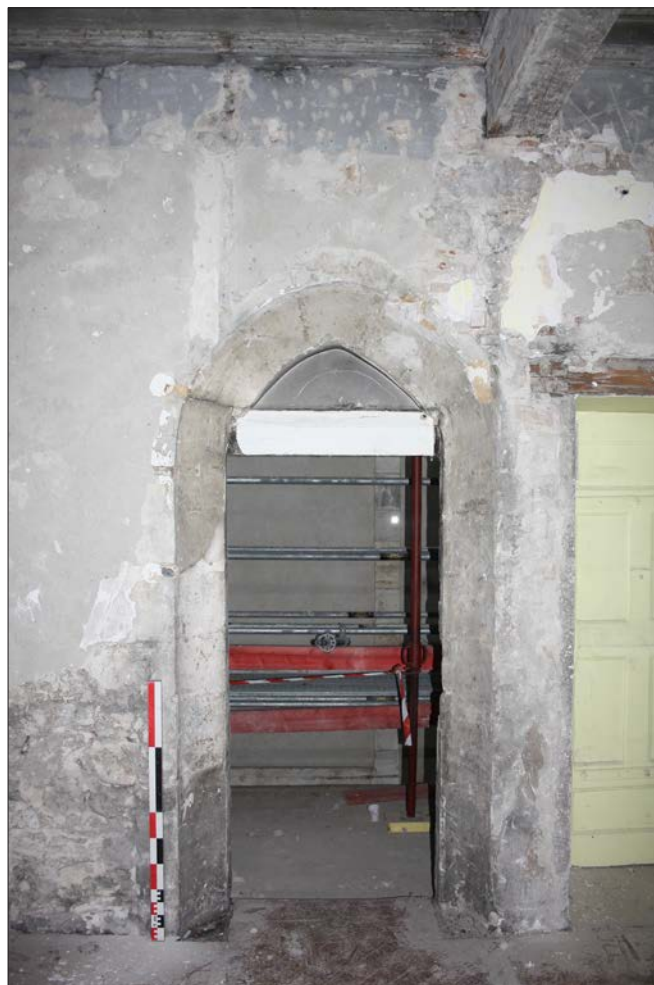
1. Parement nord : porte P 96, aménagée dans la fenêtre F 2/32
