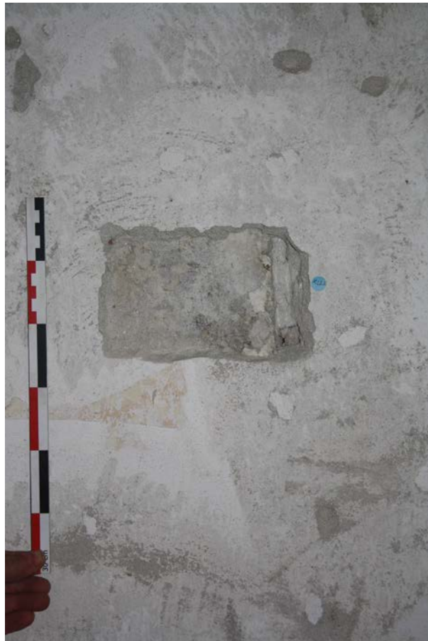
2. Micro-sondage : fragment du piédroit ouest de la fenêtre F 4
