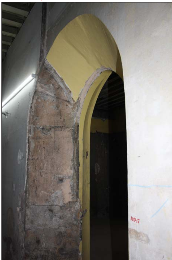
2. Parement sud, fenêtre F 7/48 : détail du piédroit ouest et de l'arc
