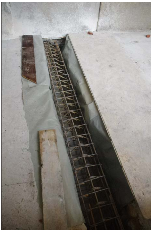
2. Vue générale du sondage 14.1 :éléments métalliques
