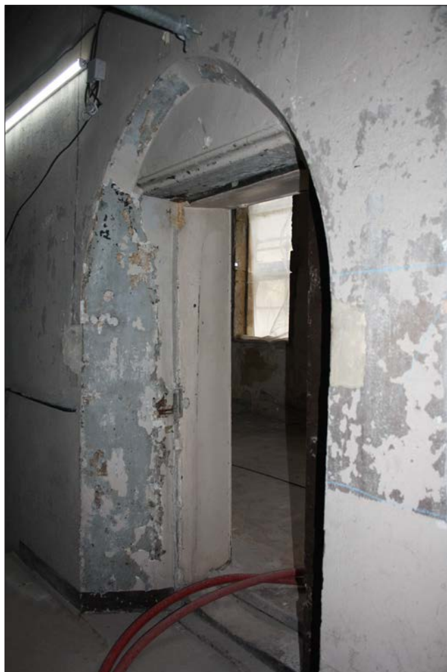
1. Porte P 97 aménagée dans la fenêtre F 3/30
