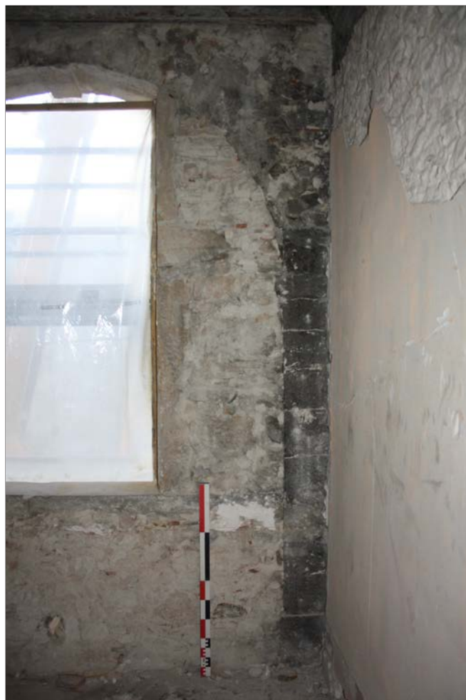
1. Jonction des murs nord (MR 1) et est (MR 2) : pilier est de l'arcade A 108
