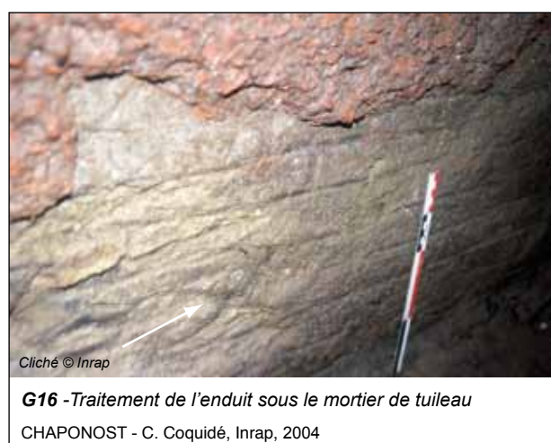
Fig. 28. L'enduit hydraulique, rainurage sous enduit pour accroche.
