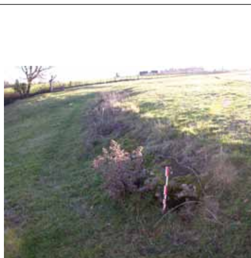
MORNANT Près du chemin de l'Orémus Voûte partiellement effondrée Cliché : C. Coquidé, Inrap, 2006
