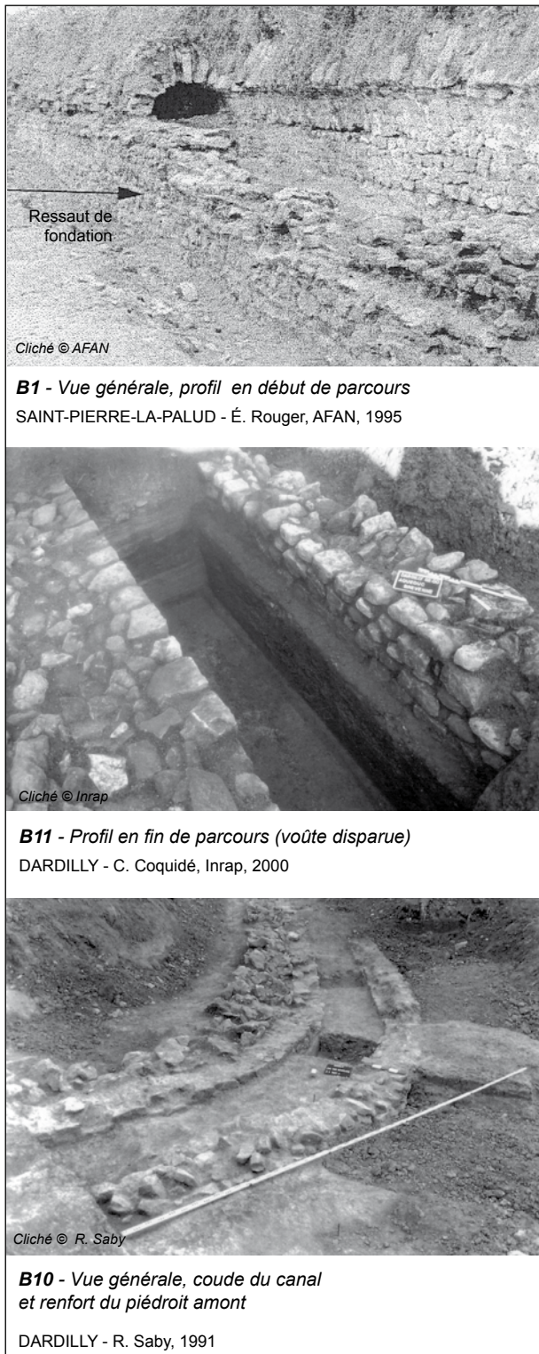
Fig. 8. Aqueduc de la Brévenne, vues d'ensemble.
