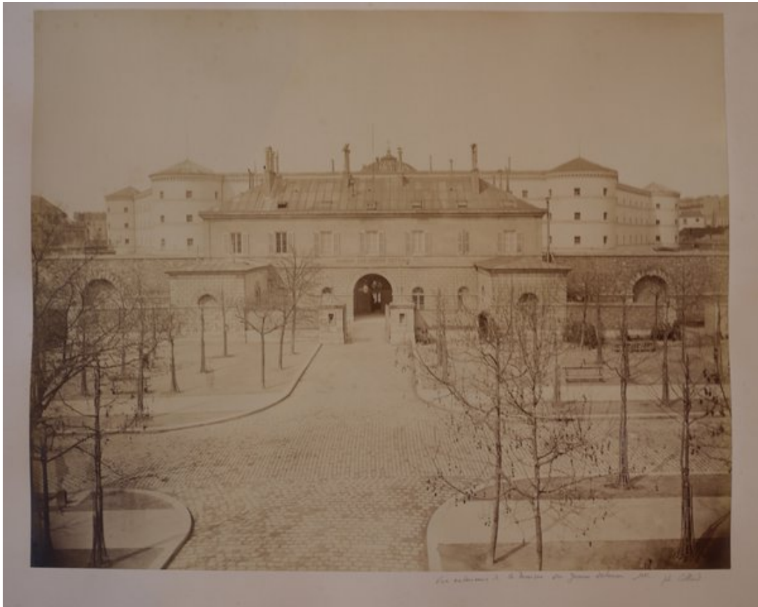
Façade de la Petite Roquette (H.-A. Collard, 1875)
