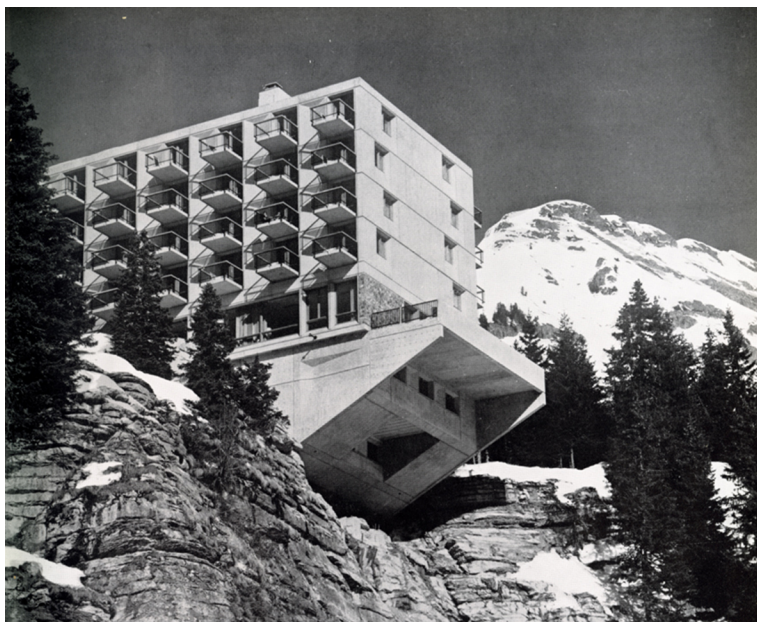
Hôtel Le Flaine, station de Flaine (Haute-Savoie), Marcel Breuer architecte, vue ancienne. Repro. Delorme, Franck. © Franck Delorme.
