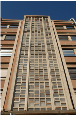
Claustra sur la façade d'un bâtiment de laboratoires et travaux pratiques de chimie. Phot. Michel Dubau © Région Aquitaine, Inventaire général, 2008.
