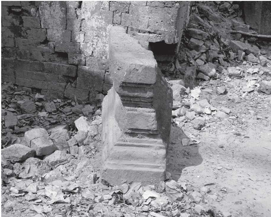
Fig. 22 Piédestal, gopura I Est du Prasat Chen (ph. auteur, 2009).
