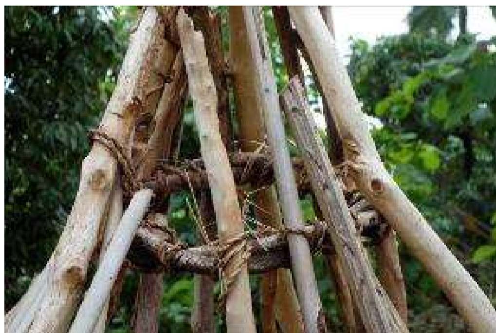
Figure 5. Anneau intérieur bunkar sur un toit endommagé, Orodara, 25 juin 2016.
