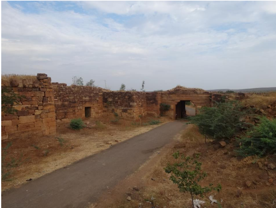
Figure 90 : façade de la porte Belgaum Agshi (6)
