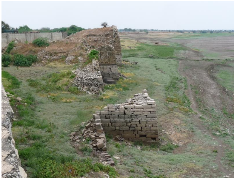
Figure 47 : Alampur (fortification Kakatyia), les fortifications anciennes protègent les temples 224
