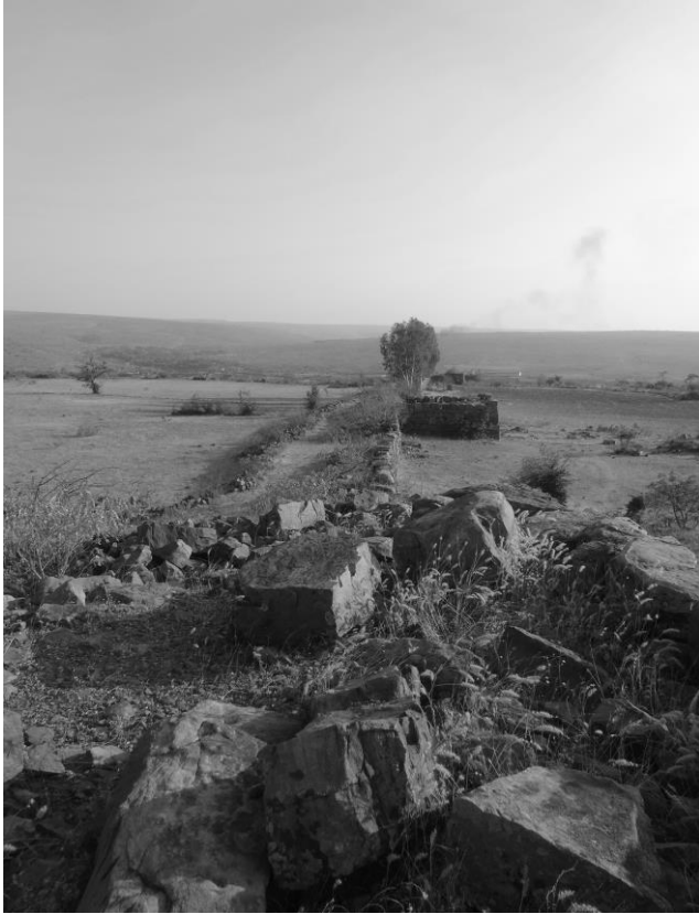
Figure 107 : la fortification avancée et ses tours montées en crémaillère. Le parapet est inexistant et la muraille est large et peu élevée. Une défense adaptée à la topographie abrupte de la colline
