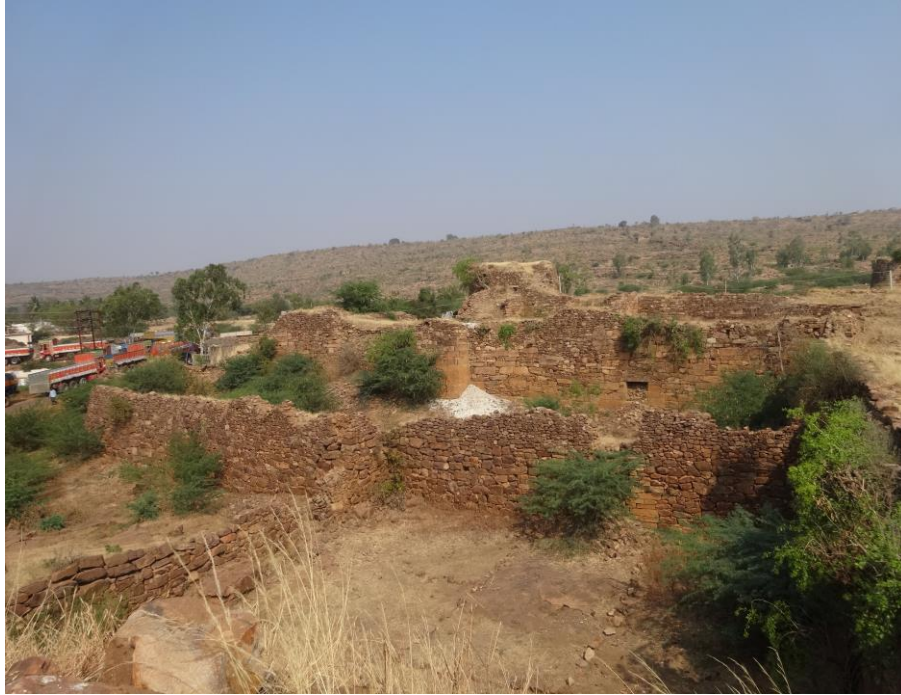
Figure 101 : vue depuis le sud du double mur défensif de la porte 6
