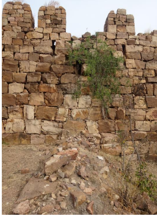
Figure 25 : l'aqueduc traverse l'enceinte fortifiée en direction de la ville. Le canal est aménagé au niveau de la courtine
