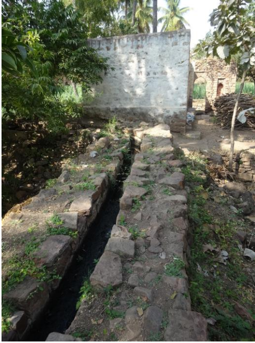
Figure 31 : canal d'irrigation A2
