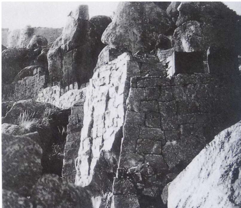
Figure 108 : système en crémaillère de l'enceinte sud de Rajagiri, Senji 336
