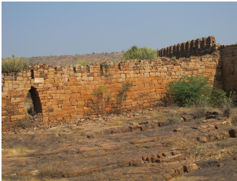
Figure 109 : un mur de clôture reliant l'enceinte intérieure et la seconde enceinte coupe la fausse braye en orientant ses ouvertures de tirs vers le sud, partie de la fortification jugée plus faible depuis la destruction Bahmani des tours 57-58. La voûte de la porte en tas de charge est caractéristique des fortifications Vijayanagara
