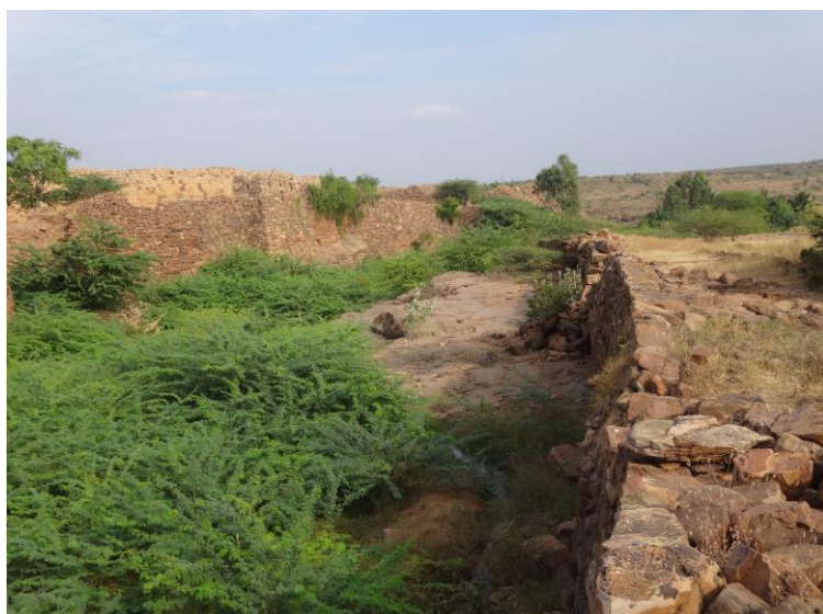
Figure 64 : vue de la contrescarpe sud
