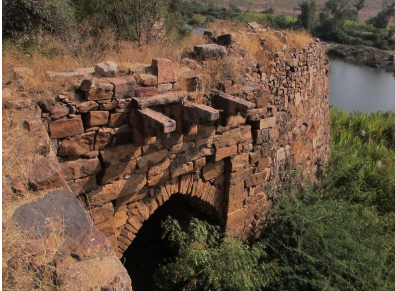
Figure 120 : porte/poterne 20 surmontée d'une bretèche
