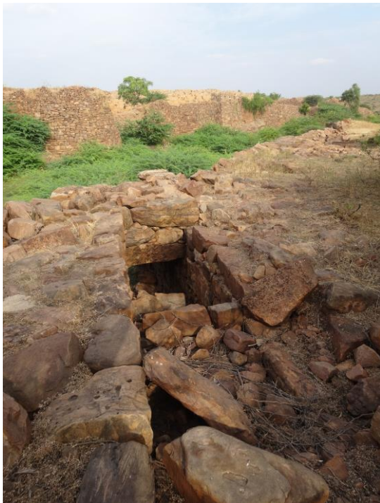
Figure 113 : escalier, contrescarpe sud
